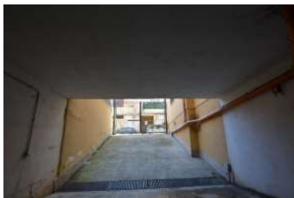
Foto 4 - Rampa carrabile di Via Andrea Doria, 22
