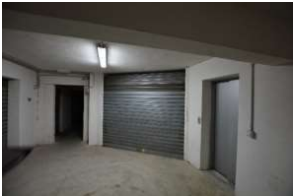
Foto 7 - Ingresso magazzino da corsia di manovra
