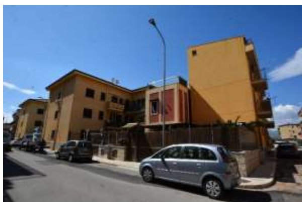
Foto 1 - Palazzina di Via Andrea Doria
