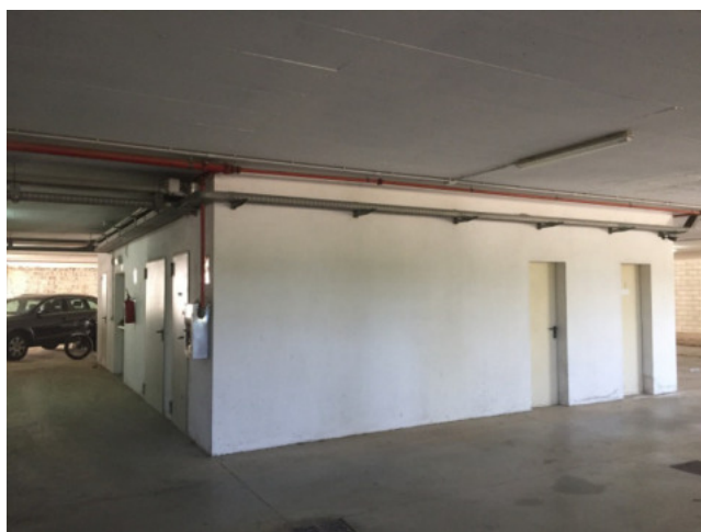
vista dei locali di deposito
