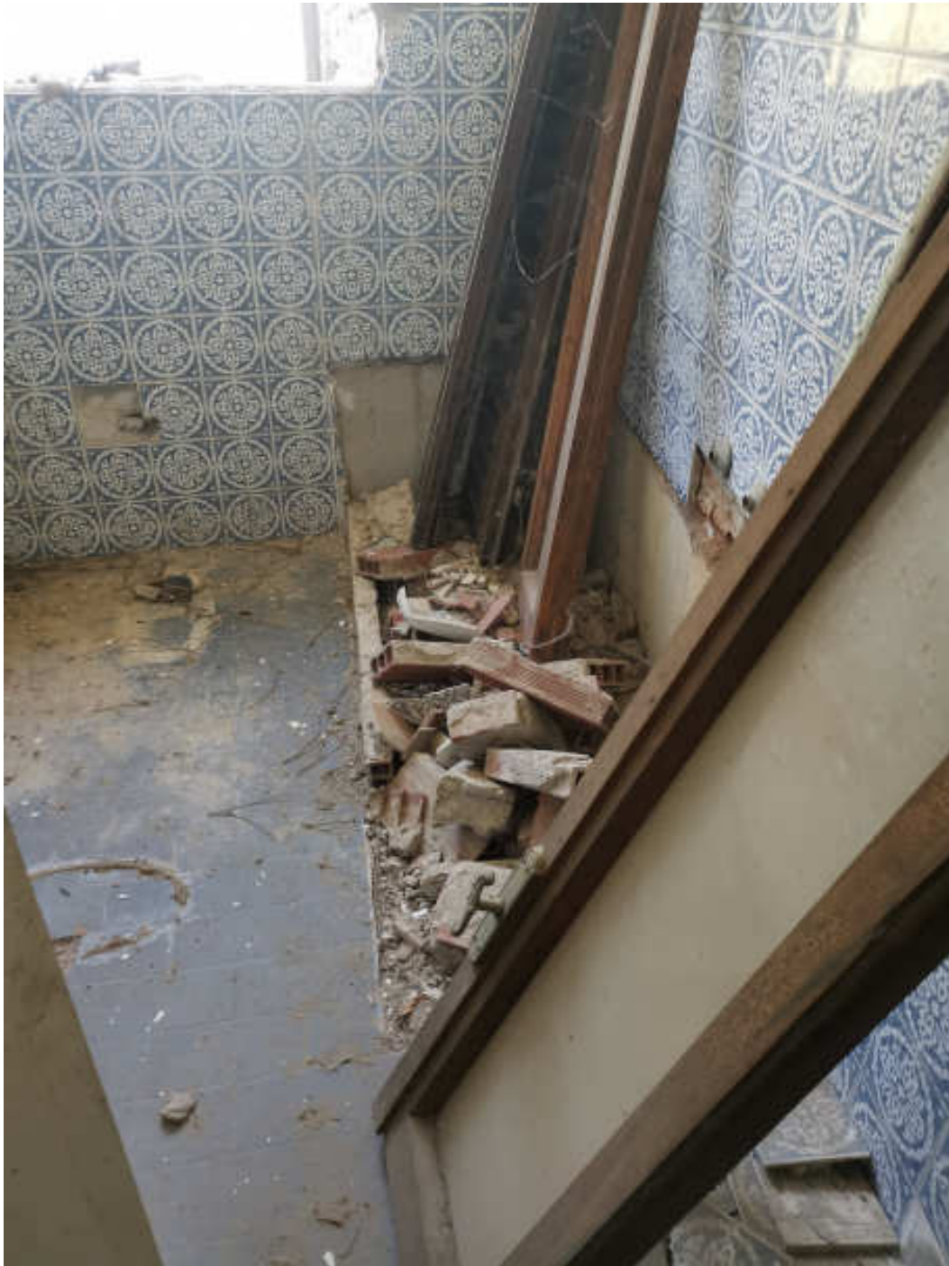
FOTO INTERNI – SERVIZIO IGIENICO PIANO PRIMO
