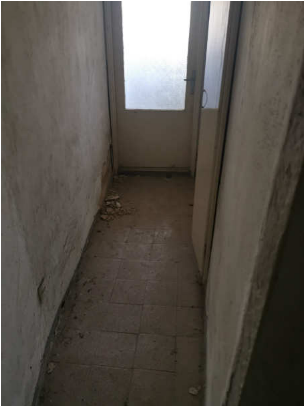
FOTO INTERNI - ANTI BAGNO PIANO PRIMO
