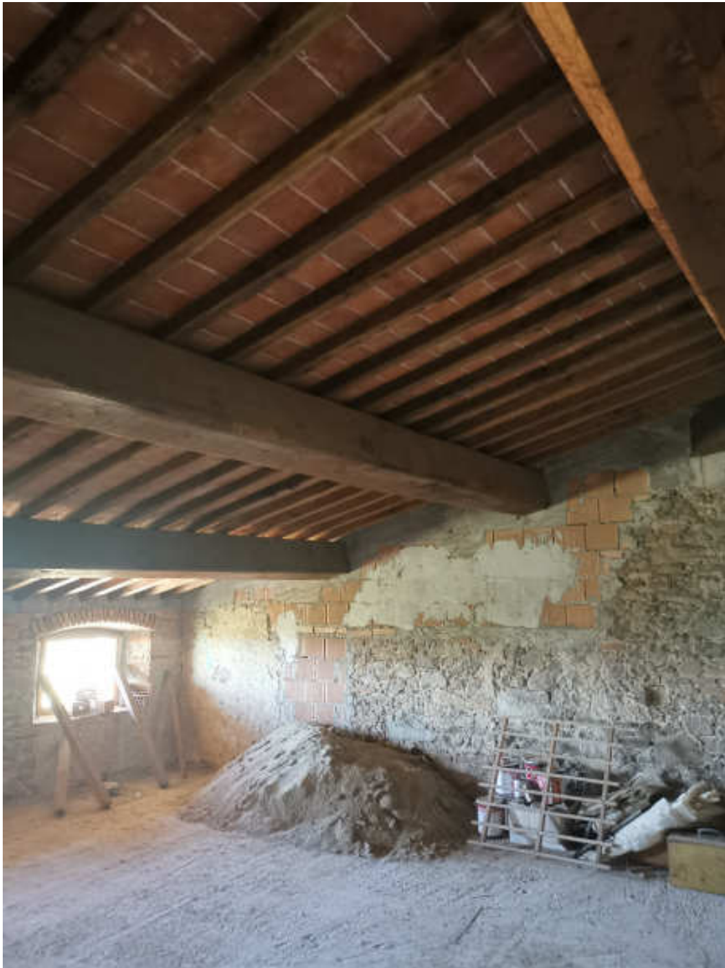
FOTO INTERNI - PIANO SOTTOTETTO
