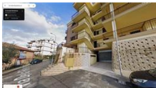
RAMPA INGRESSO AUTORIMESSA COLLETTIVA
