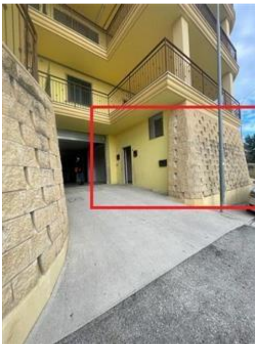
INGRESSO PEDONALE DA PORTA BLINDATA
