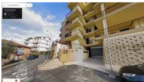
ingresso rampa condominiale
