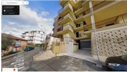
INGRESSO AL PIANO SOTTOSTRADA DA RAMPA CONDOMINIALE
