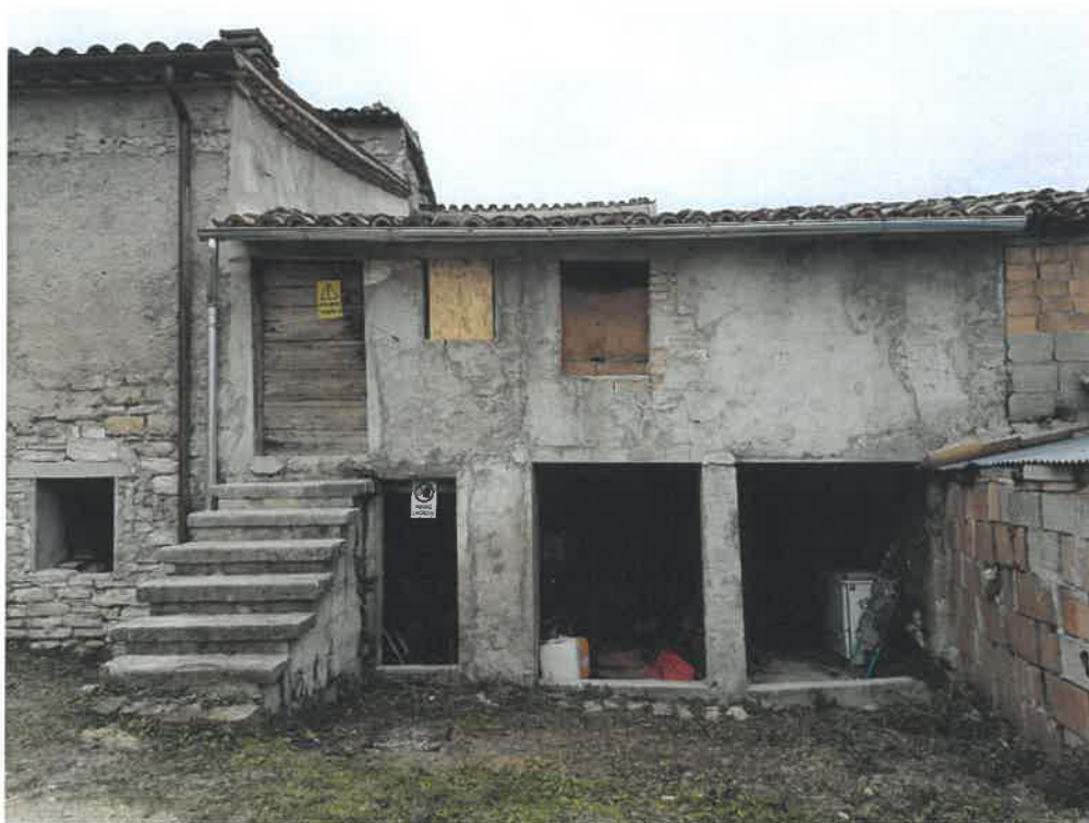
Foto 01 – Unità collabente (esterni)
