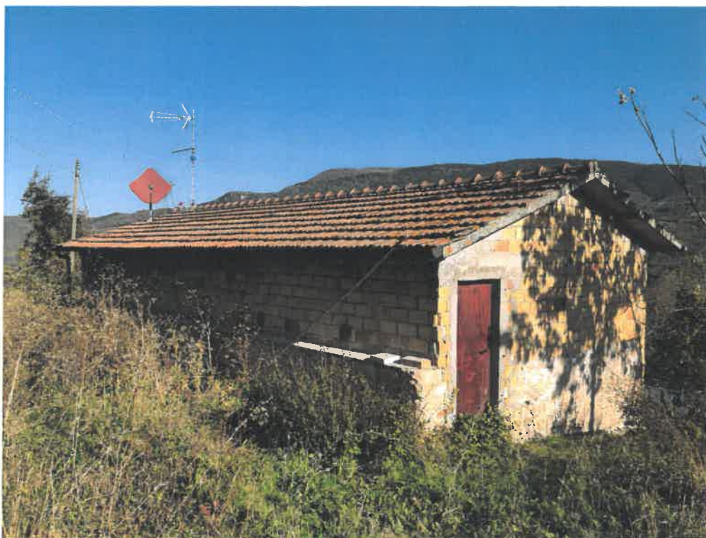
Foto 08 – Annesso 1 (esterni - piano terra da demolire)
