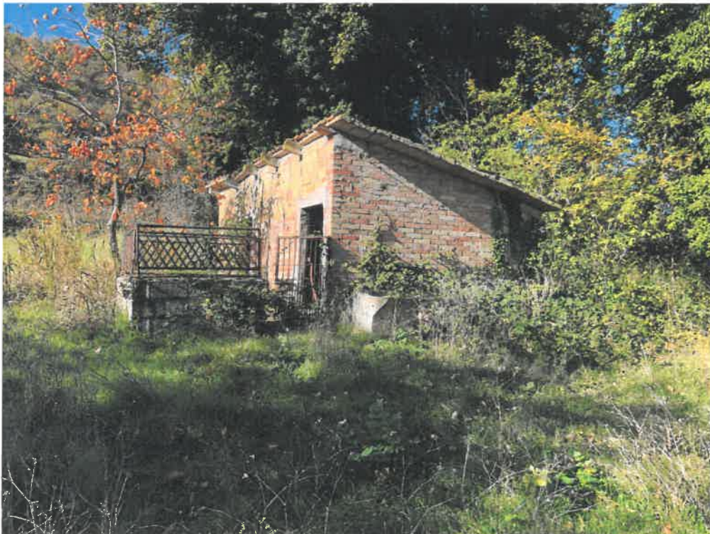
Foto 11 – Annesso 2 (da demolire)
