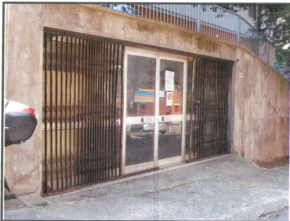
Foto n. 4 Accesso principale al magazzino.
