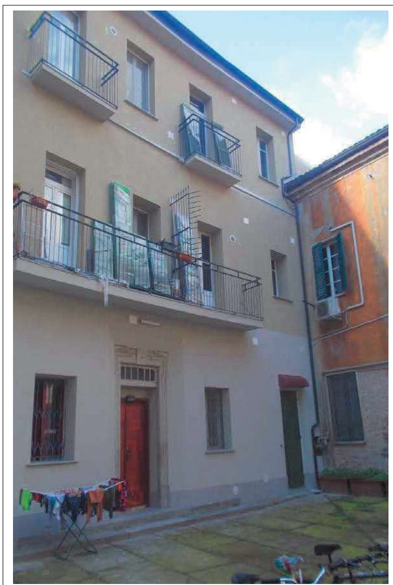
Fotografia n. 2 = Vista del prospetto NORD della porzione condominiale interessata
