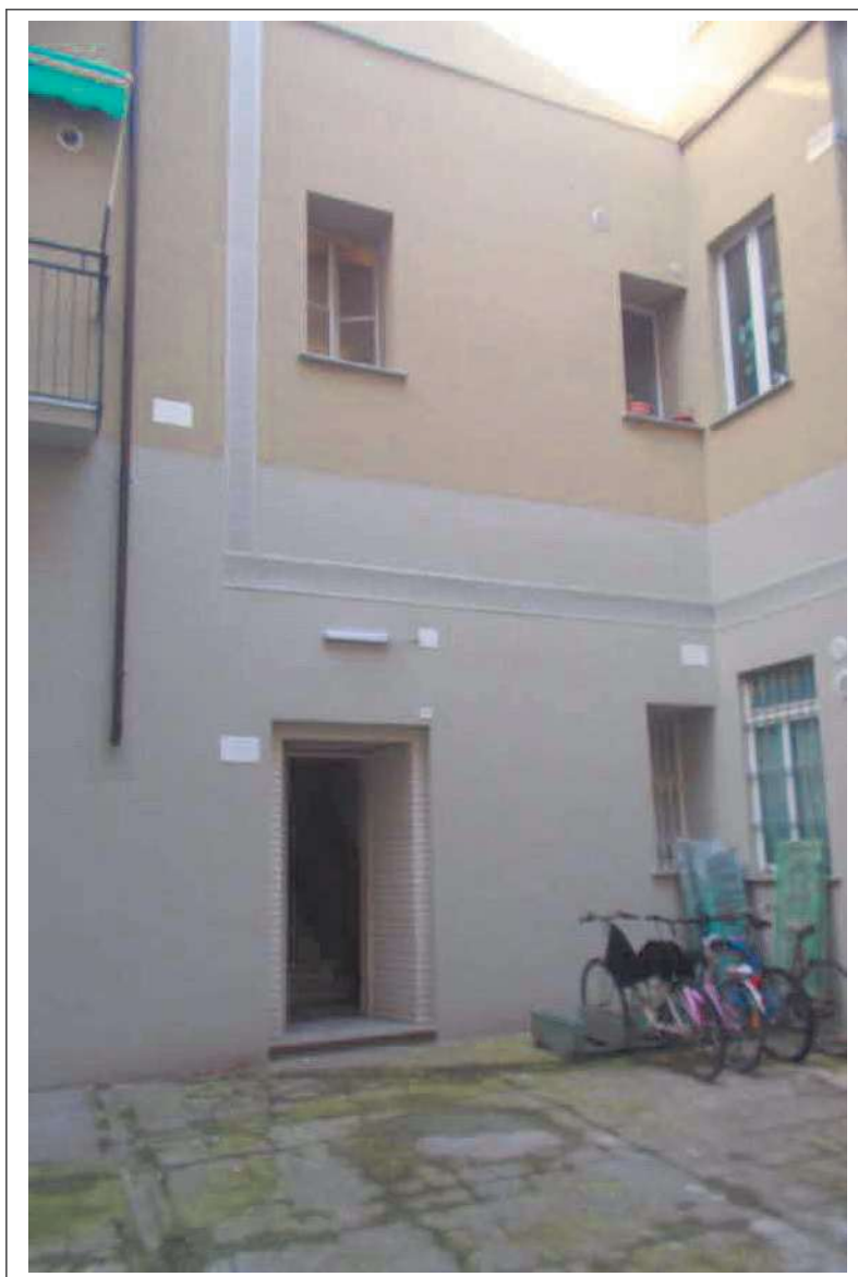
Fotografia n. 1 = Vista dell'ingresso della porzione condominiale interessata
