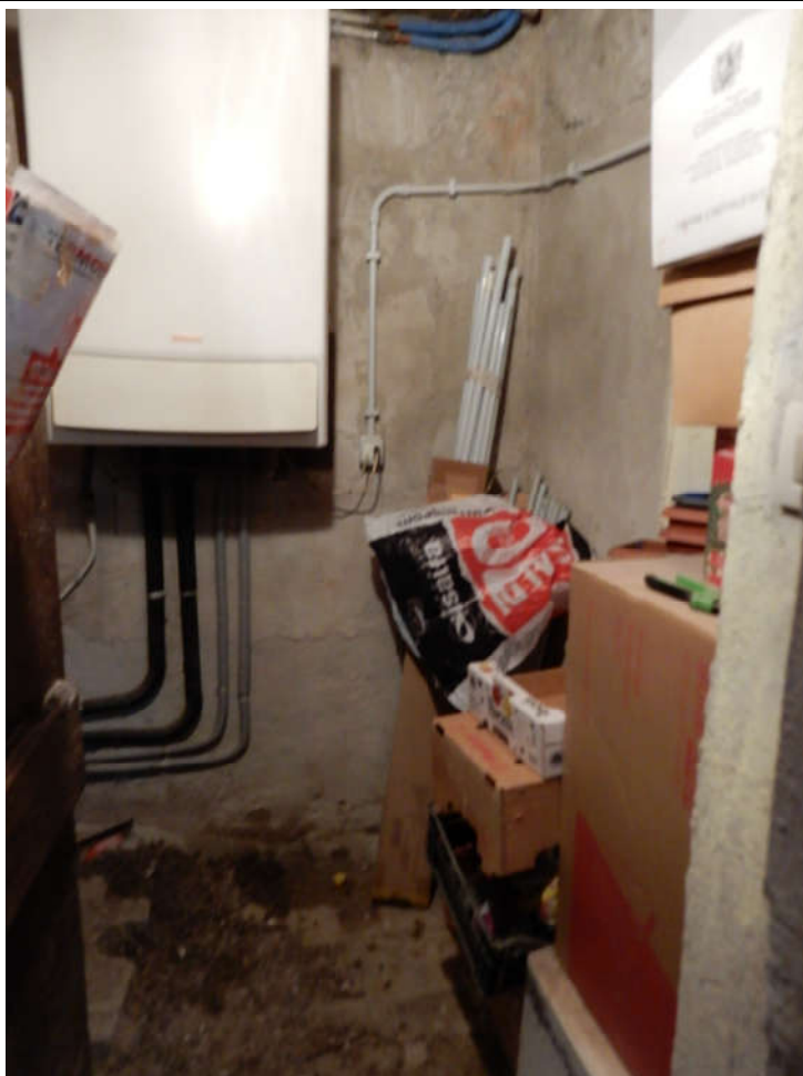
Piano seminterrato - cantina
