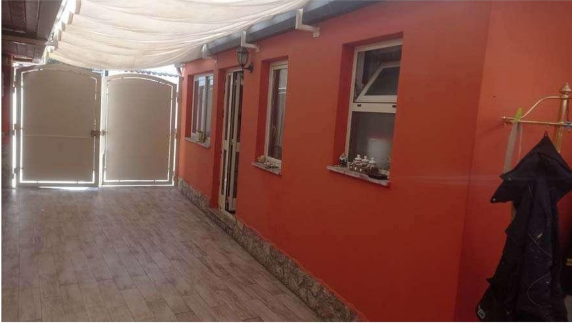
Foto n.5 - Vista dall'interno della corte – Sulla destra l'immobile oggetto dell'Ordinanza di demolizione
