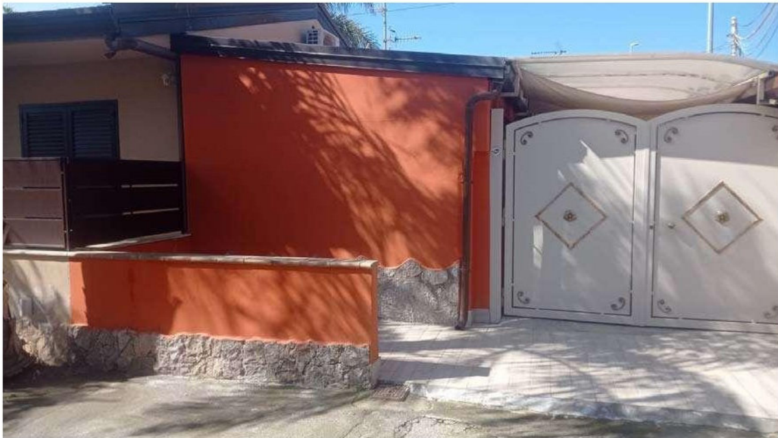
Foto n.4 - Ingresso all'immobile dalla stradella privata
