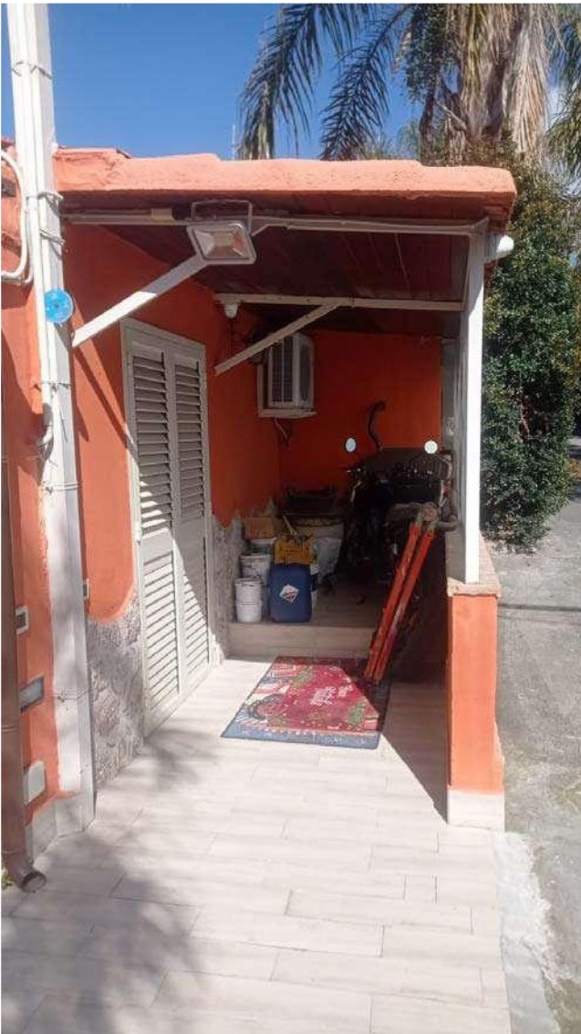
Foto n.19 – Tettoia su ingresso dalla stradella
