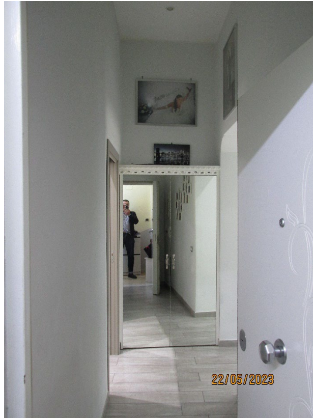
Fotografia 26 – Ingresso: La pavimentazione è costituita per tutta la sua superficie da piastrelle in gres porcellanato; le pareti sono rivestite con intonaci ordinari a finitura liscia e tinteggiate con pittura lavabile; il soffitto è rivestito anch'esso con intonaci ordinari a finitura liscia, tinteggiato con pittura a tempera.
