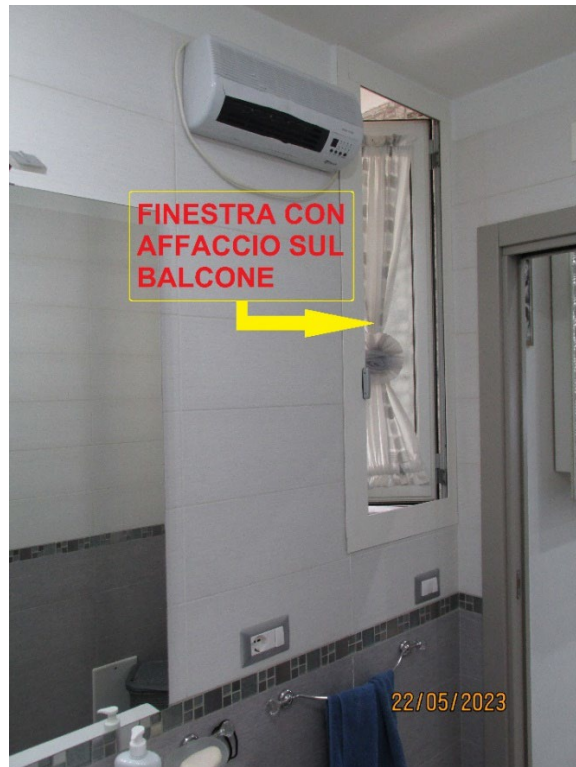
Fotografia 35 – Bagno 1: Il soffitto è costituito da un'orditura metallica rivestita con pannelli in cartongesso tinteggiati con pittura traspirante su cui è stato ricavato un "ripostiglio in quota" accessibile dalla "Cucina/Soggiorno". L'ambiente dispone di una finestra con affaccio sul "Balcone" annesso all'appartamento.
