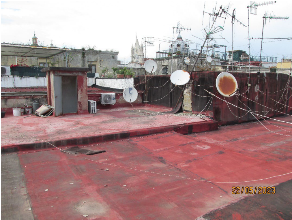
Fotografia 56 – Lastrico Solare: Il Lastrico Solare occupa una superficie utile calpestabile pari a mq. 76,64 e risulta interamente pavimentato con guaina bituminosa, tinteggiata con vernice acrilica protettiva.
