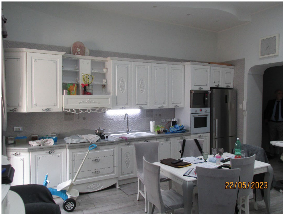
Fotografia 32 – Cucina/Soggiorno: lungo una parete è sistemato l'angolo cottura, rivestito con piastrelle di ceramica smaltata. Il soffitto dell'intero ambiente è rivestito con intonaci ordinari a finitura liscia, tinteggiato con pittura a tempera, ad eccezione della zona sovrastante l'angolo cottura che presenta una controsoffittatura in cartongesso munita di faretti.
