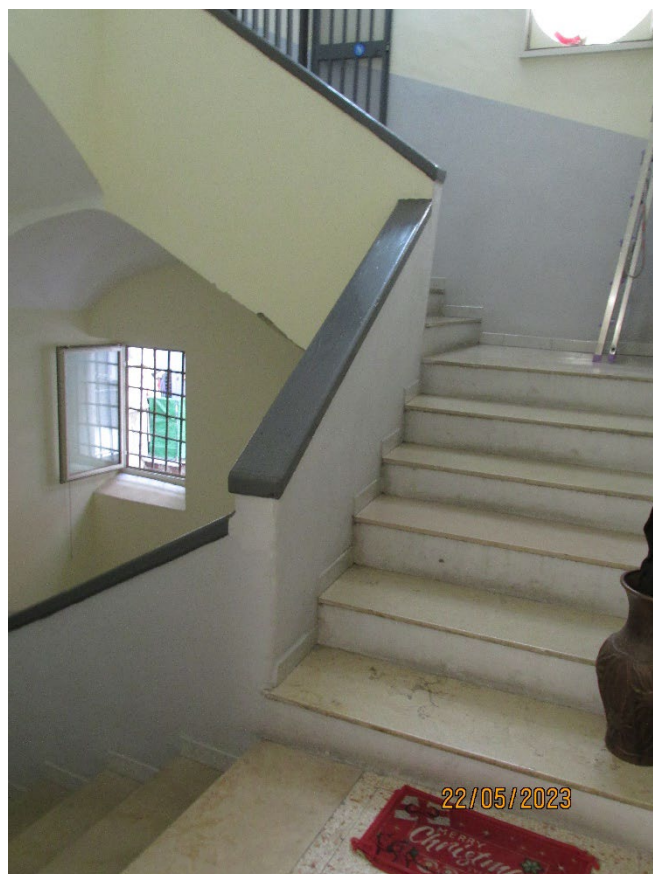
Fotografia 20 – Il vano scala è dotato di finestre protette esternamente da grate in ferro e internamente da serramenti in alluminio con vetrate, per garantire il riciclo dell'aria e l'ingresso di luce naturale.
