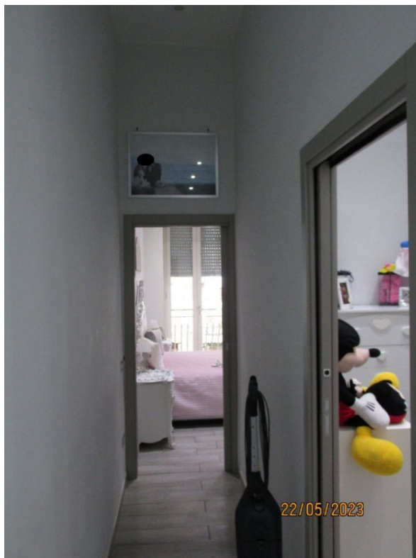
Fotografia 38 – Disimpegno: Vi si accede dalla “Cucina/Soggiorno” e comunica con il “Vano 2” e con il “Vano 3”, occupa una superficie utile netta pari a mq. 3,10 ed un’altezza dal piano di calpestio di ml. 3,60. La pavimentazione è costituita da piastrelle in gres porcellanato; le pareti rivestite con intonaci ordinari a finitura liscia e tinteggiate con pittura lavabile; il soffitto rivestito con intonaci ordinari a finitura liscia e tinteggiato con pittura a tempera.
