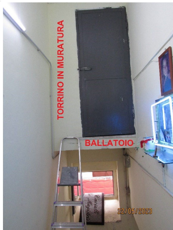
Fotografia 53 – Lastrico Solare: tramite l'apertura di un serramento in ferro, consente l'accesso al ballatoio del torrino in muratura.
