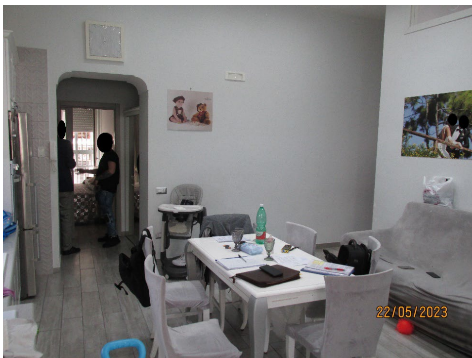
Fotografia 31 – Cucina/Soggiorno: La pavimentazione è costituita da piastrelle in gres porcellanato; le pareti sono rivestite con intonaci ordinari a finitura liscia e tinteggiate con pittura lavabile.
