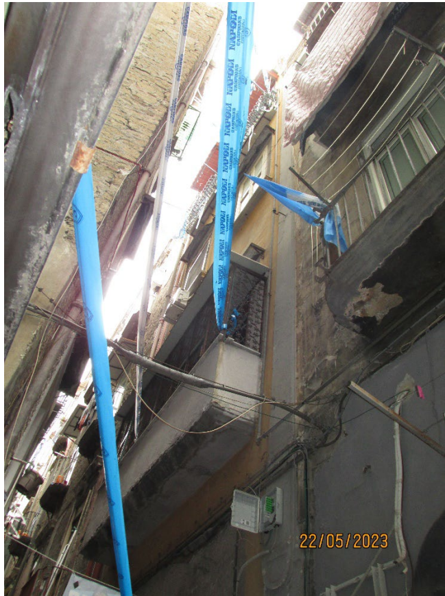
Fotografia 9 – Vista fabbricato da Vico Maiorani.
