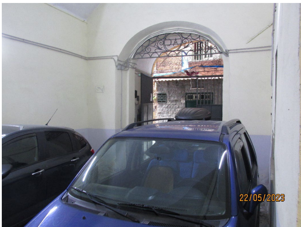
Fotografia 12 – Androne coperto altra vista.
