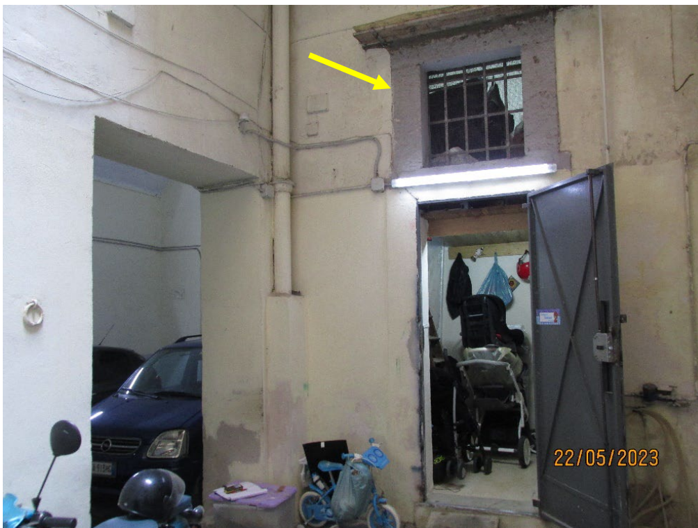
Fotografia 51 – Locale Deposito: Il locale è dotato di una finestra protetta con grate in ferro posta sopra la porta d'ingresso.
