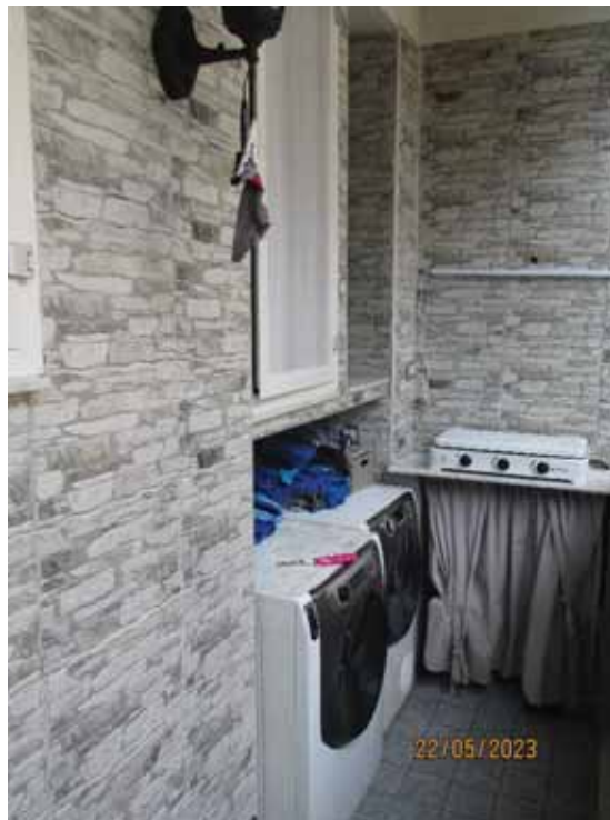
Fotografia 37 – Balcone: La parete è rivestita con piastrelle in finta pietra su cui è stato ricavato un piccolo ripostiglio chiuso da un’anta in alluminio, inoltre risulta installato un attacco di acqua e scarico a servizio di una lavabiancheria, oltre ad un punto di attacco gas per l’alimentazione di un piccolo fornellino.
