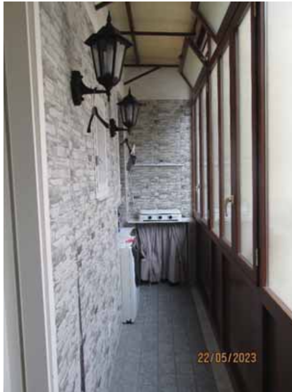
Fotografia 36 – Balcone: Vi si accede dalla “Cucina/Soggiorno”, occupa una superficie utile netta pari a mq. 5,50 ed è esposto lungo il versante sud con affaccio sul cortile condominiale del fabbricato civico 39. La pavimentazione è in ceramica smaltata, risulta interamente verandato da una struttura in alluminio effetto legno munita di ampie finestre con vetri temperati, inoltre dispone di una copertura costituita da onduline in pvc sorrette da una struttura in ferro ancorata alla parete perimetrale.
