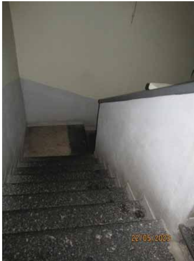
Fotografia 18 – Le pedate fino al secondo ballatoio sono rivestite con lastre in piperno vesuviano.
