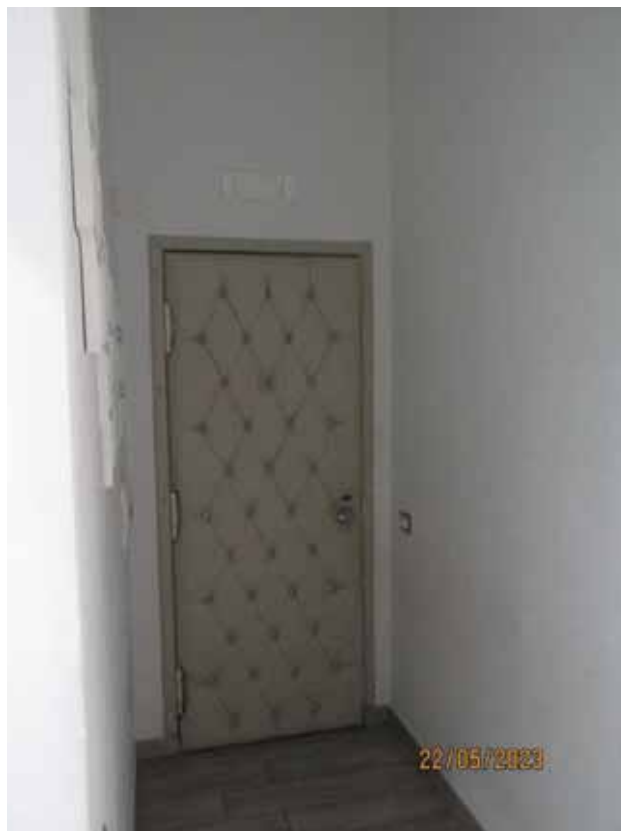
Fotografia 25 – Ingresso: Occupa una superficie utile netta pari a mq. 3,93 ed un'altezza dal piano di calpestio di ml. 3,60.
