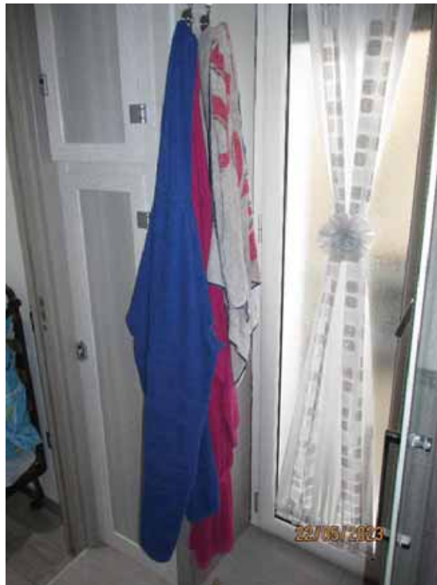
Fotografia 47 – Bagno 2: L'ambiente è dotato di una porta-finestra con oggetto alla "romana" da cui prende aria e luce, è protetto esternamente da una ringhiera in ferro ed internamente di infisso in alluminio con vetri camera, la finestra affaccia su Vico dei Maiorani.
