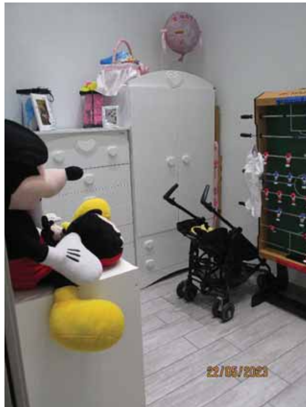
Fotografia 40 – Vano 2: La pavimentazione è costituita da piastrelle in gres porcellanato; le pareti rivestite con intonaci ordinari a finitura liscia e tinteggiate con pittura lavabile; il soffitto rivestito con intonaci ordinari a finitura liscia e tinteggiato con pittura a tempera. L’ambiente non dispone di finestre verso l’esterno.
