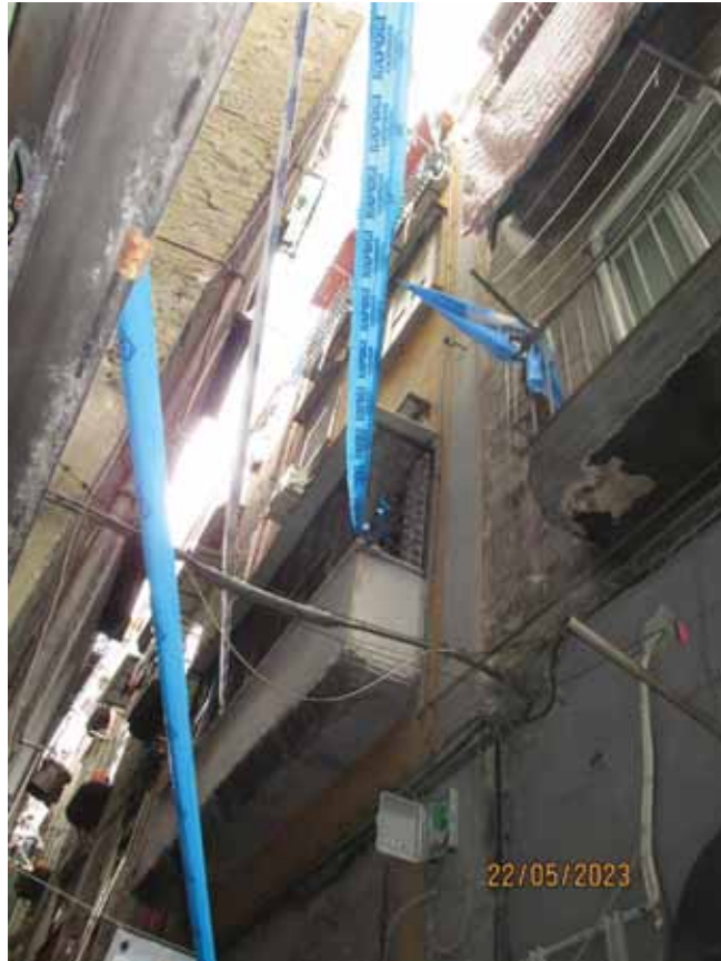
Fotografia 9 – Vista fabbricato da Vico Maiorani.
