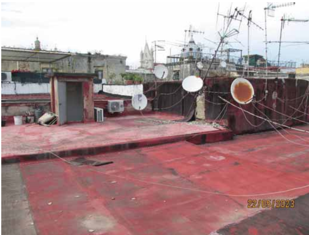
Fotografia 56 – Lastrico Solare: Il Lastrico Solare occupa una superficie utile calpestabile pari a mq. 76,64 e risulta interamente pavimentato con guaina bituminosa, tinteggiata con vernice acrilica protettiva.
