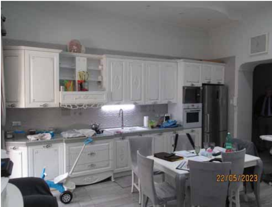
Fotografia 32 – Cucina/Soggiorno: lungo una parete è sistemato l'angolo cottura, rivestito con piastrelle di ceramica smaltata. Il soffitto dell'intero ambiente è rivestito con intonaci ordinari a finitura liscia, tinteggiato con pittura a tempera, ad eccezione della zona sovrastante l'angolo cottura che presenta una controsoffittatura in cartongesso munita di faretti.
