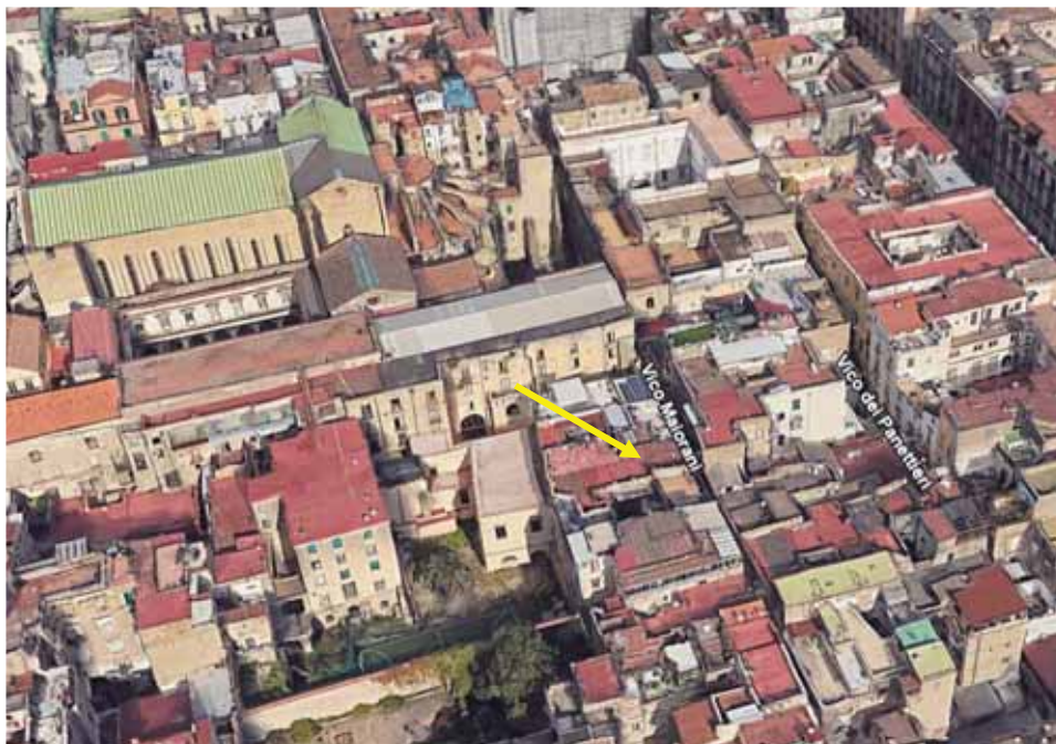
Fotografia 2 – Inquadramento territoriale lato Sud.
