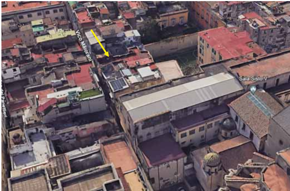
Fotografia 3 – Inquadramento territoriale lato Nord.
