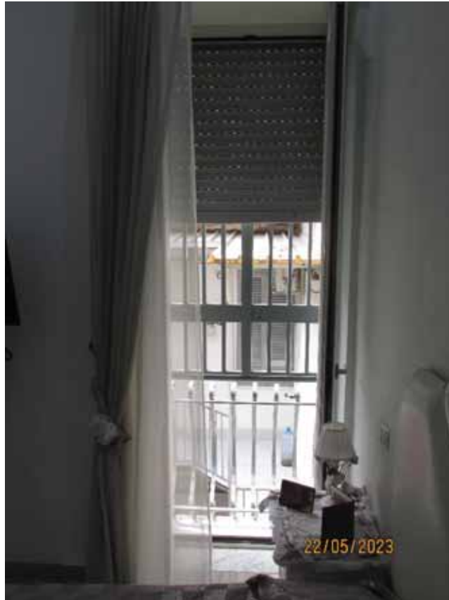
Fotografia 29 – Vano 1: L’ambiente è dotato di una porta-finestra con oggetto alla “romana” da cui prende aria e luce, protetta esternamente da una inferriata, la stessa affaccia sul cortile condominiale del fabbricato del civico 43, l’apertura è munita di infisso in alluminio con vetri camera.
