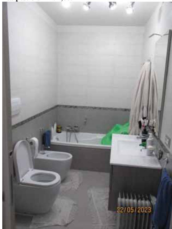
Fotografia 34 – Bagno 1 : L’ambiente è dotato di tazza igienica, lavabo, bidet e vasca da bagno. La pavimentazione è costituita per tutta la sua superficie da piastrelle in ceramica smaltata; le pareti sono rivestite con piastrelle di ceramica smaltata fino ad un’altezza di ml 2,50 dal piano di calpestio, mentre la restante parte risulta rivestita con intonaci ordinari a finitura liscia tinteggiate con pittura lavabile.
