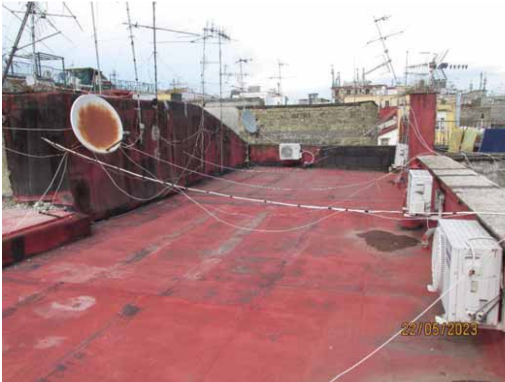
Fotografia 57 – Lastrico Solare: Sui confini esterni sono presenti muretti di diverse altezze che fanno da recinzione verso il vuoto e sono utilizzati per sorreggere antenne e pompe di calore a servizio delle unità immobiliari che insistono nel fabbricato; infatti, sul Lastrico Solare ci sono numerosi cavi in attraversamenti aereo.
