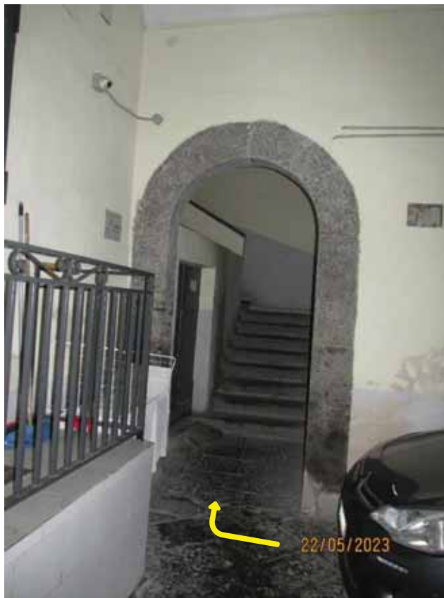
Fotografia 14 – L’androne inoltre, presenta un ulteriore varco pedonale in fondo a destra che consente l’accesso alla scala condominiale.
