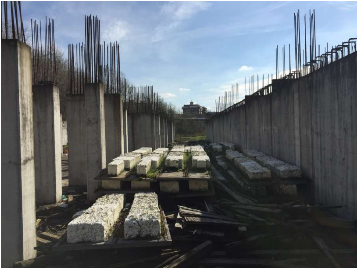
Foto 19 - Area urbana in corso di costruzione
