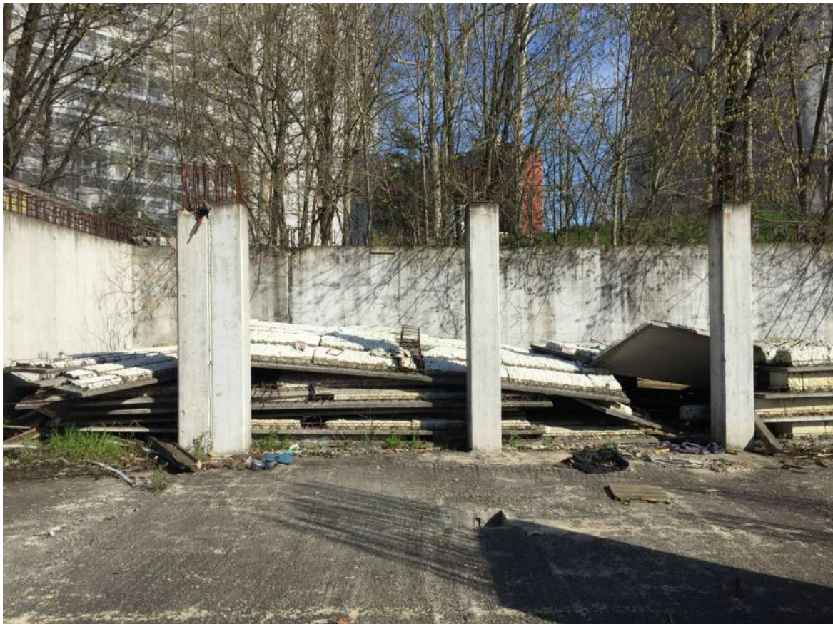
Foto 21 - Area urbana in corso di costruzione
