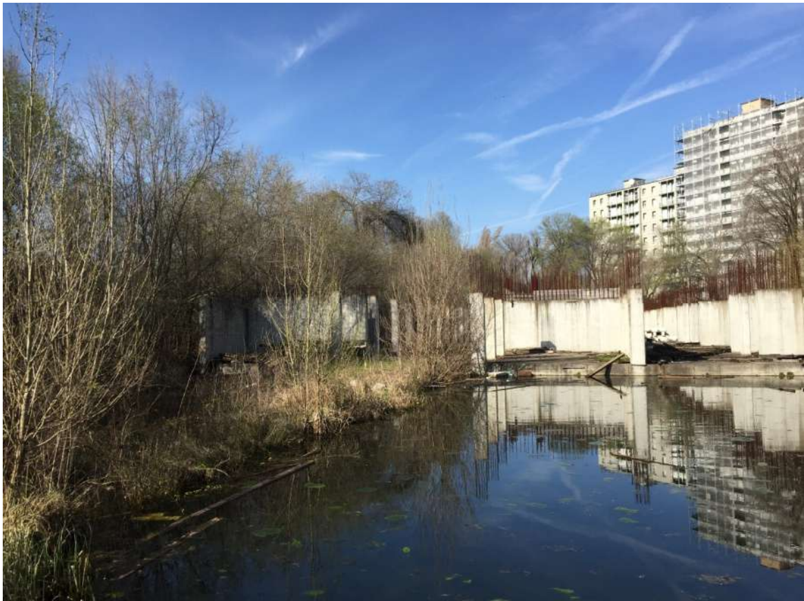
Foto 07 - Area urbana in corso di costruzione
