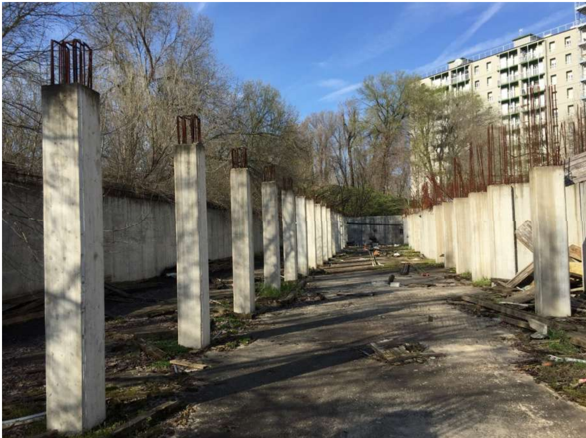
Foto 17 - Area urbana in corso di costruzione
