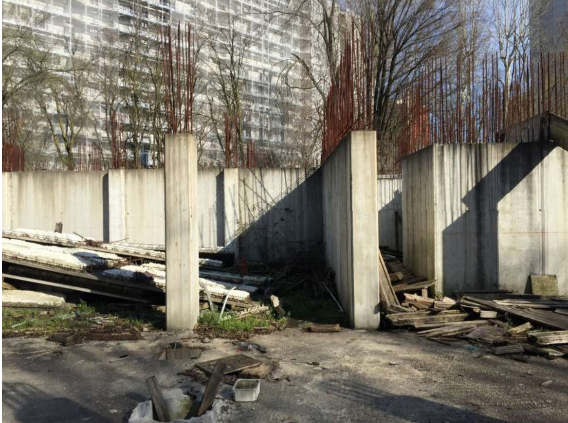
Foto 32 - Area urbana in corso di costruzione
