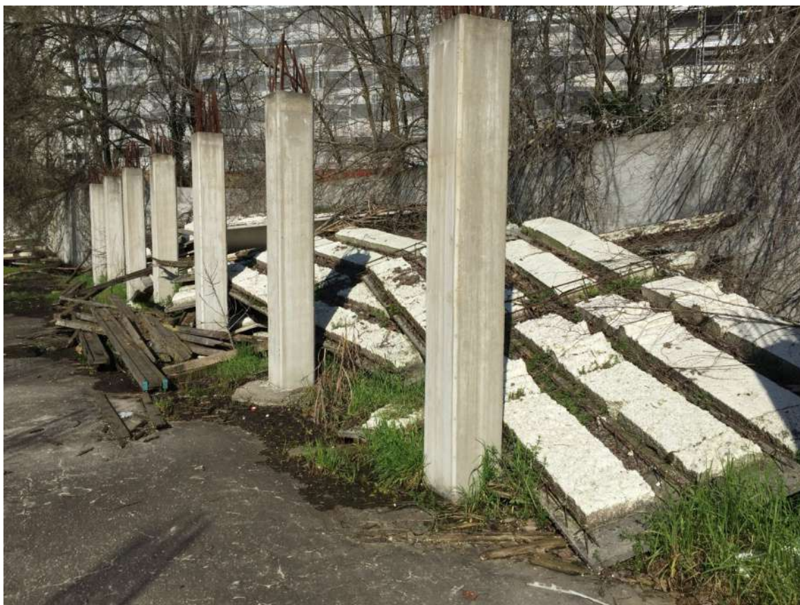
Foto 23 - Area urbana in corso di costruzione
