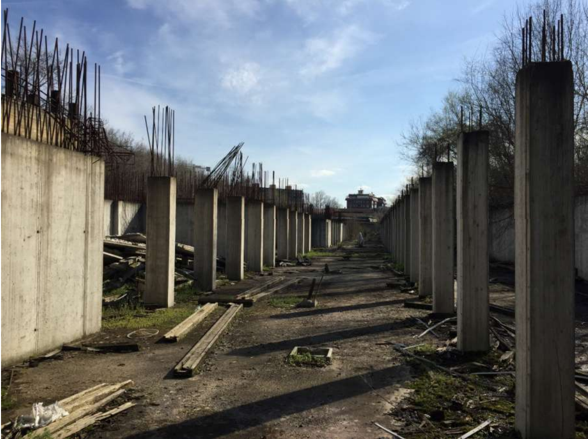
Foto 28 - Area urbana in corso di costruzione
