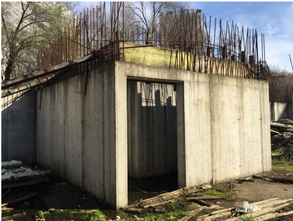
Foto 30 - Vano scale in corso di costruzione
