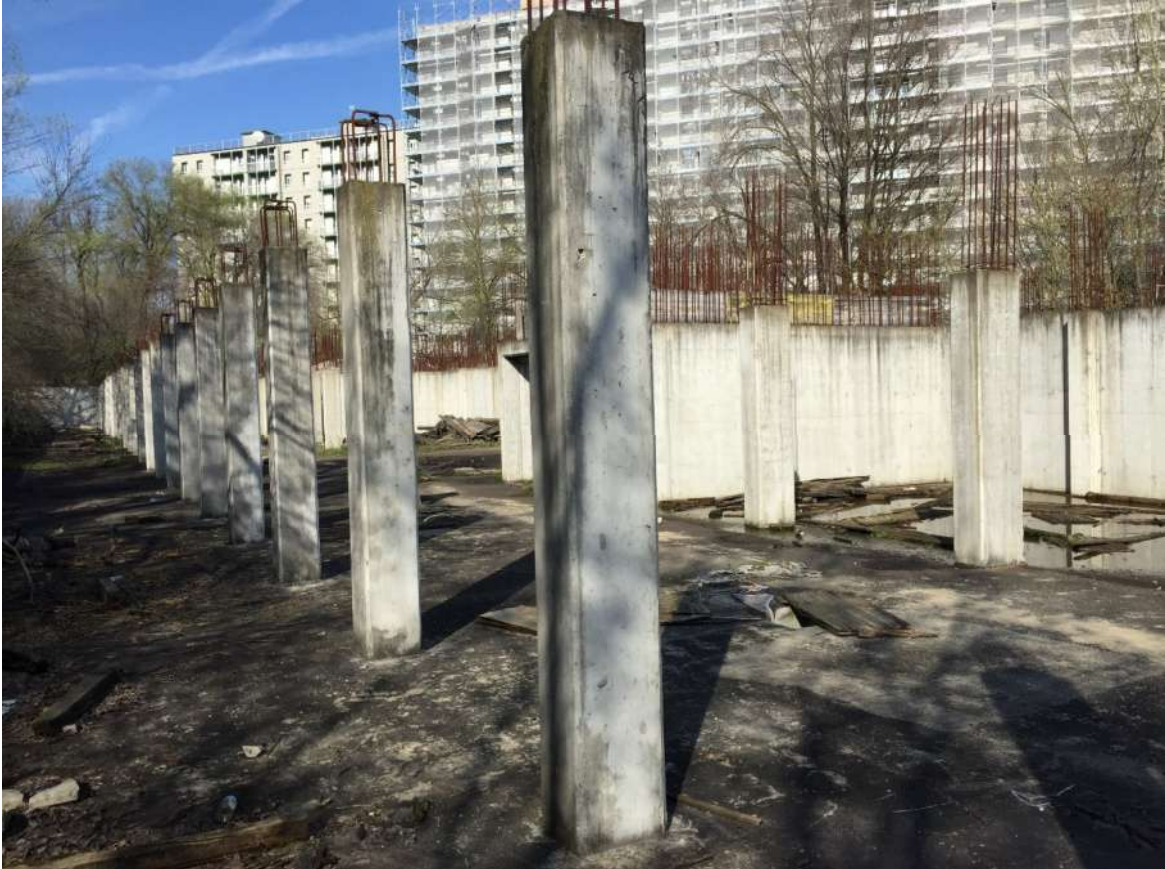
Foto 14 - Area urbana in corso di costruzione
