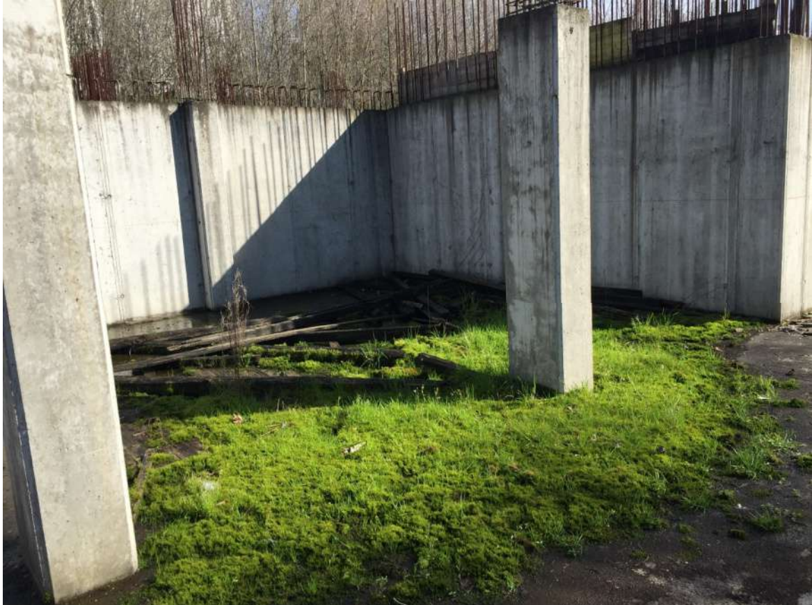
Foto 34 - Area urbana in corso di costruzione
