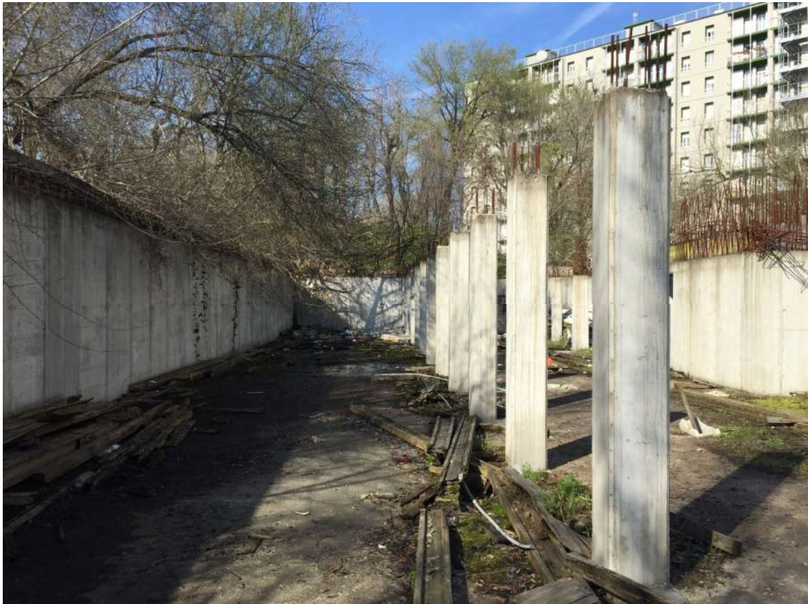
Foto 33 - Area urbana in corso di costruzione
