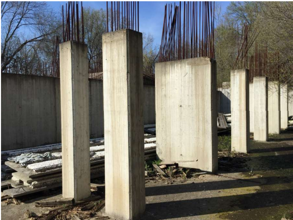
Foto 25 - Area urbana in corso di costruzione
