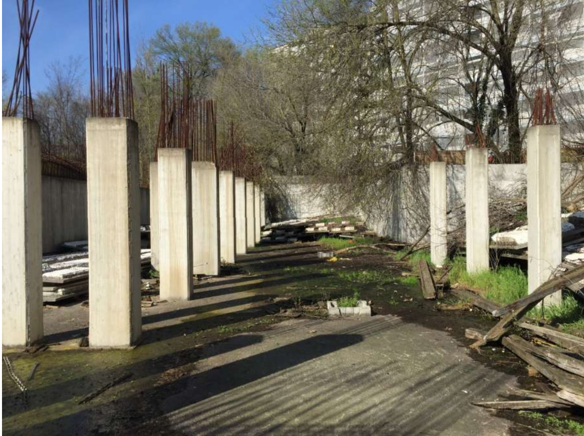
Foto 24 - Area urbana in corso di costruzione
