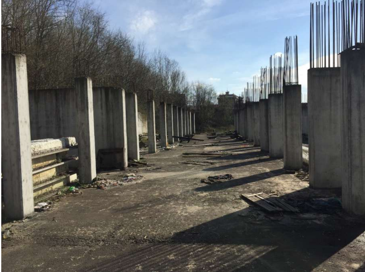
Foto 20 - Area urbana in corso di costruzione
