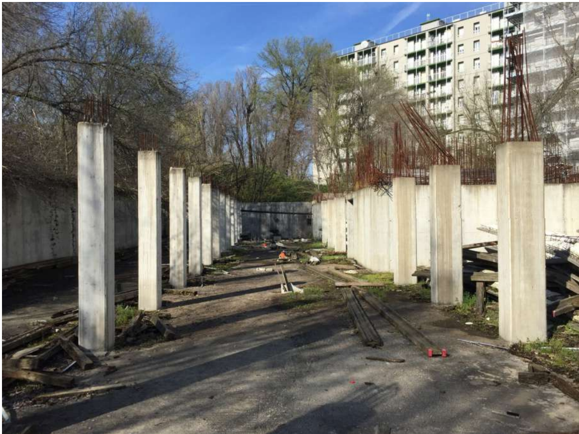
Foto 27 - Area urbana in corso di costruzione
