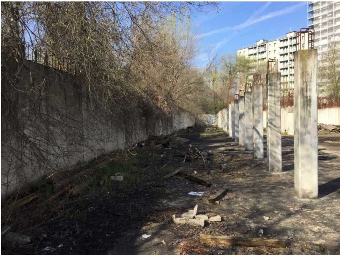
Foto 13 - Area urbana in corso di costruzione
