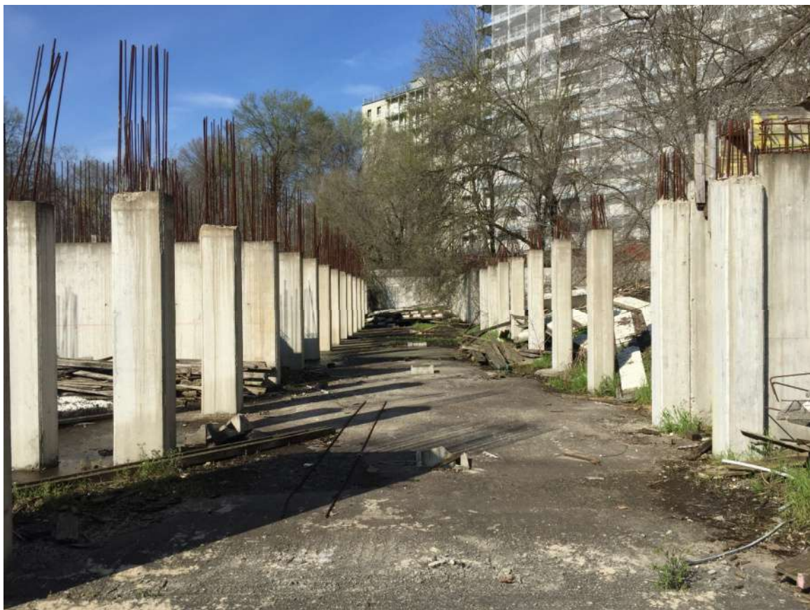
Foto 22 - Area urbana in corso di costruzione
