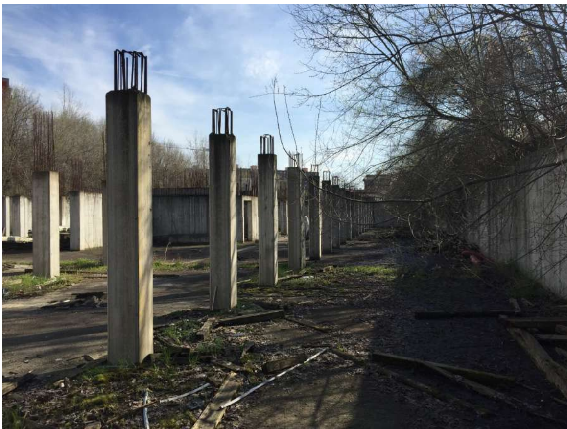
Foto 31 - Area urbana in corso di costruzione
