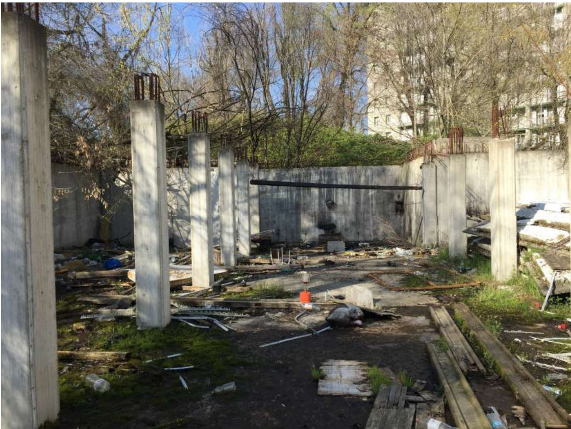
Foto 29 - Area urbana in corso di costruzione
