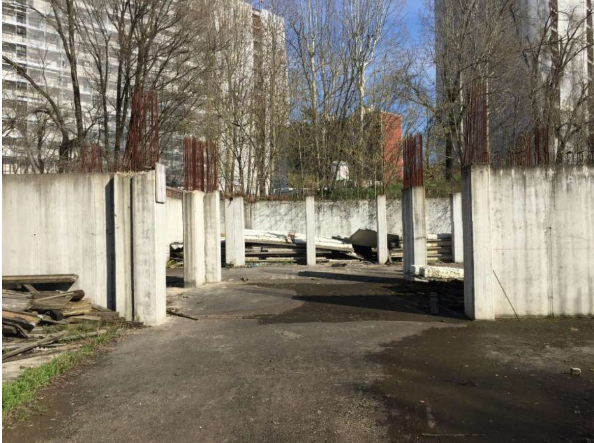
Foto 18 - Area urbana in corso di costruzione
