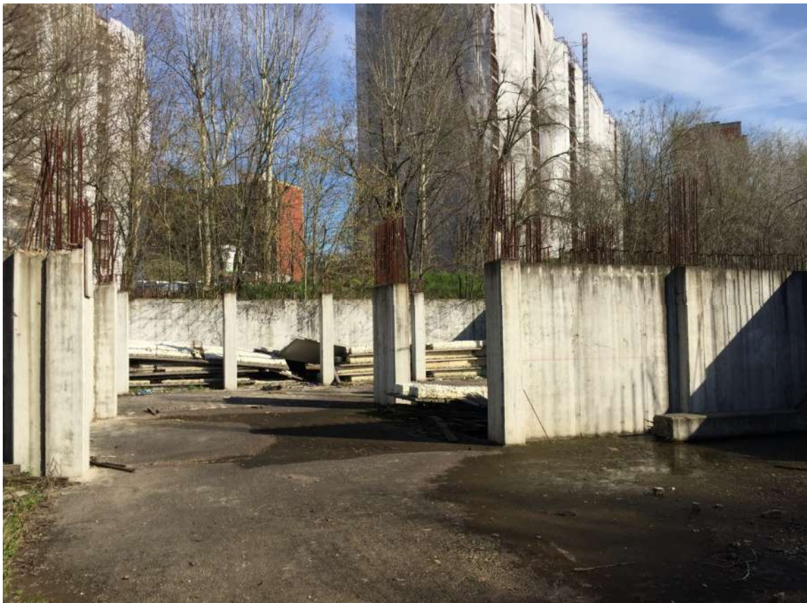
Foto 35 - Area urbana in corso di costruzione
