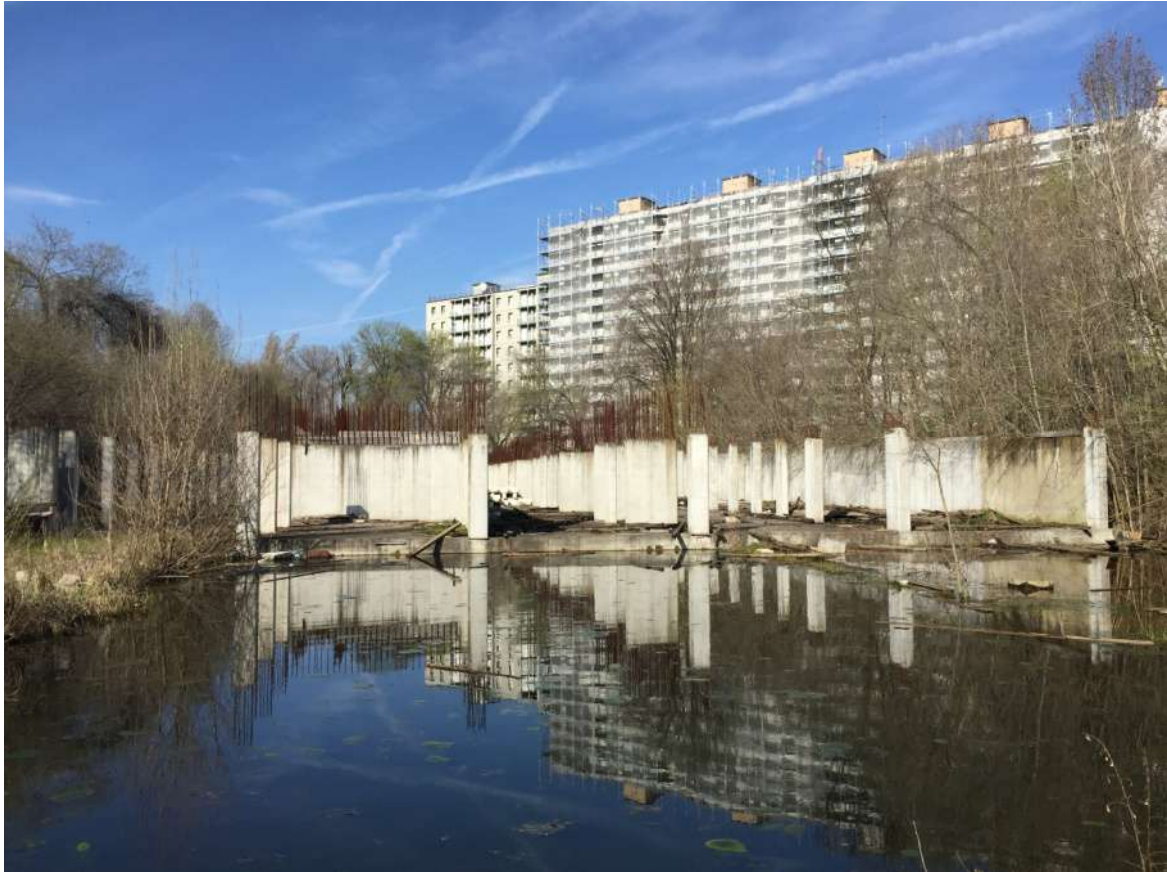
Foto 08 - Area urbana in corso di costruzione
