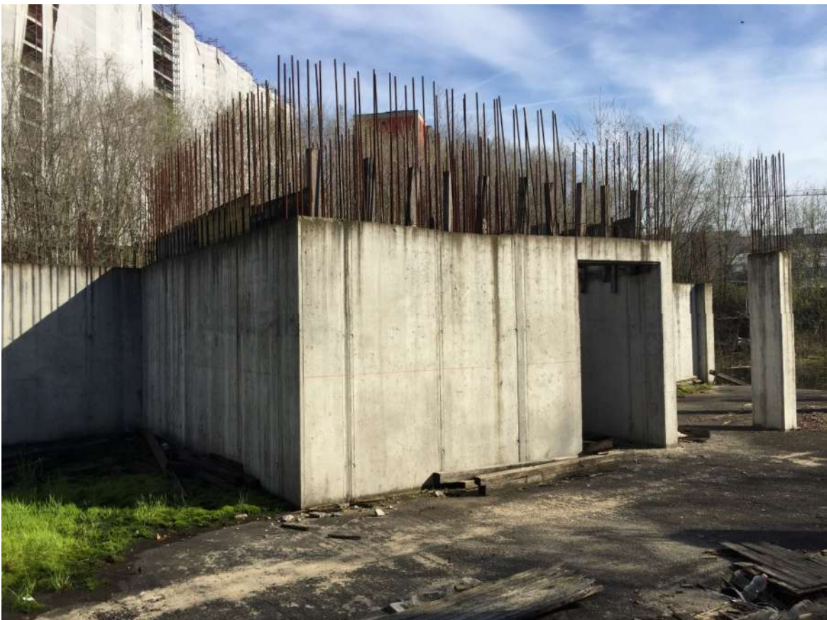
Foto 15 - Vano scale in corso di costruzione
