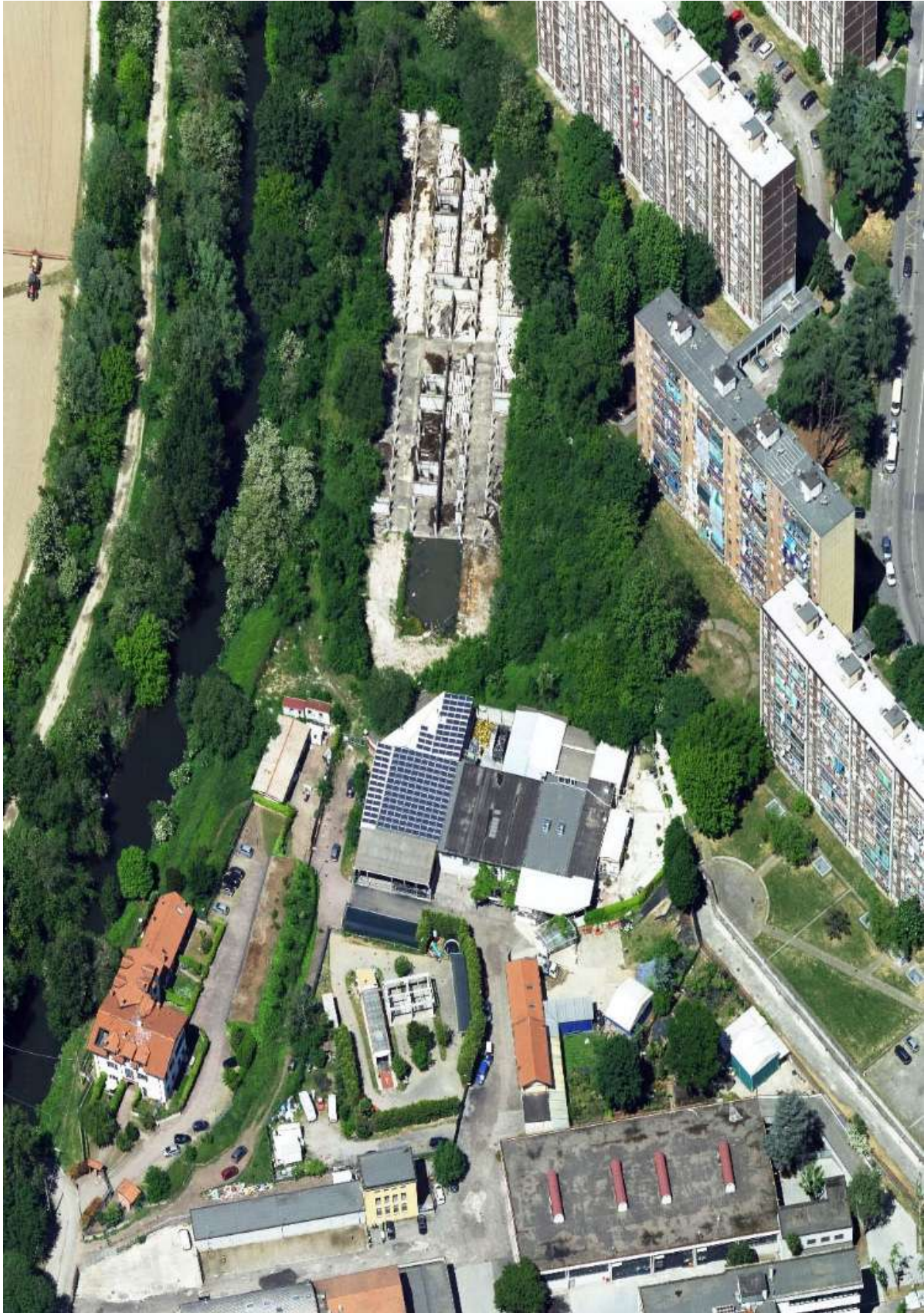
Foto 01 - Vista aerea dell'area urbana in corso di costruzione
