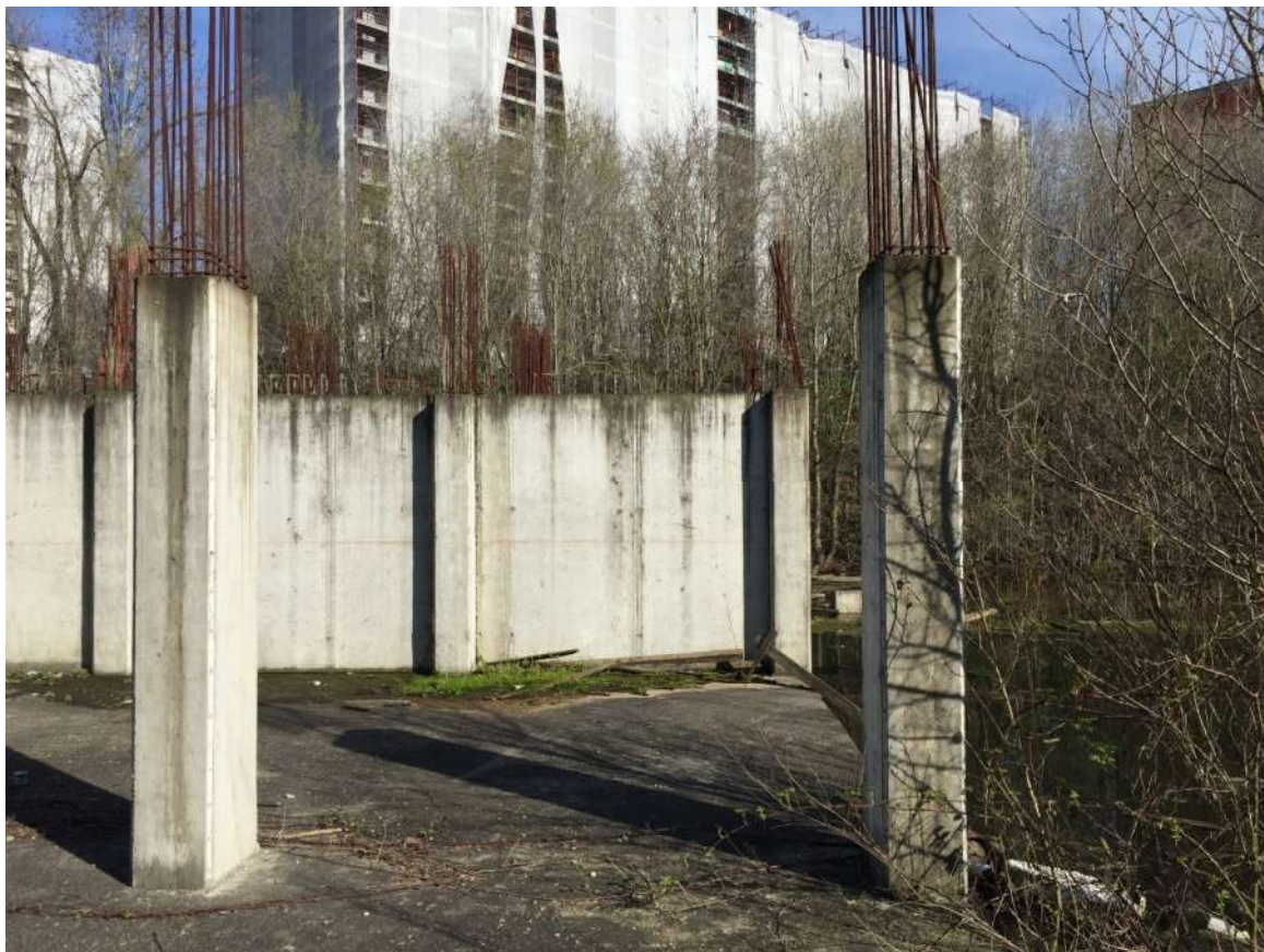
Foto 36 - Area urbana in corso di costruzione
