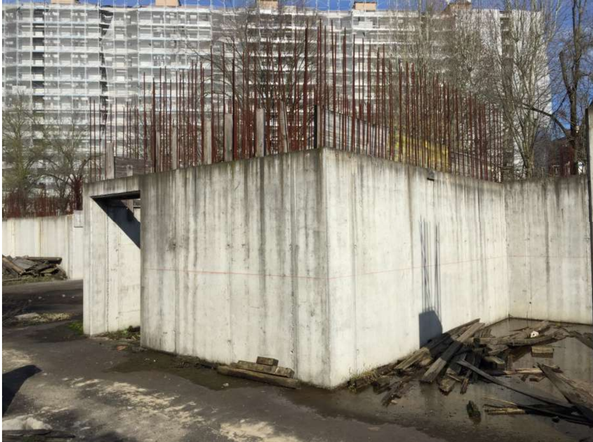
Foto 16 - Vano scale in corso di costruzione
