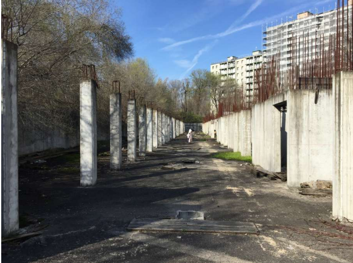
Foto 12 - Area urbana in corso di costruzione
