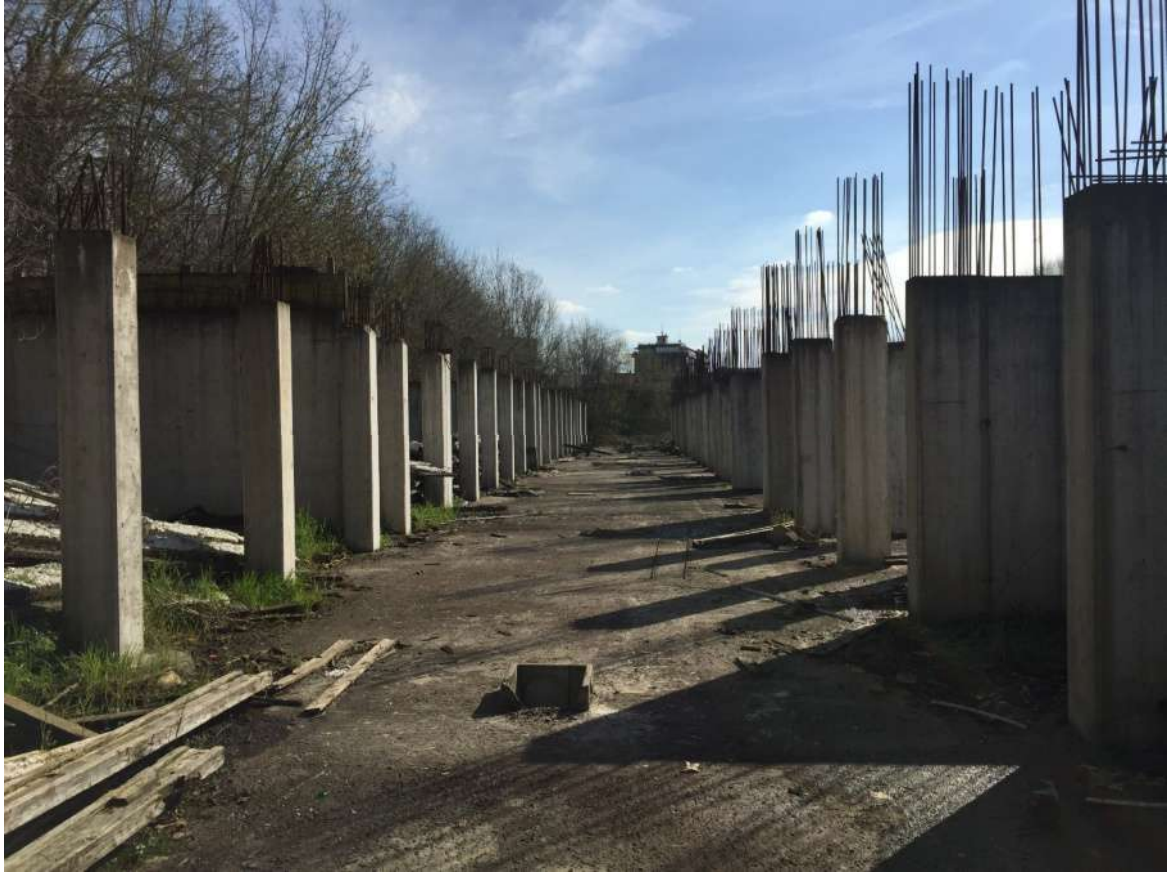
Foto 26 - Area urbana in corso di costruzione
