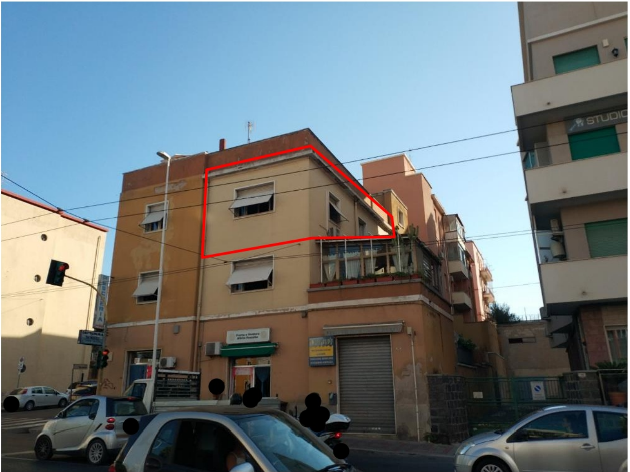
Figura 1. Vista del prospetto dalla Via della Pineta (immobile oggetto di stima identificato in rosso)
