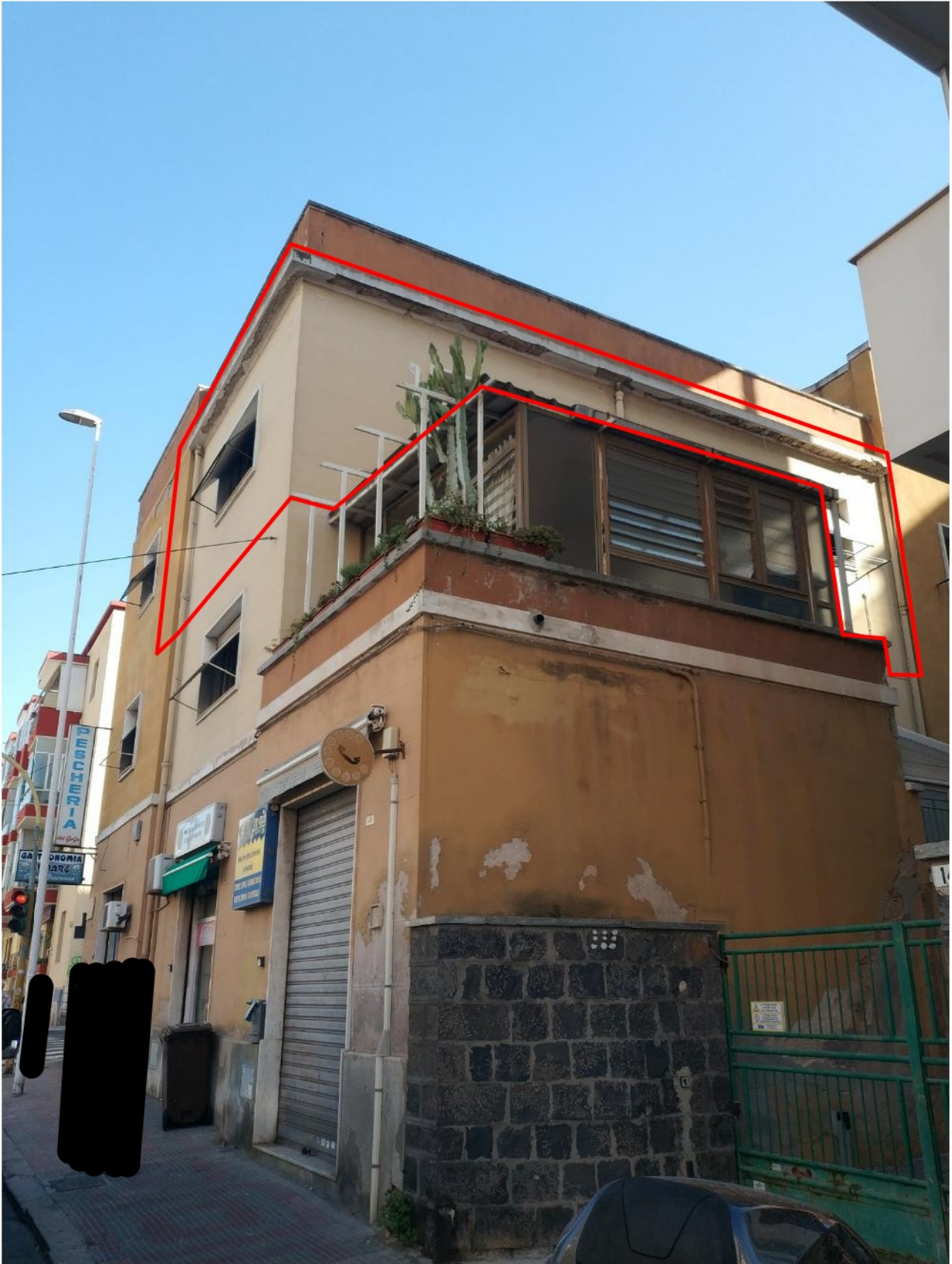
Figura 2. Vista del prospetto dalla Via della Pineta (immobile oggetto di stima identificato in rosso)
