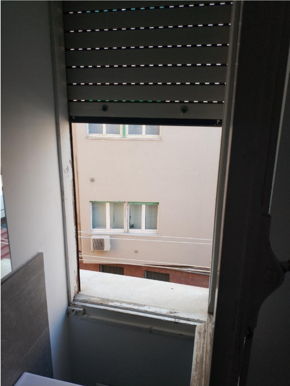
Figura 15. Vista dell'infisso esterno del bagno
