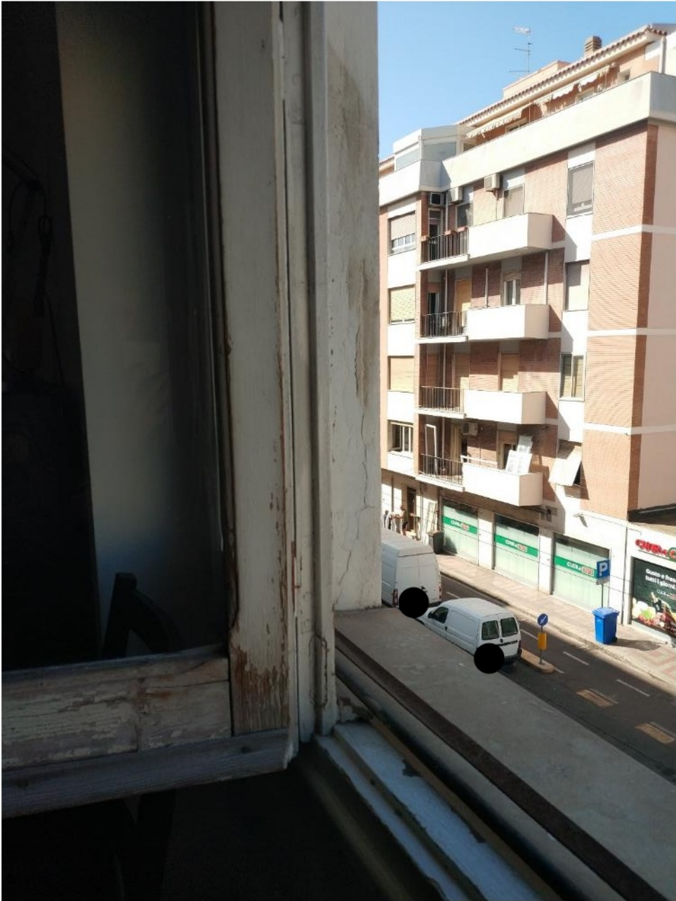
Figura 21. Particolare dell'infisso ligneo con singolo vetro
