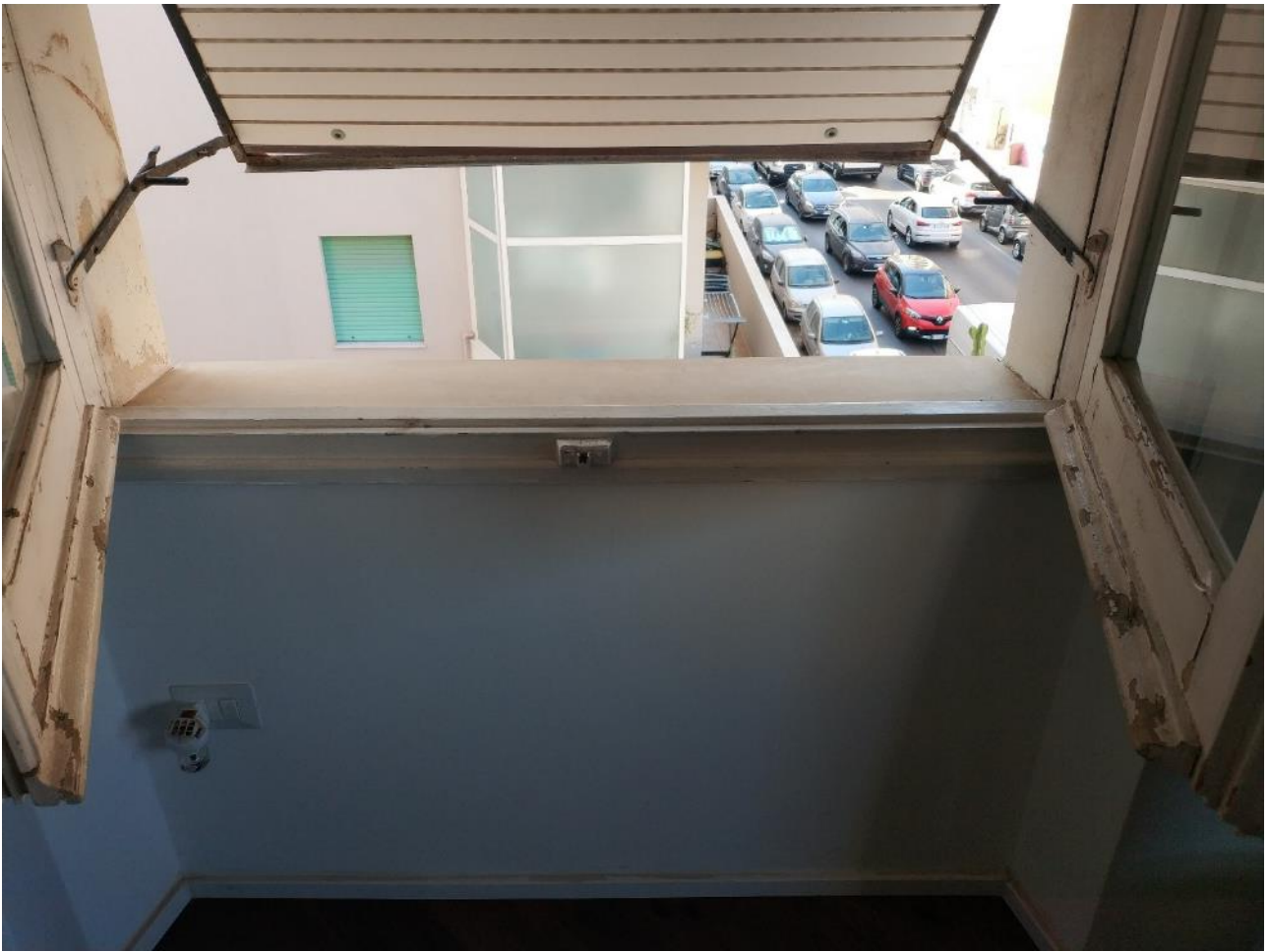
Figura 22. Particolare dell'infisso ligneo con singolo vetro
