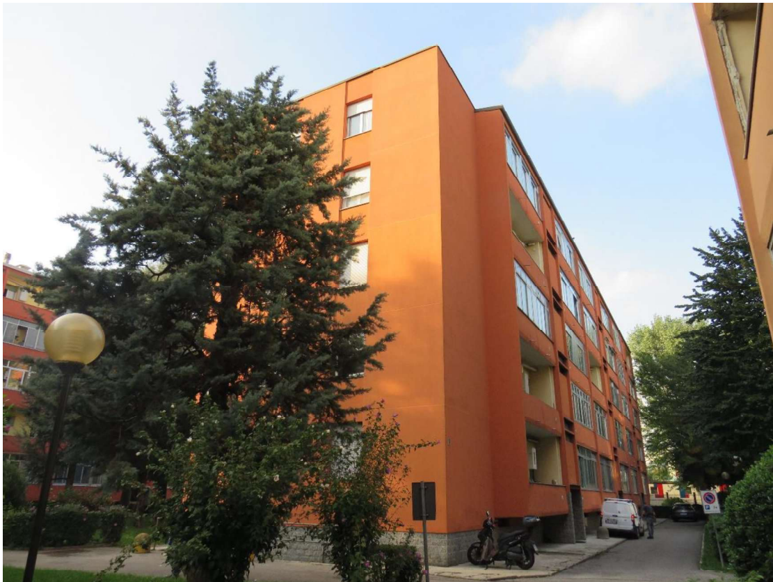
FACCIATA SU GIARDINO INTERNO
