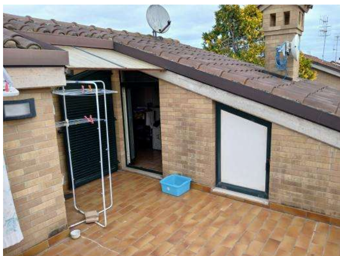
Terrazzo in copertura
