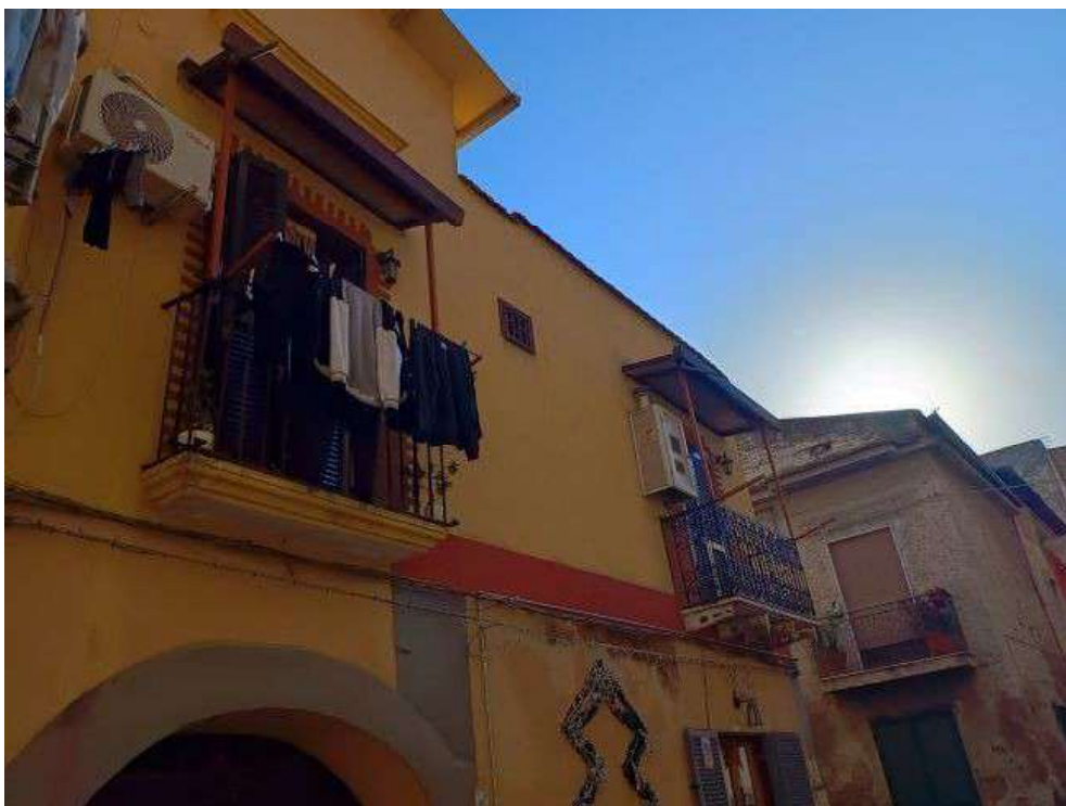
FOTO N. 2 – I balconi dell'appartamento pignorato prospicienti Via San Cuono
