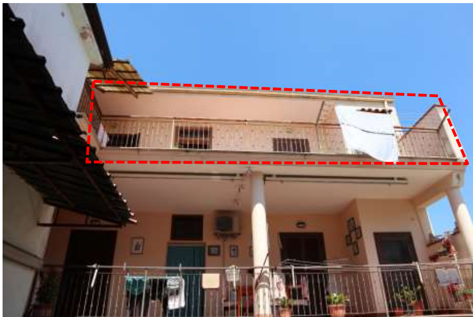
VISTA DELL'APPARTAMENTO AL PRIMO PIANO
