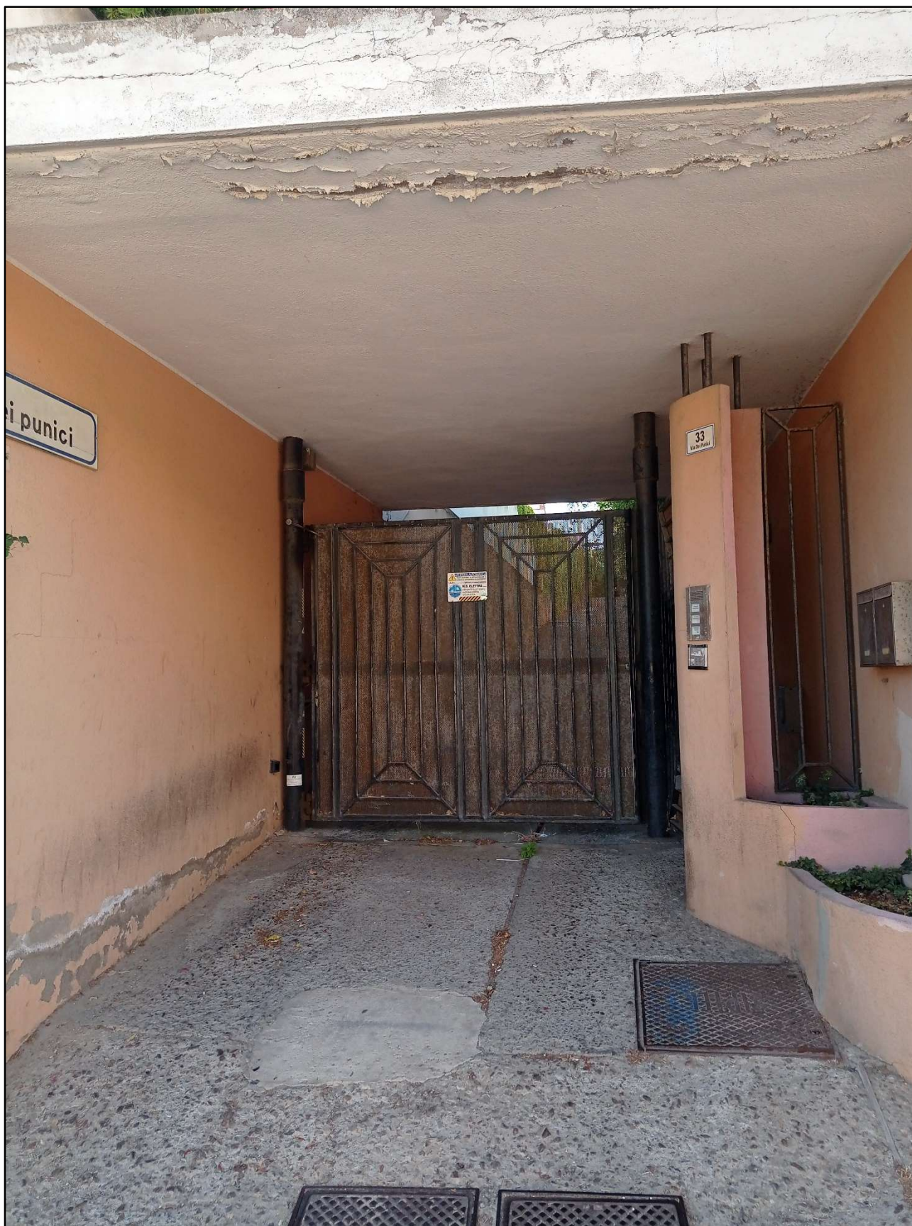
Foto 1 – ingresso carrabile dalla Via dei Punici
