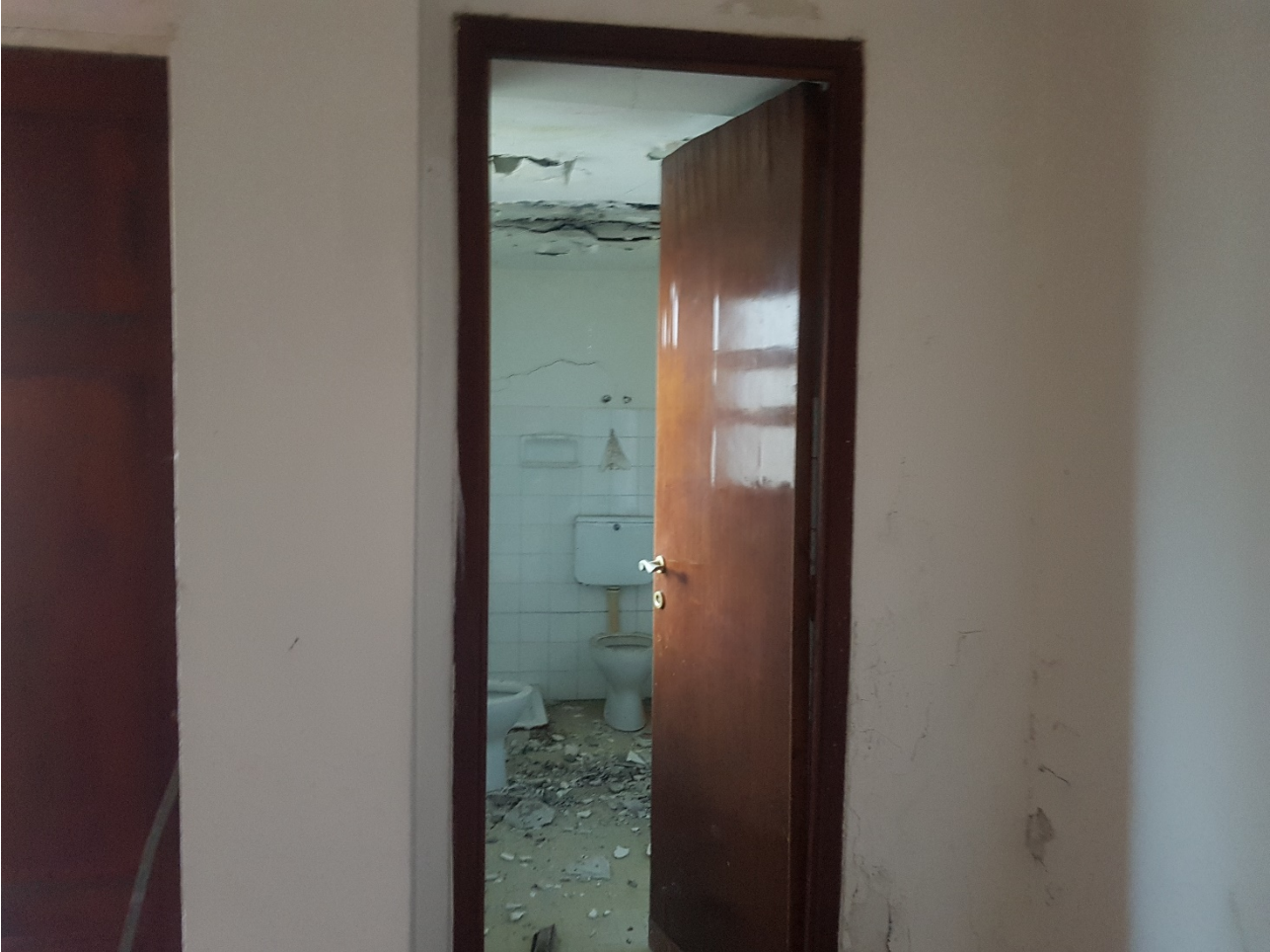
FOTO 28 interno Foglio 40 p.lla 727 Sub.1 - Foglio 40 p.lla 46 Sub.1
