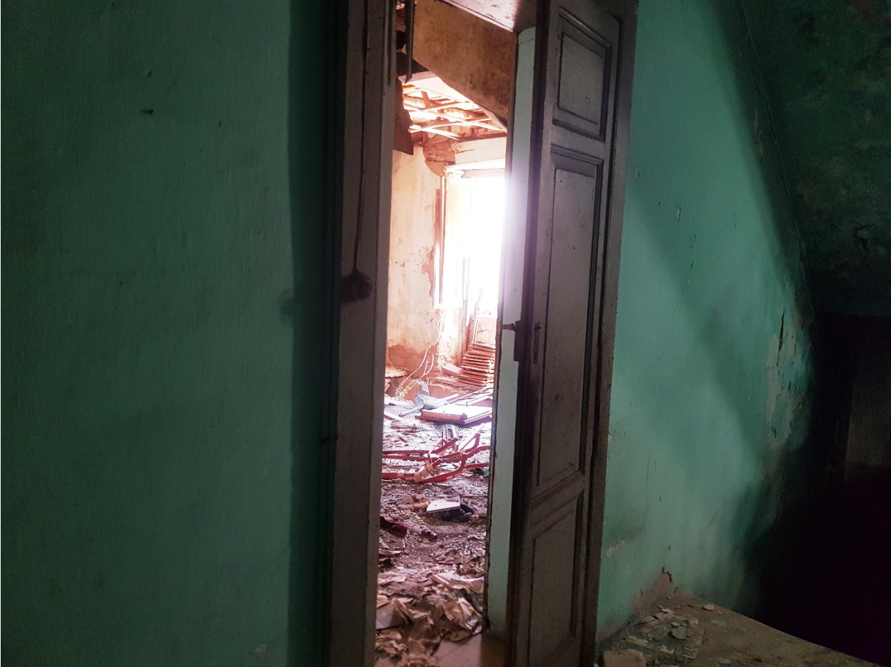
FOTO 60 interno Foglio 40 p.lla 49 Sub.5
