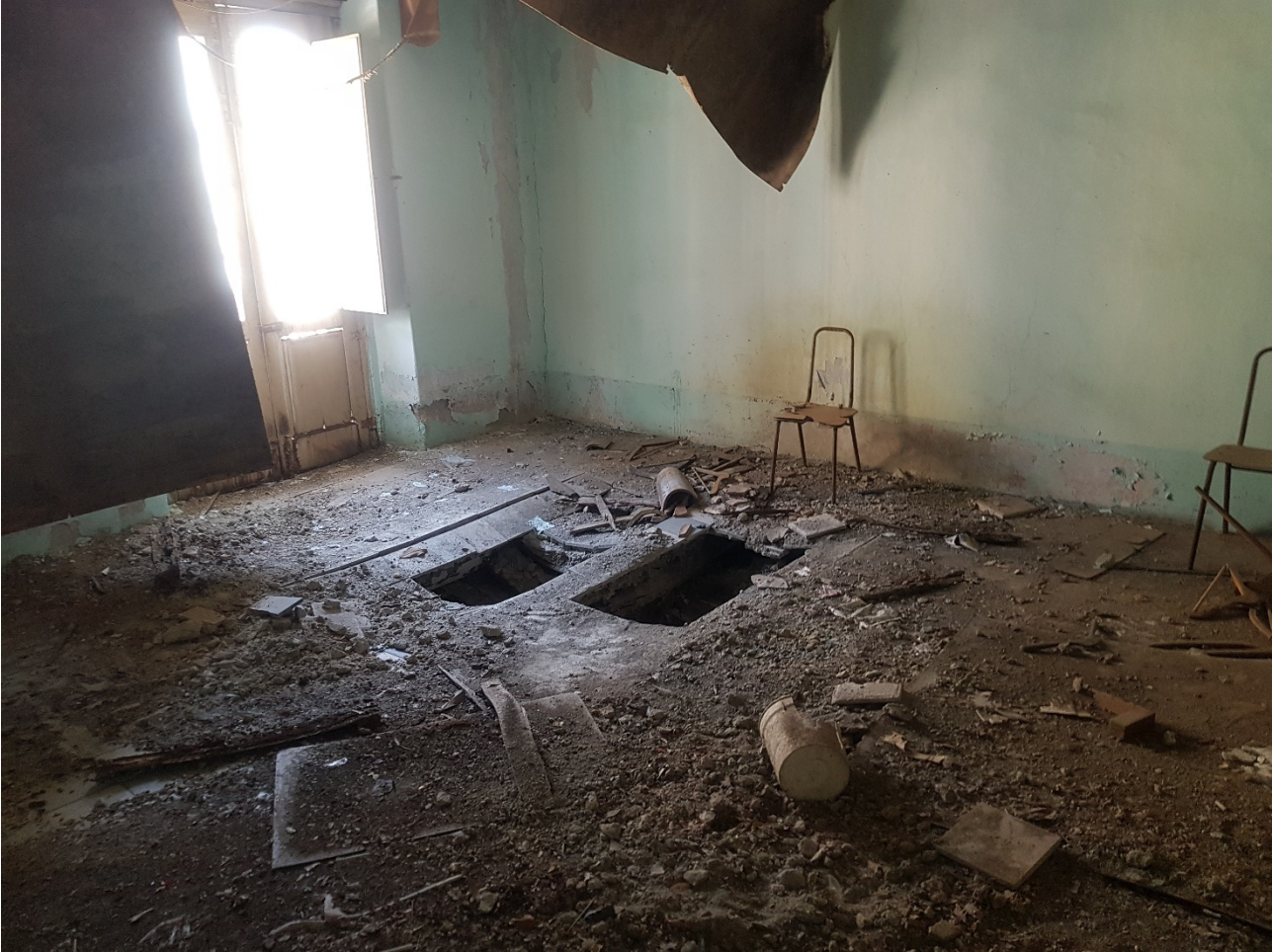
FOTO 58 interno Foglio 40 p.lla 49 Sub.5
