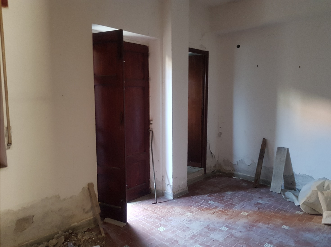
FOTO 27 interno Foglio 40 p.lla 727 Sub.1 - Foglio 40 p.lla 46 Sub.1
