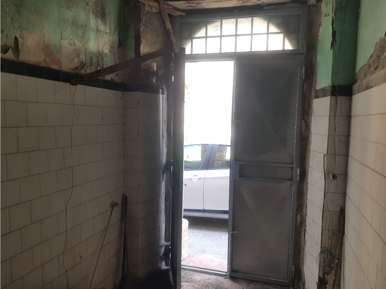
FOTO 50 interno Foglio 40 p.la 49 Sub.5
