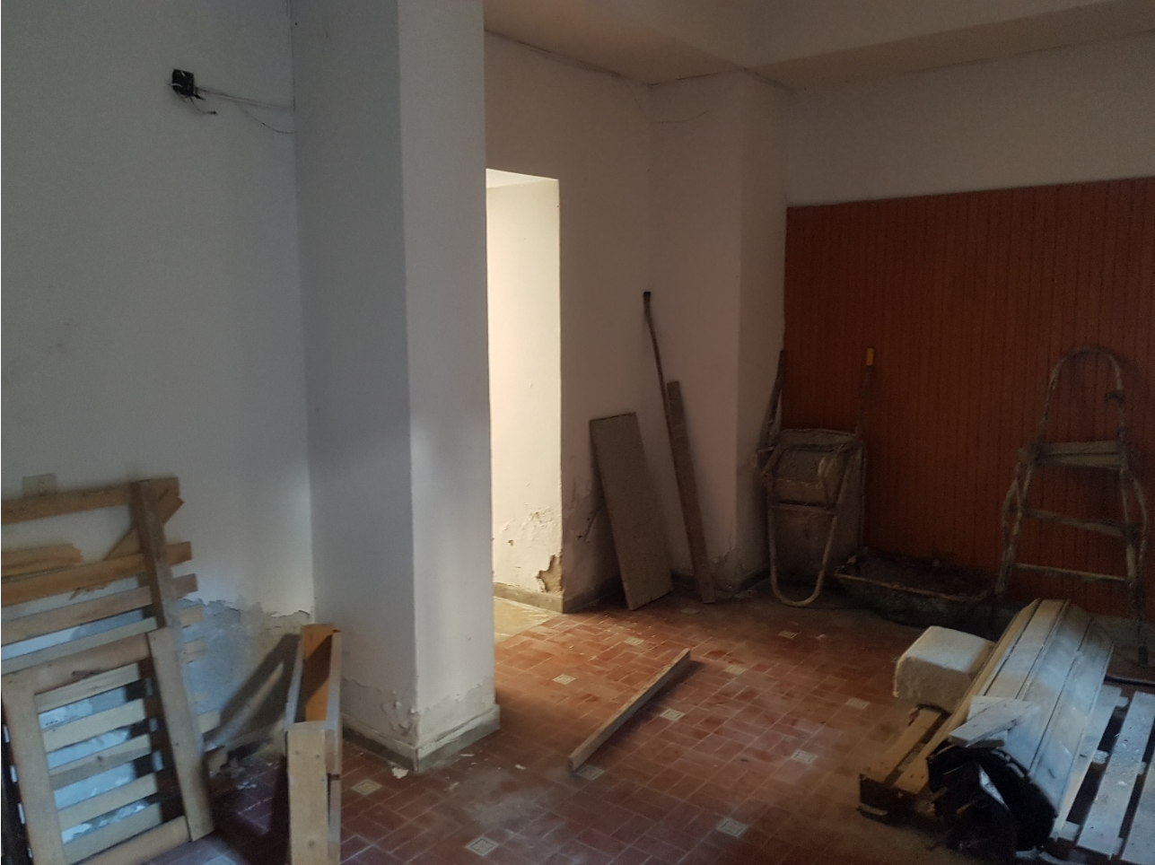
FOTO 26 interno Foglio 40 p.lla 727 Sub.1 - Foglio 40 p.lla 46 Sub.1
