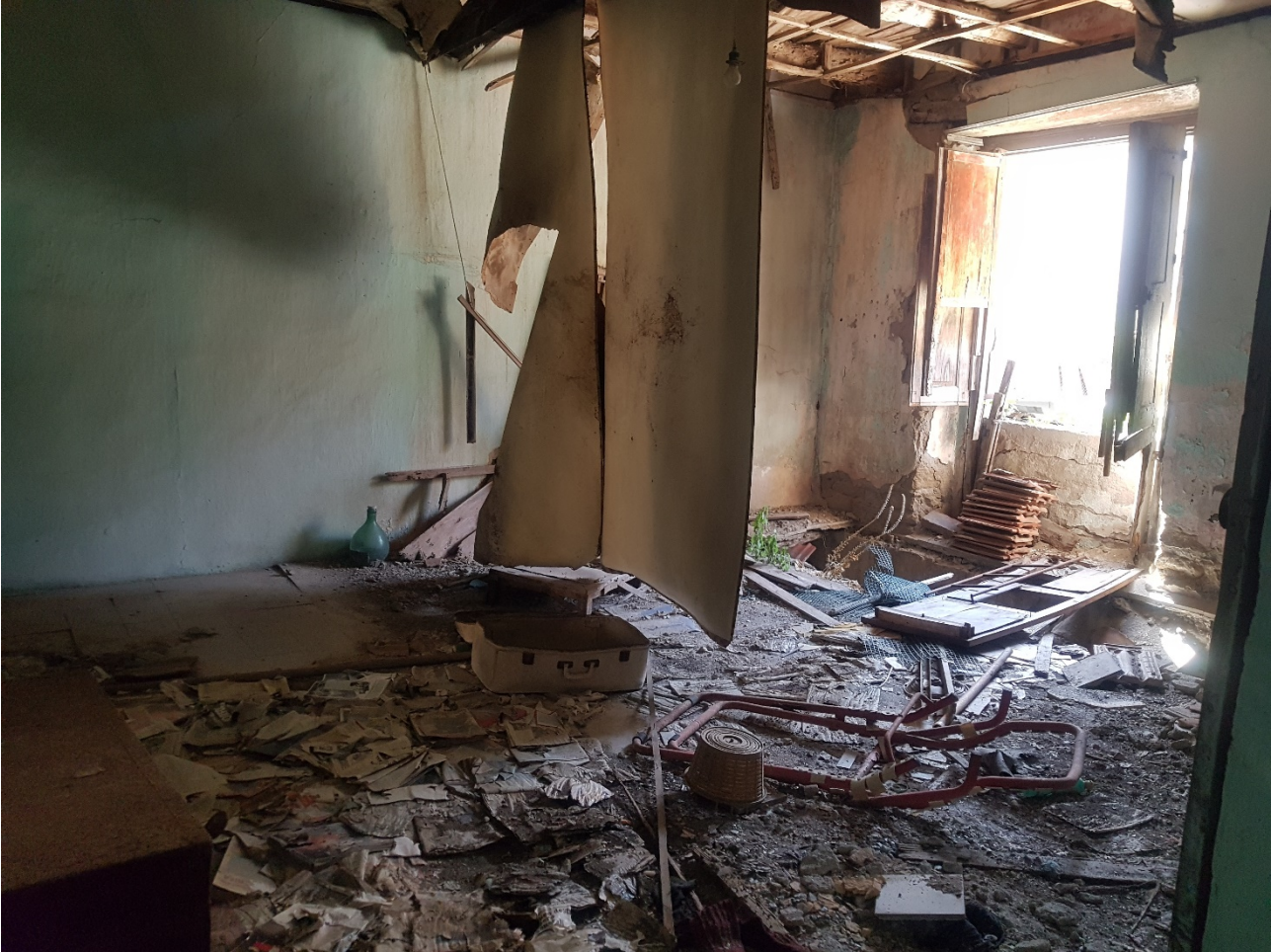
FOTO 61 interno Foglio 40 p.lla 49 Sub.5
