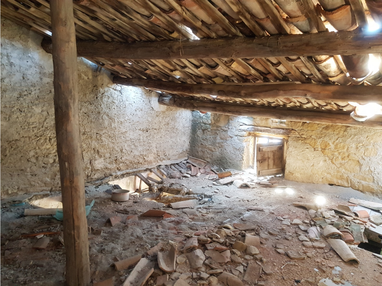
FOTO 69 interno Foglio 40 p.lla 49 Sub.5
