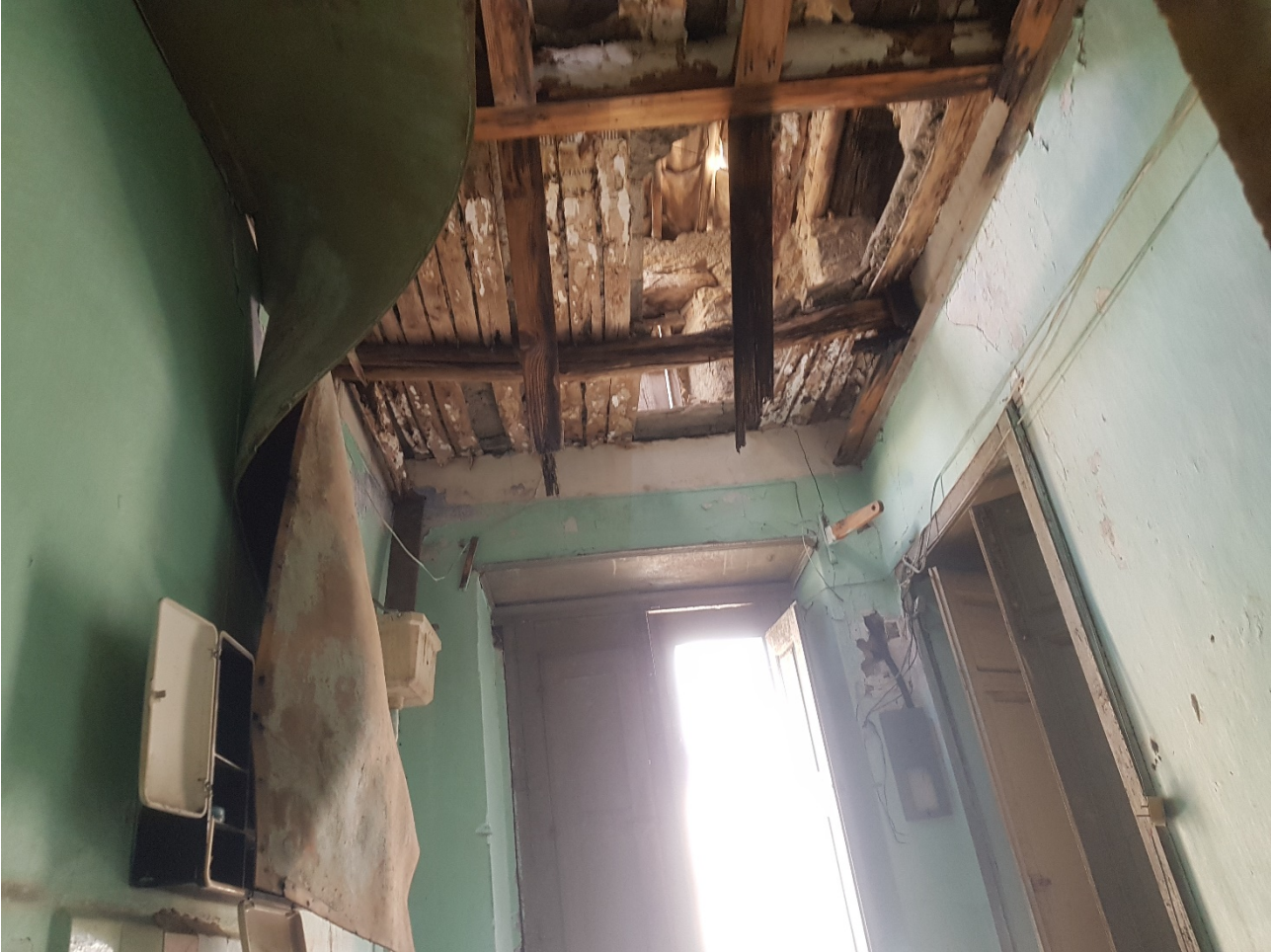
FOTO 57 interno Foglio 40 p.lla 49 Sub.5
