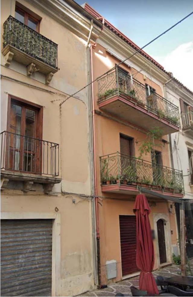
FOTO 22 esterno fabbricato Foglio 40 p.lla 727 Sub.1 - Foglio 40 p.lla 46 Sub.1
