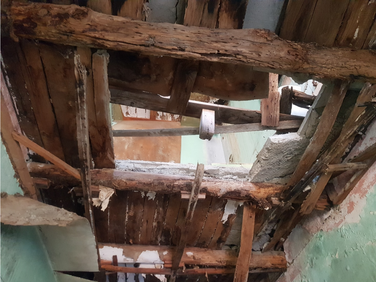
FOTO 52 interno Foglio 40 p.lla 49 Sub.5
