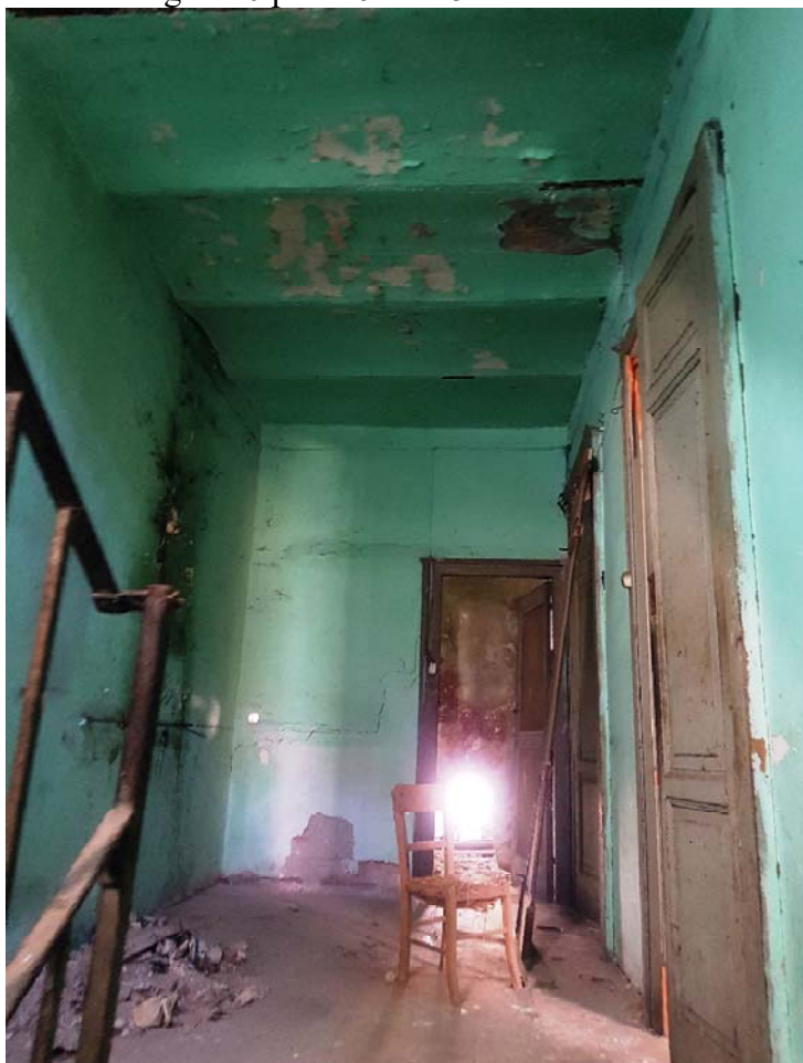
FOTO 55 interno Foglio 40 p.lla 49 Sub.5
