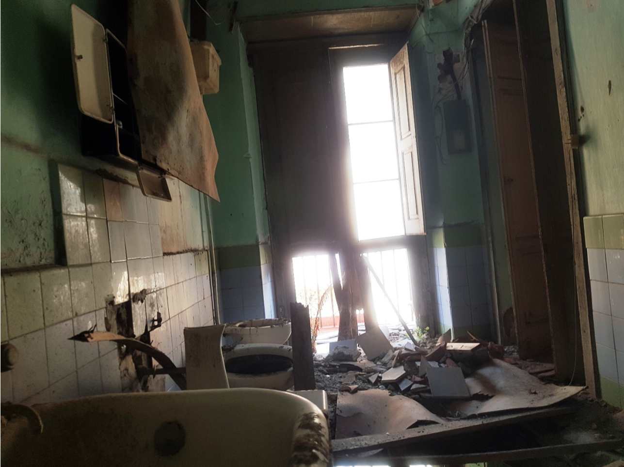
FOTO 56 interno Foglio 40 p.lla 49 Sub.5
