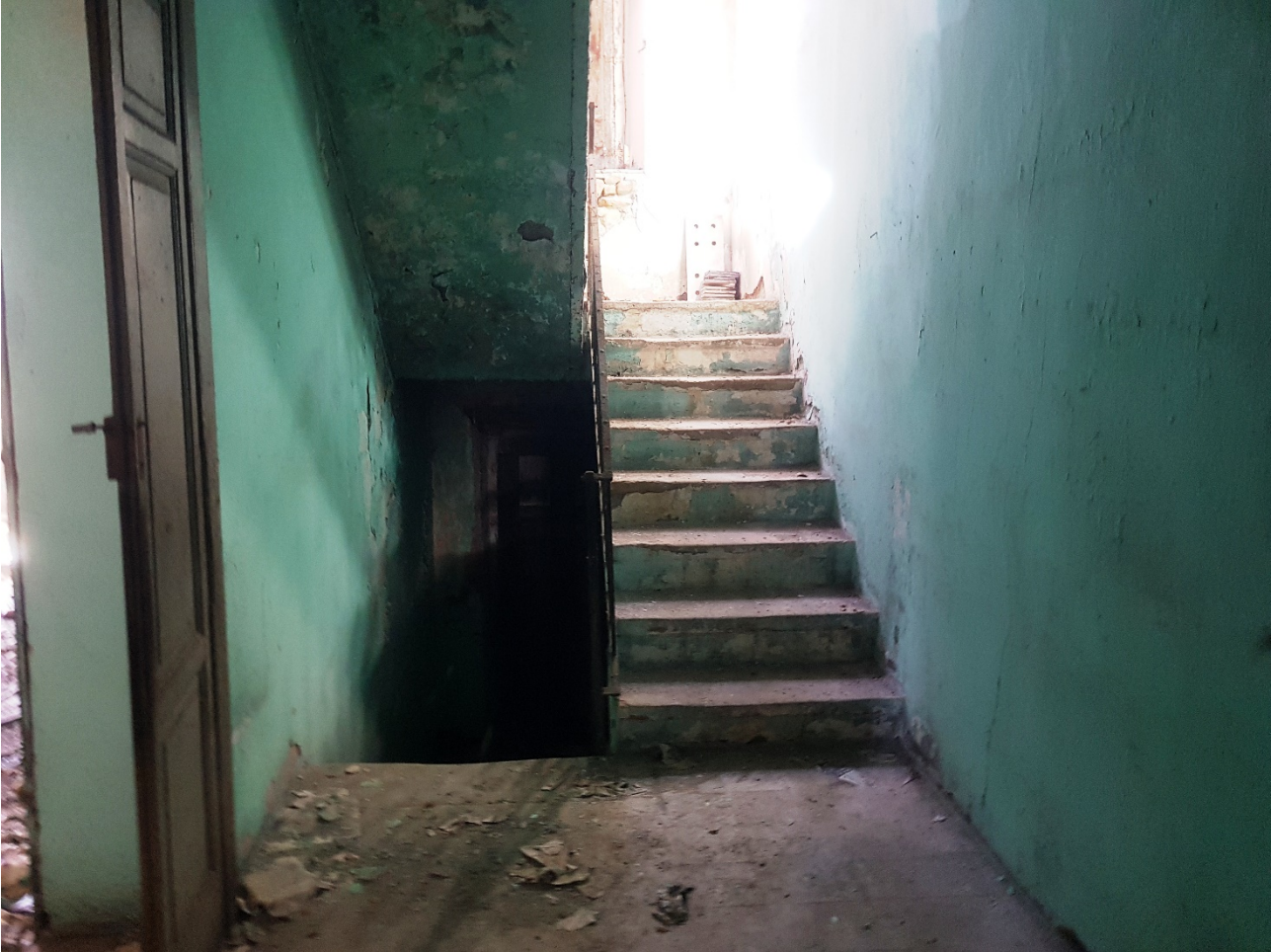
FOTO 59 interno Foglio 40 p.lla 49 Sub.5
