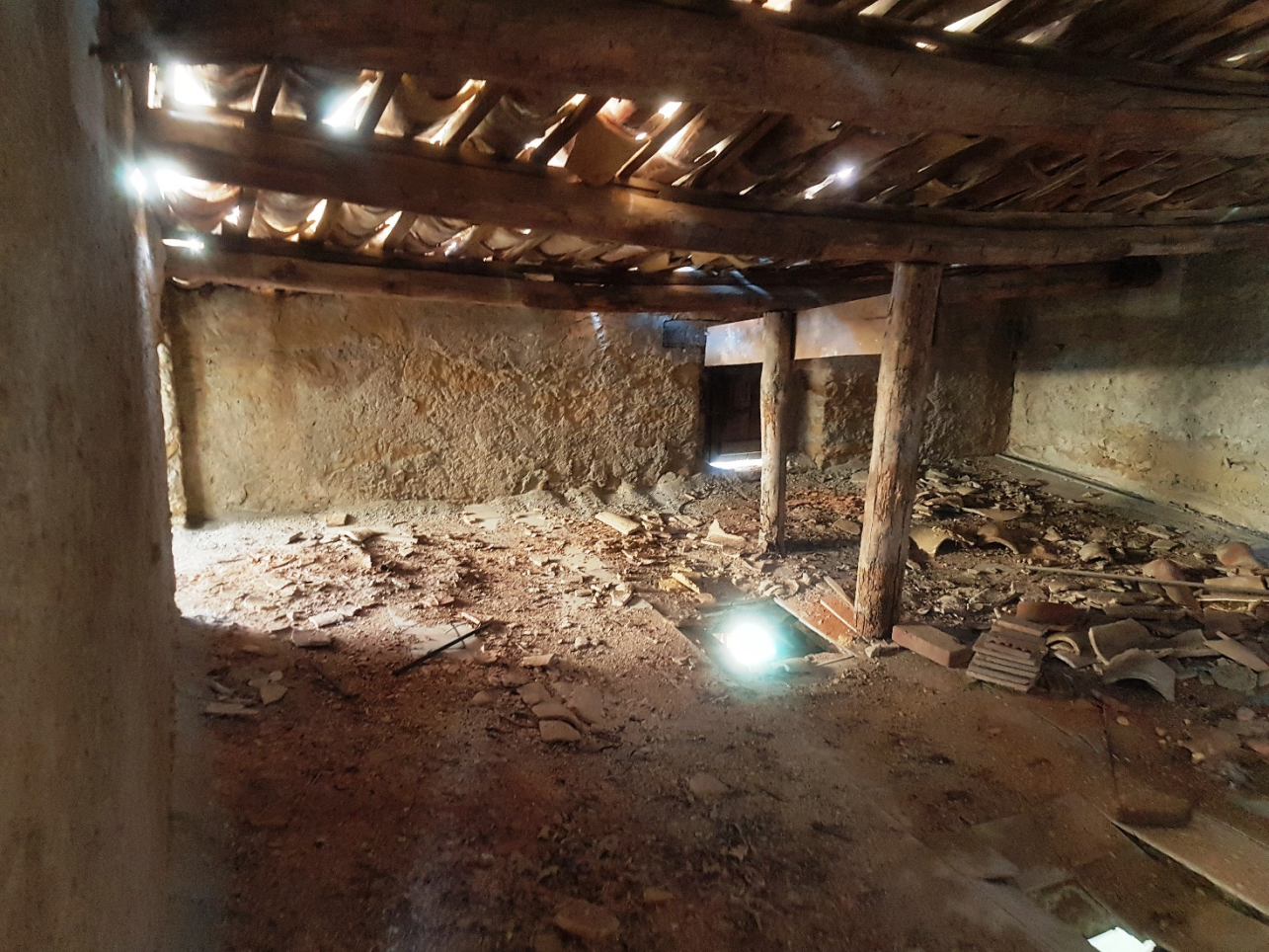
FOTO 66 interno Foglio 40 p.lla 49 Sub.5
