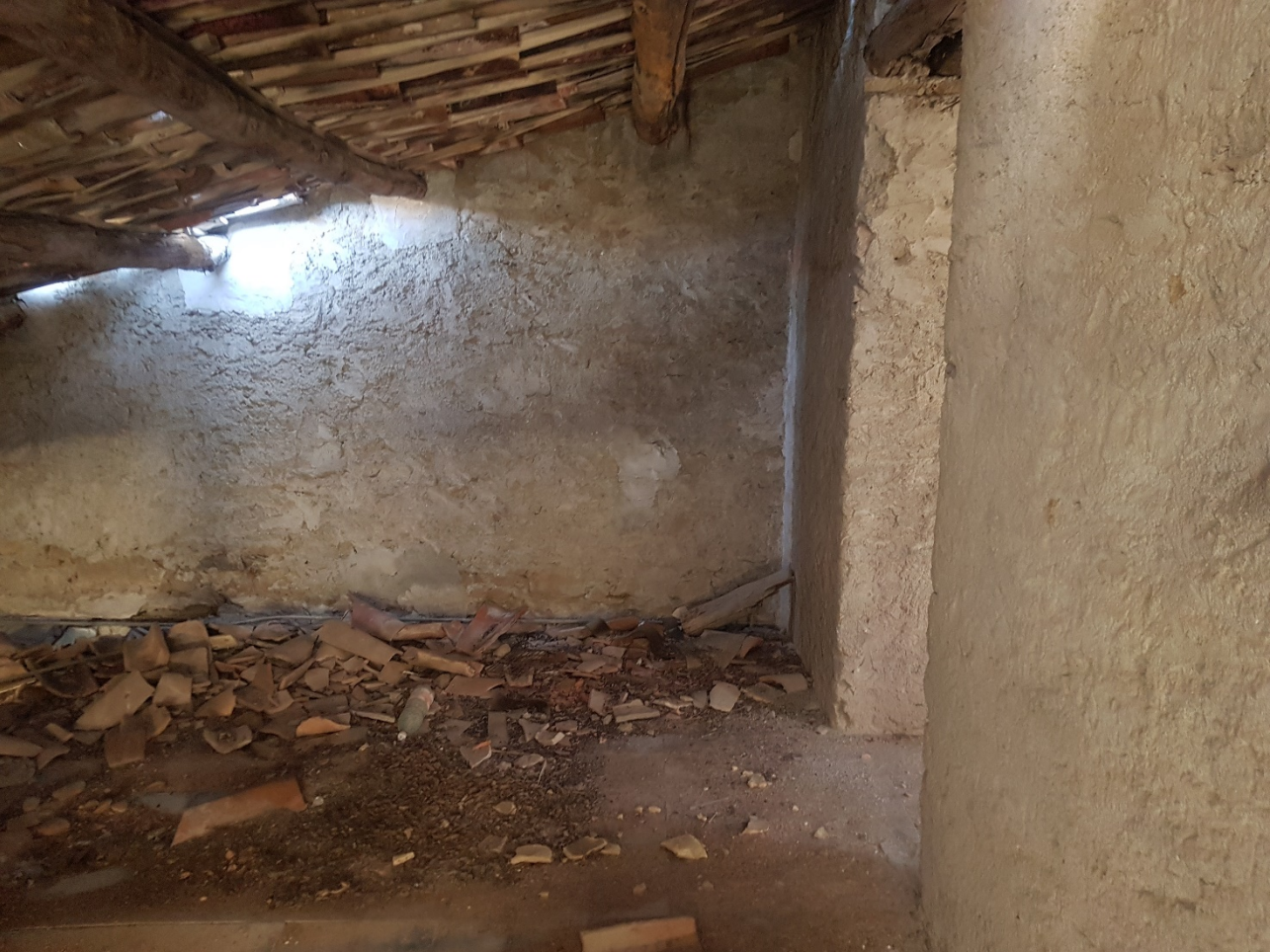
FOTO 67 interno Foglio 40 p.lla 49 Sub.5
