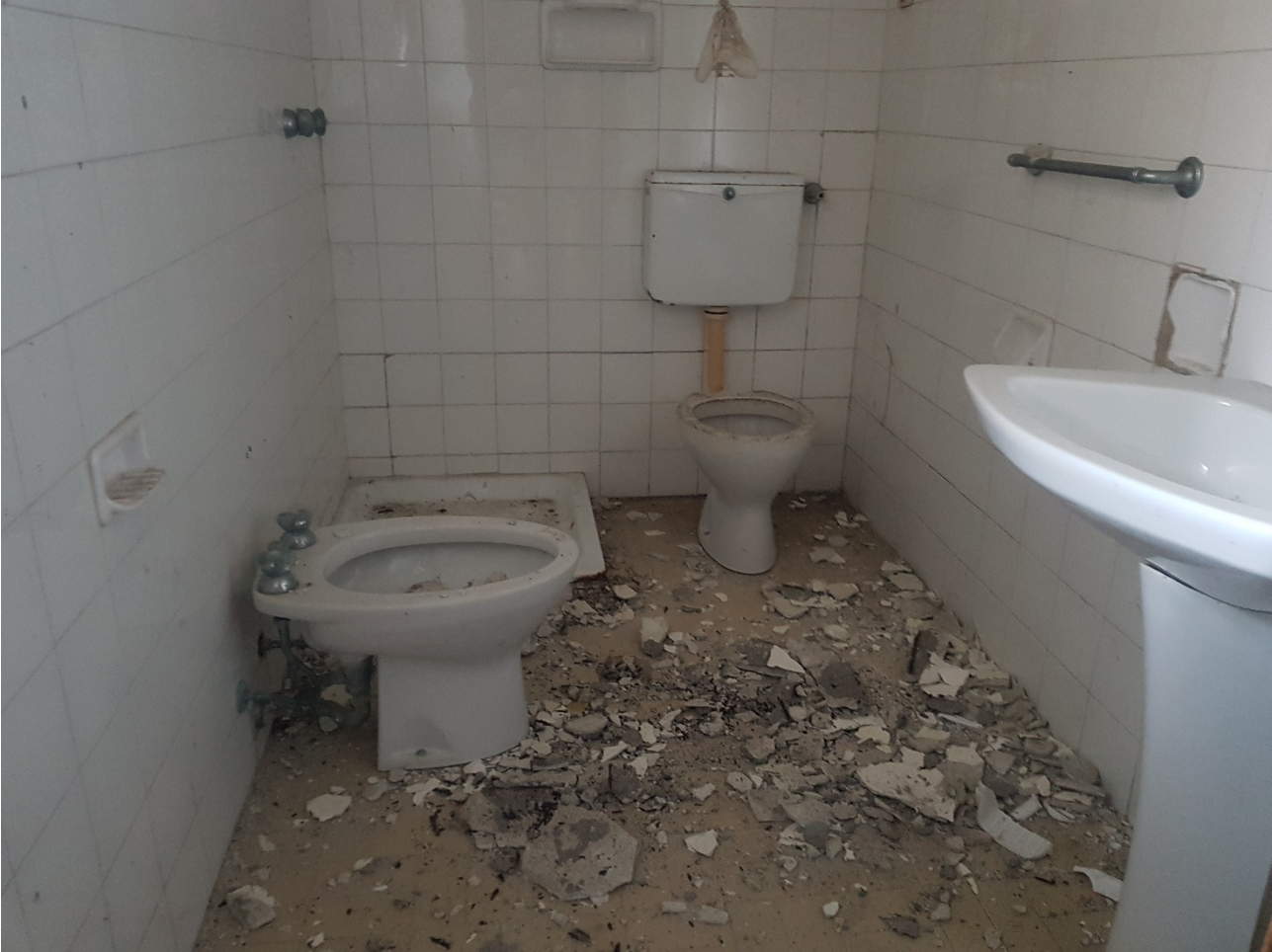
FOTO 29 interno Foglio 40 p.lla 727 Sub.1 - Foglio 40 p.lla 46 Sub.1
