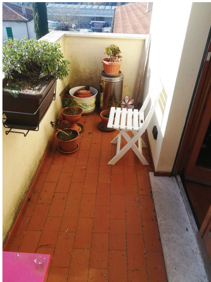
Foto n. 26 – Vista particolare di un terrazzo
