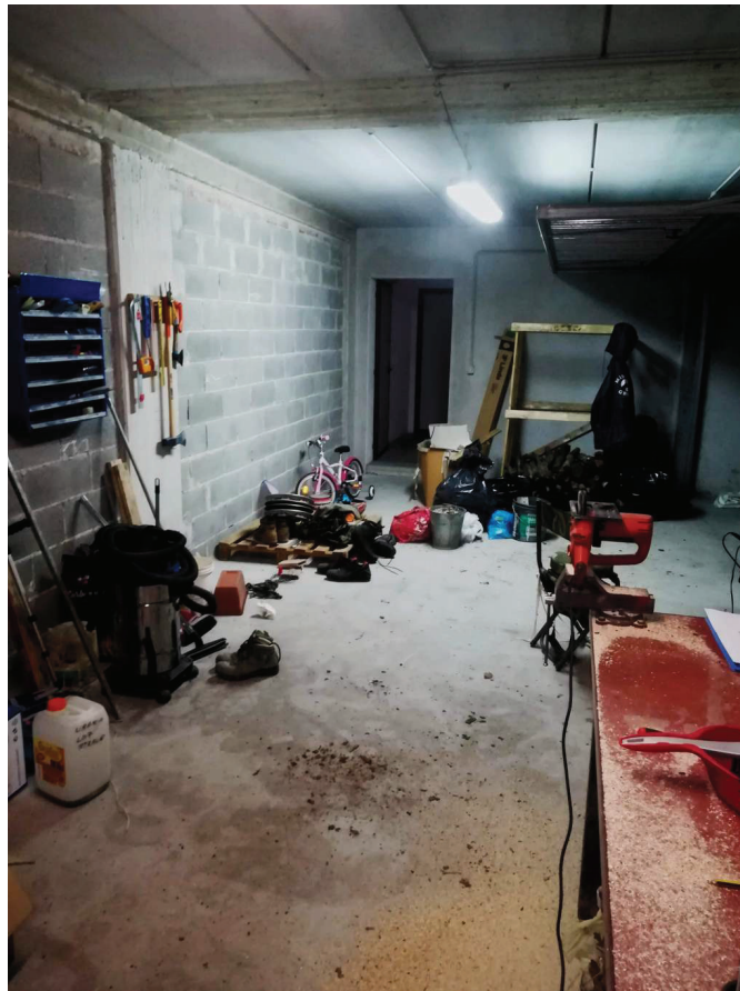
Foto n. 29 – Vista interno del garage interessato, con porta d'accesso alla scala condominiale
