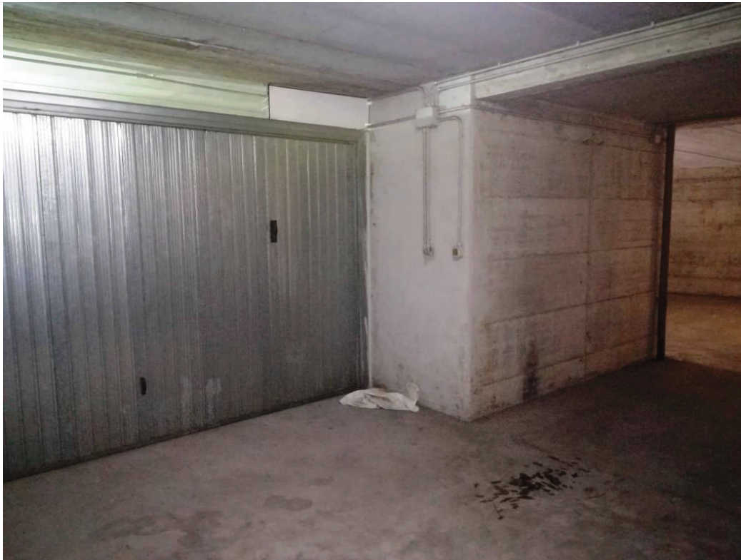
Foto n. 28 – Particolare infisso d'ingresso del garage interessato
