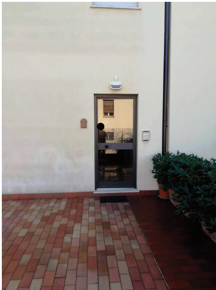
Foto n. 8 – Vista particolare porta d'ingresso condominiale
