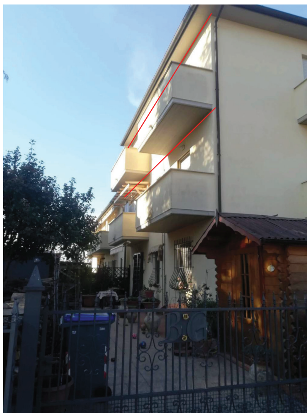
Foto n. 5 – Vista particolare del prospetto laterale visibile da Via San Giuseppe
