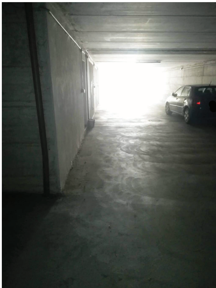
Foto n. 9 – Vista dall'interno della zona d'ingresso ai garages del fabbricato
