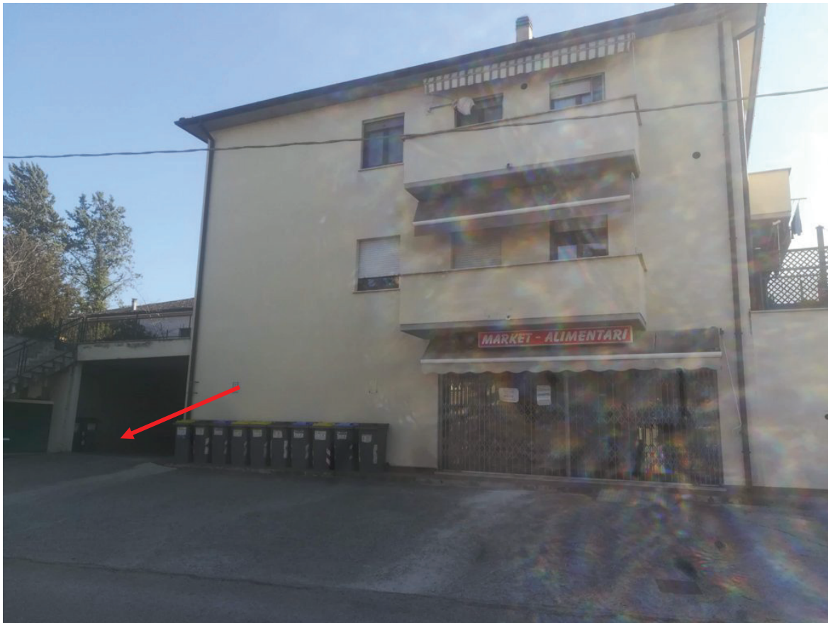
Foto n. 6 – Vista del prospetto da Via Faustana da cui si accede al locale garage dalla zona con freccia rossa, visibile nella foto 7 seguente
