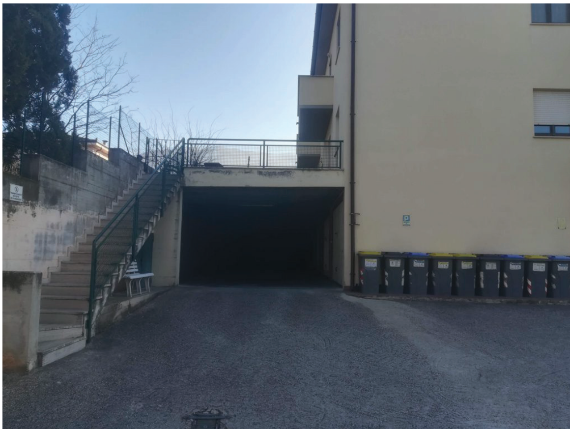
Foto n. 7 – Vista ingresso condominiale ai garage
