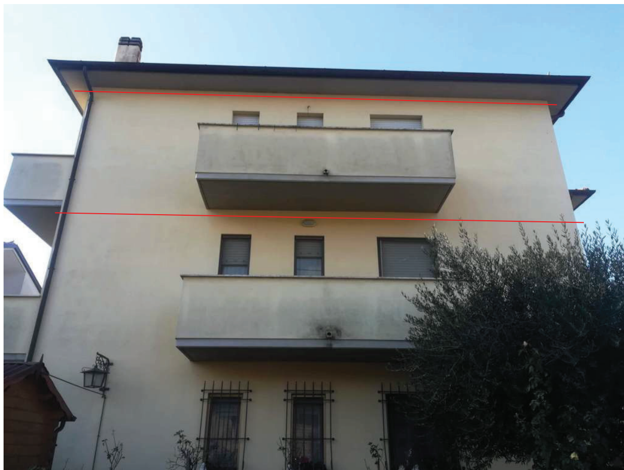
Foto n. 4 – Vista particolare del prospetto e zona di occupazione dell’immobile da Via San Giuseppe
