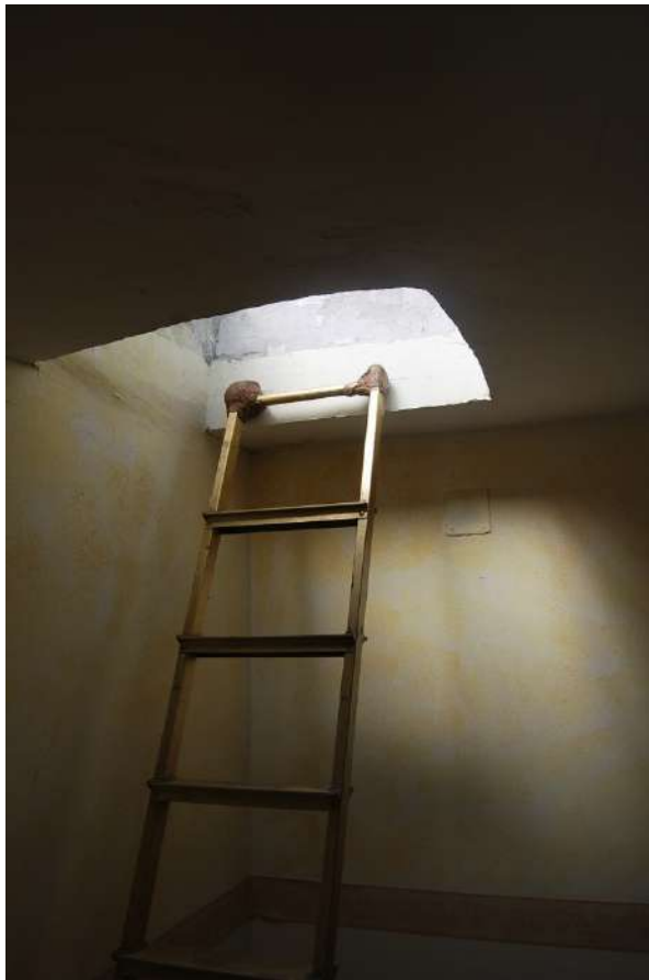
FOTO 9 PARTICOLARE BOTOLA SOPPALCO U. IMMOBILIARE PORZIONE 1
