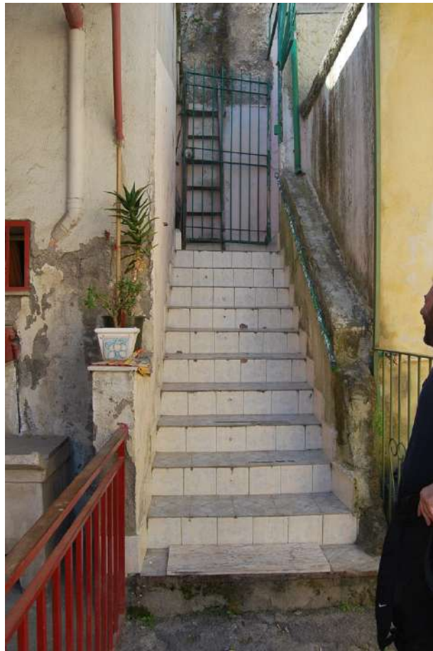
FOTO 1 – SCALA DI ACCESSO ALL' UNITA' IMMOBILIARE
