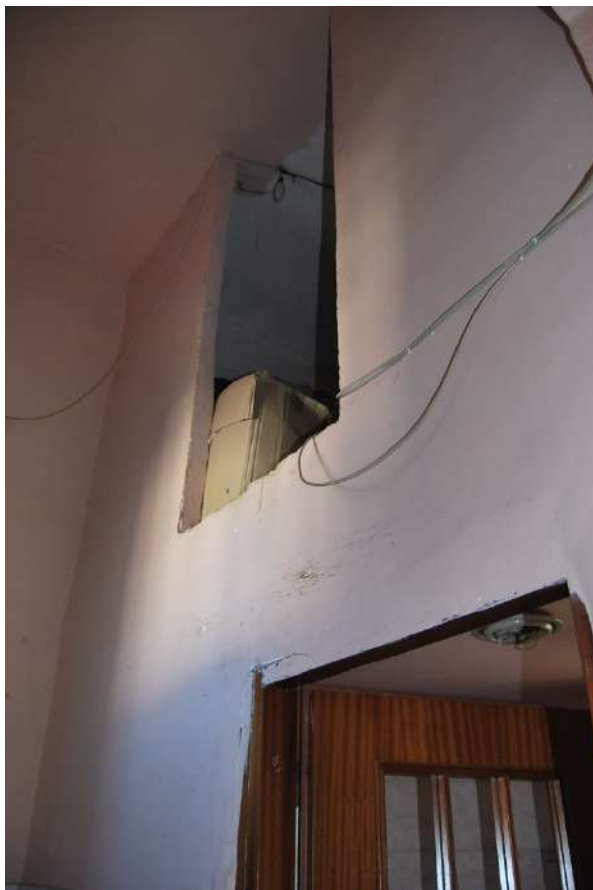
FOTO 13 PARTICOLARE SOPPALCO BAGNO U. IMMOBILIARE PORZIONE 2
