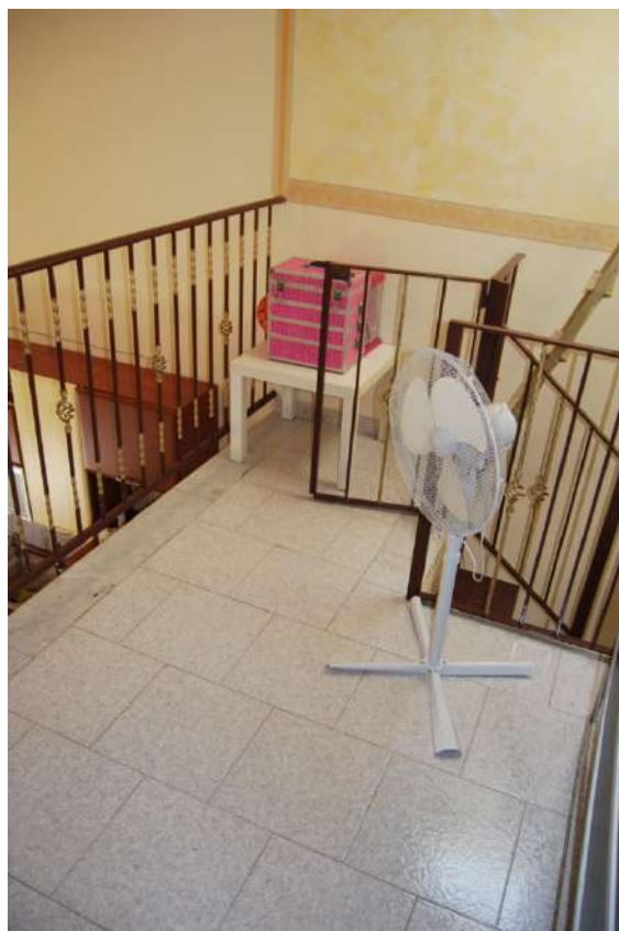
FOTO 8 PARTICOLARE SCALA SOPPALCO U. IMMOBILIARE PORZIONE 1
