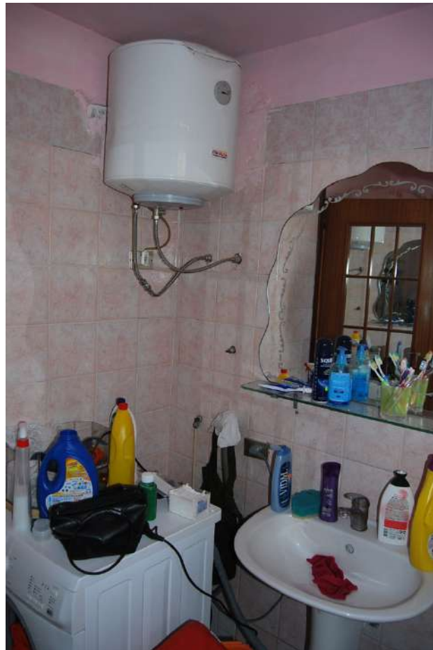
FOTO 12 BAGNO U. IMMOBILIARE PORZIONE 2
