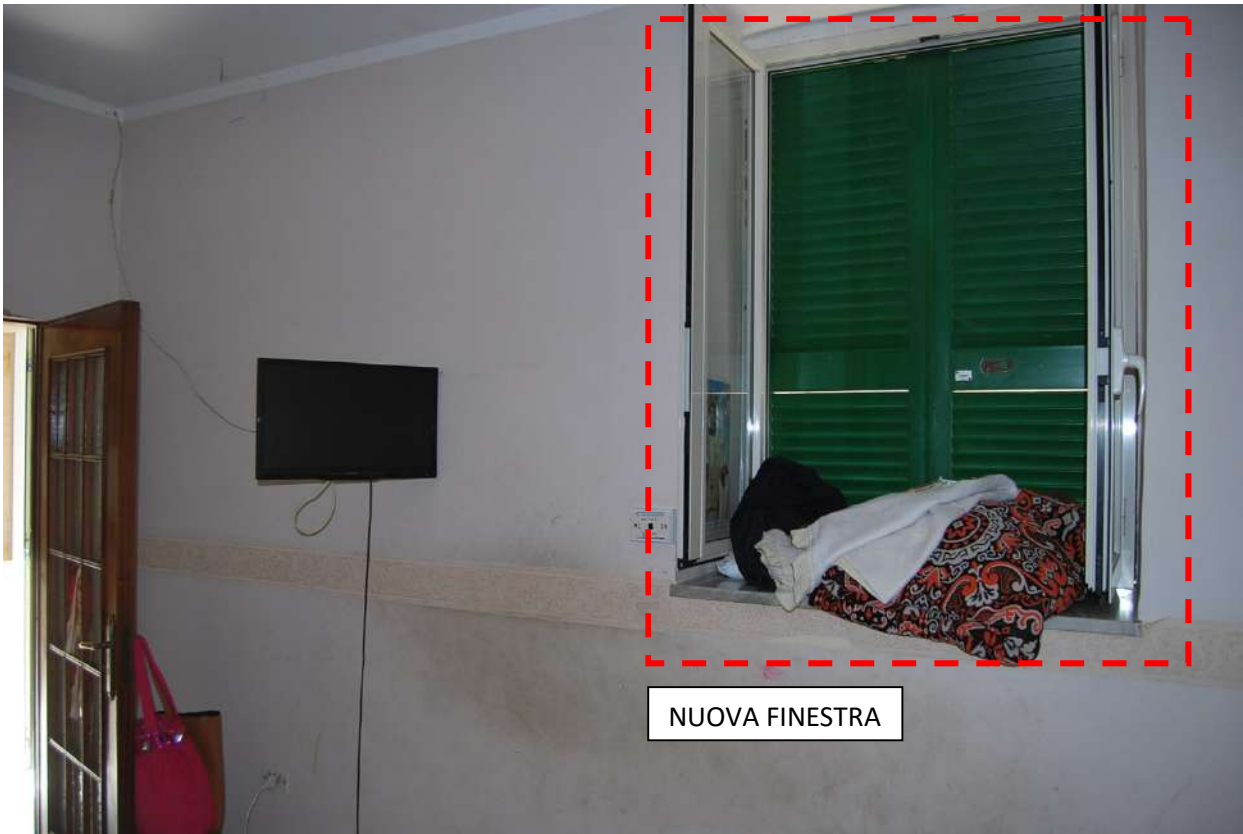
FOTO 15 PARTICOLARE NUOVA FINESTRA LETTO U. IMMOBILIARE PORZIONE 2
