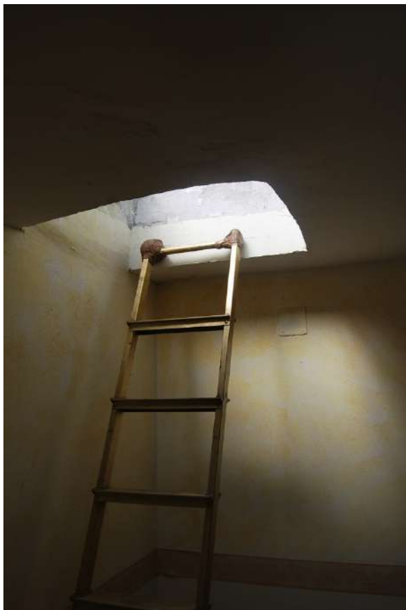
FOTO 9 PARTICOLARE BOTOLA SOPPALCO U. IMMOBILIARE PORZIONE 1
