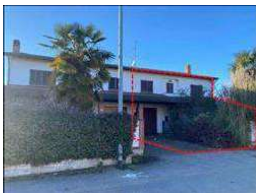
Corpo "A" - Vista del prospetto Ovest dalla Via Sandro Pertini
