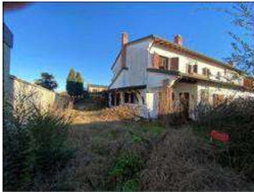
Corpo "A" - Prospetti Sud ed Est ed area esterna di pertinenza
