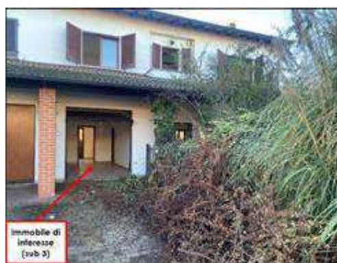
Corpo "B" - Vista dell'accesso
