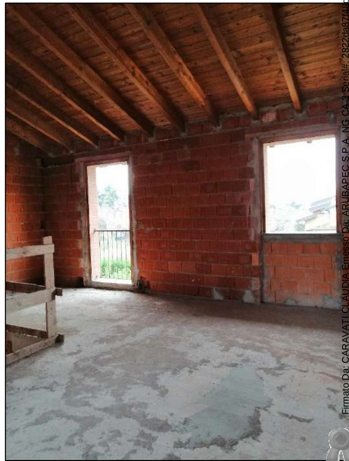
Primo piano sottotetto
