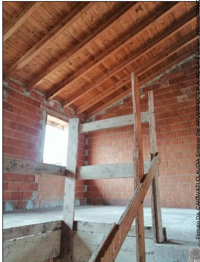
Primo piano sottotetto
