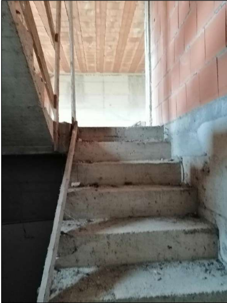
Scala piano interrato-piano terra
