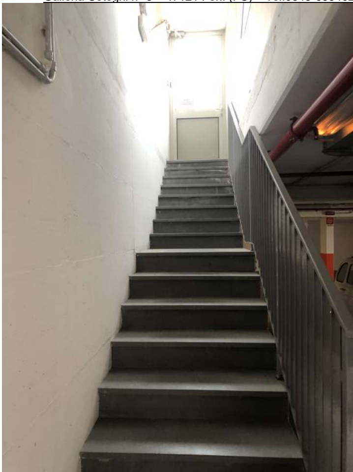
Foto 7- scala interna di collegamento al 2° piano
