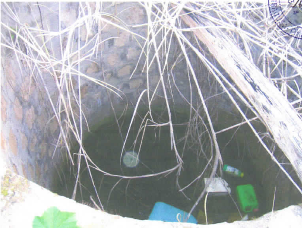
Foto n° 20 - Particolare interno del pozzo freatico (bene n° 4).
