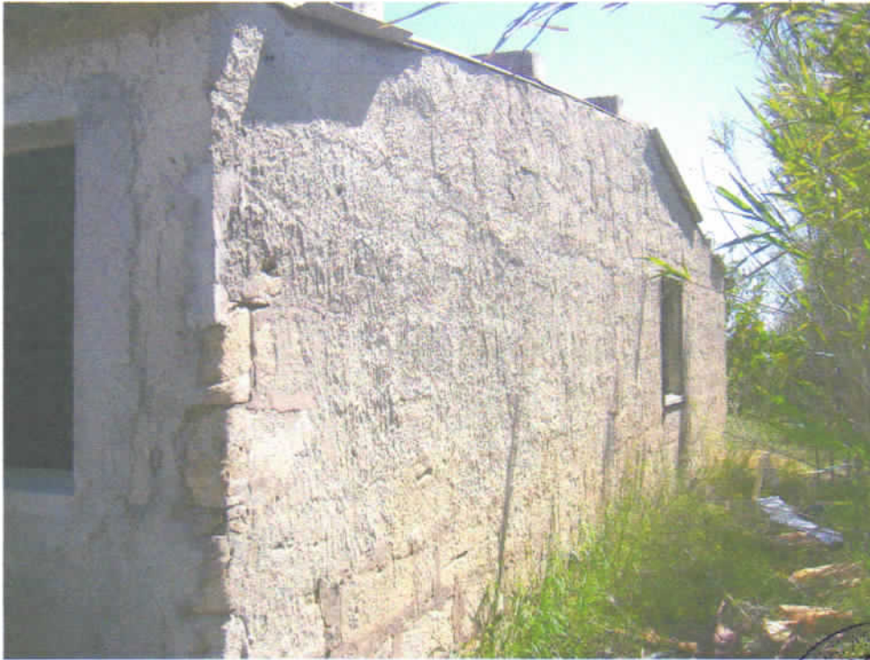
Foto n° 15 - Facciata Ovest del fabbricato rustico (bene n° 2).
