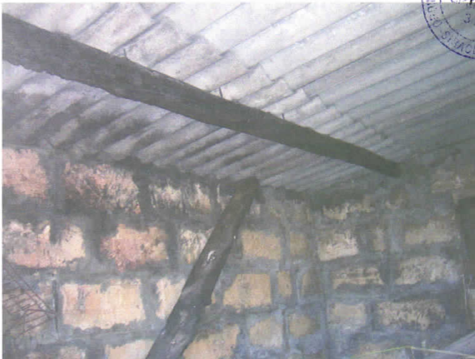
Foto n° 16 - Particolare della copertura del fabbricato.
