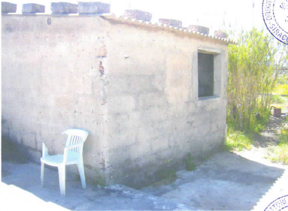
Foto n° 17 - Facciata Nord del fabbricato (bene n° 2).
