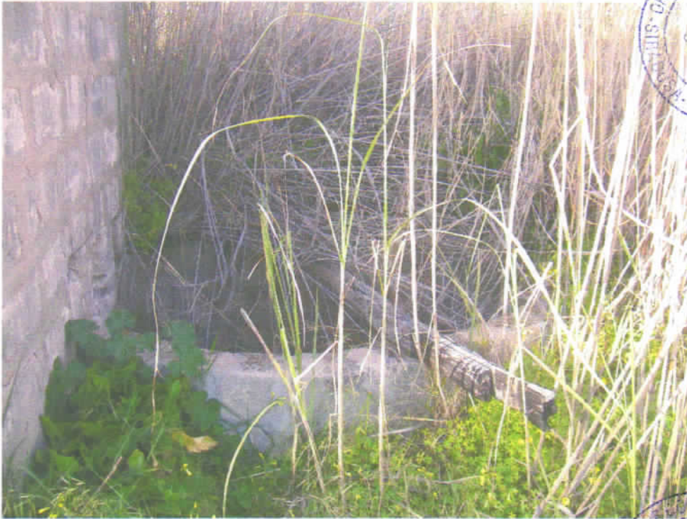
Foto n° 19 - Pozzo freatico scavato a mano (bene n° 4).
