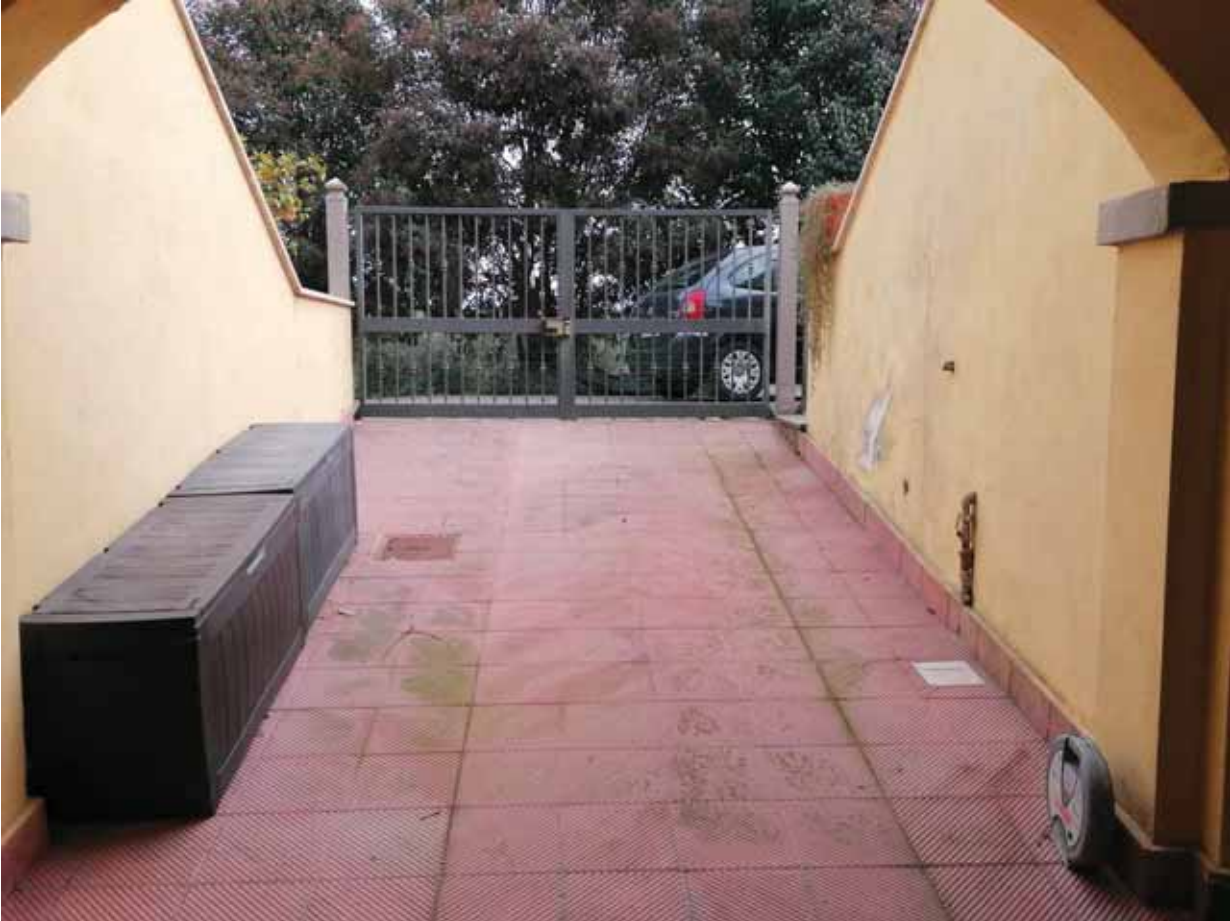
FOTO N°23: Vista esterna del villino al piano seminterrato.
