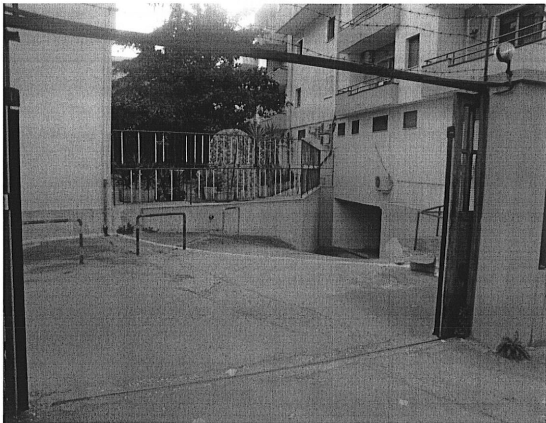
Foto 13: IMMOBILE B. Rampa d'accesso ai box interrati, sita in Cerignola, alla Via Bellini n. 2.
