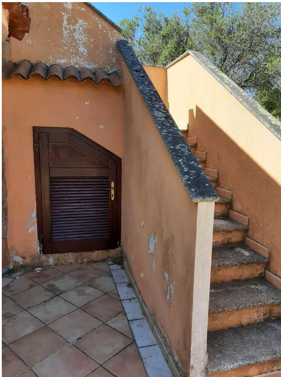
Foto 28: Locale lavatrice e deposito
