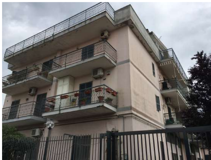
Vista del fabbricato
