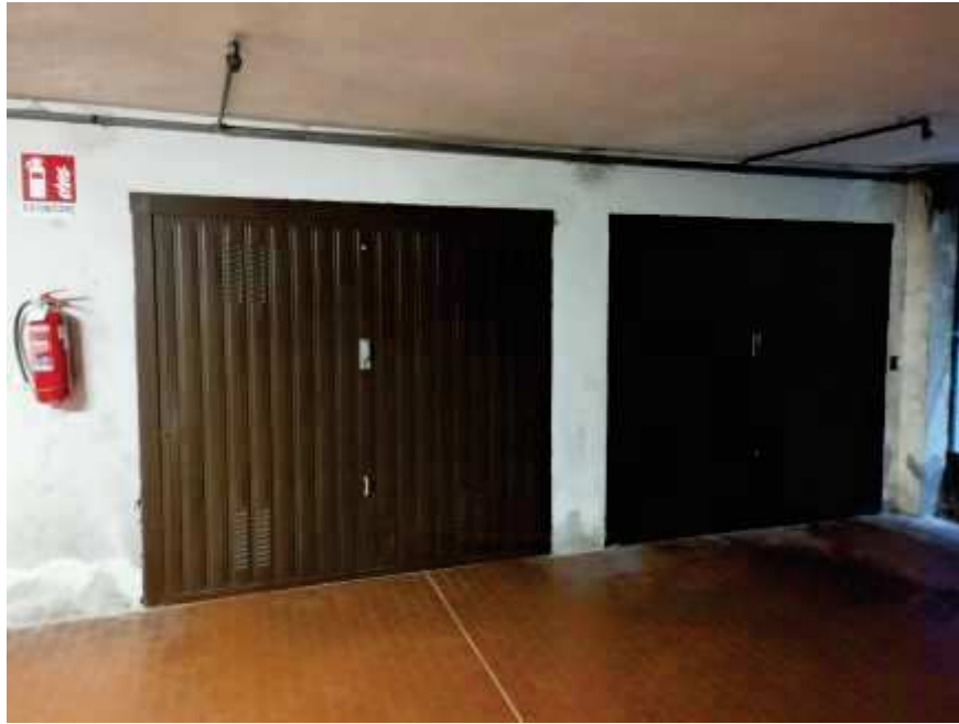
VISTA AUTORIMESSA DAL CORSELLO DI MANOVRA
