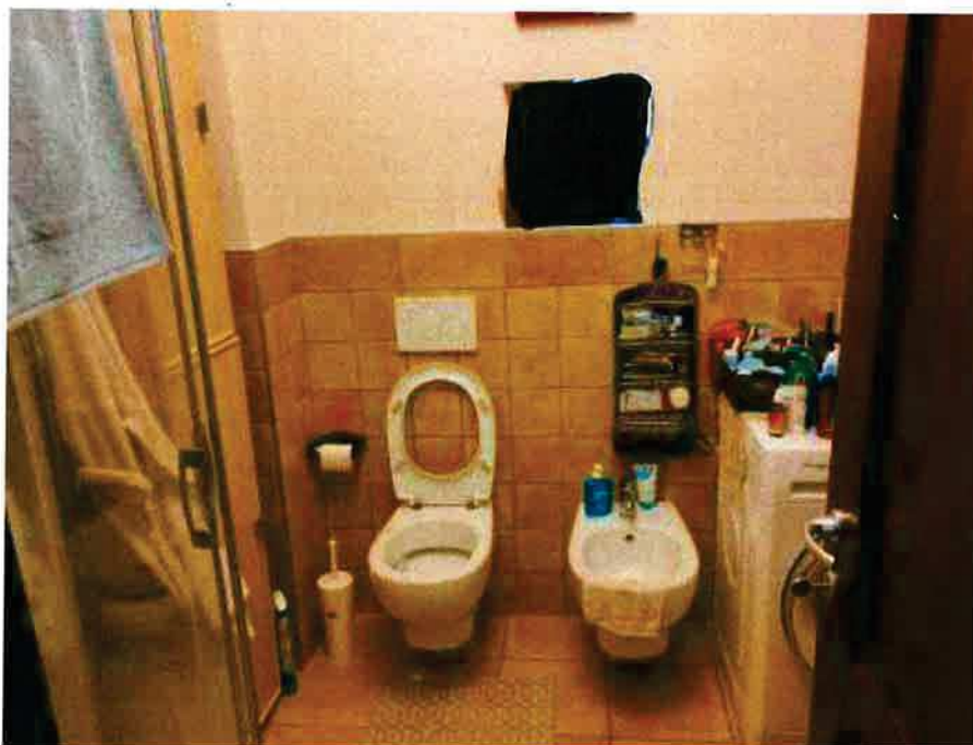
BAGNO ASPIRAZIONE FORZATA
