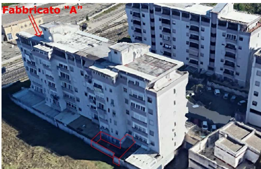
Ripresa Fabbricato "A" – Individuazione Unità Immobiliare Sub 239-240
