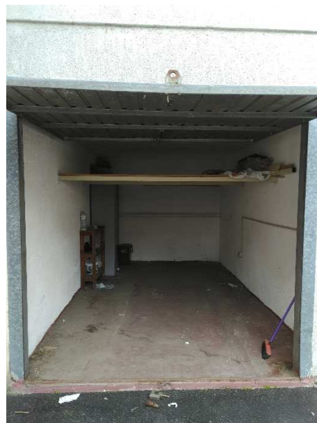
Vista interno Box
