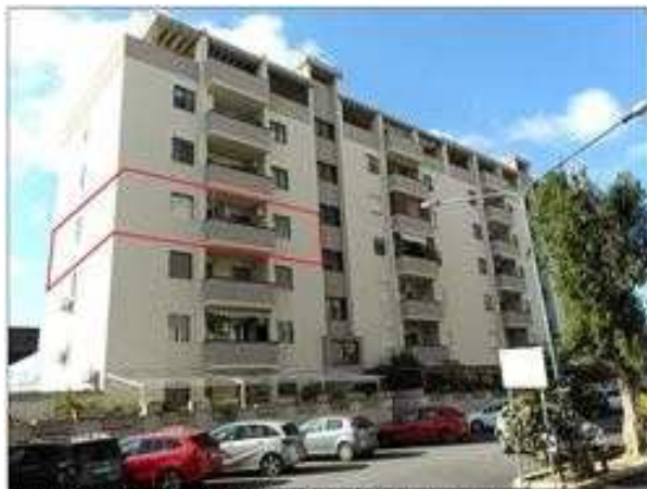
Ripresa N-E. Fabbricato "A" - Unità Immobiliare da cortile condominiale
