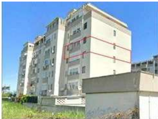
Ripresa S-W. Fabbricato "A" - Unità Immobiliare da Via Cappuccini
