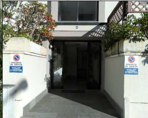
Ripresa ingresso Fabbricato "B" - Scala D
