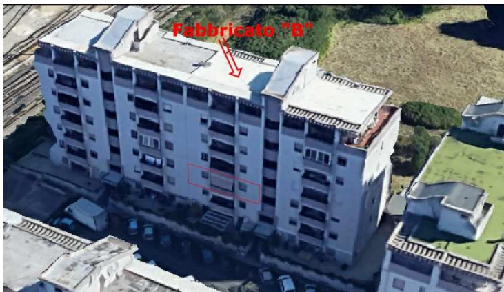
Ripresa Fabbricato "B" - In evidenza Unità Immobiliare Sub 239-240
