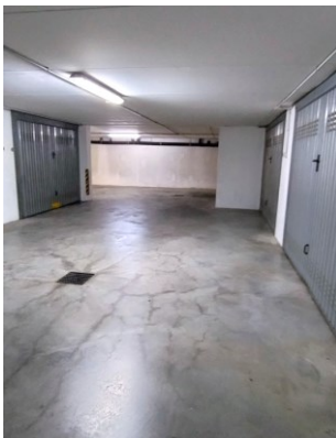
Vista interno autorimessa
