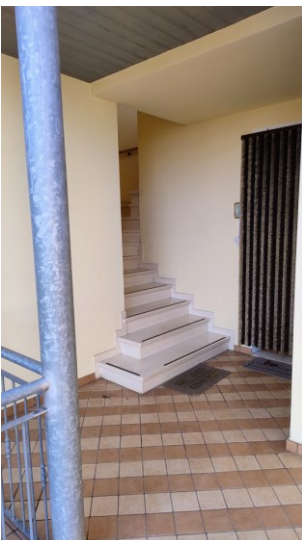
Accesso alle scale dalla corte al piano terra
