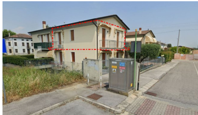
Fronte laterale vista sud-est
