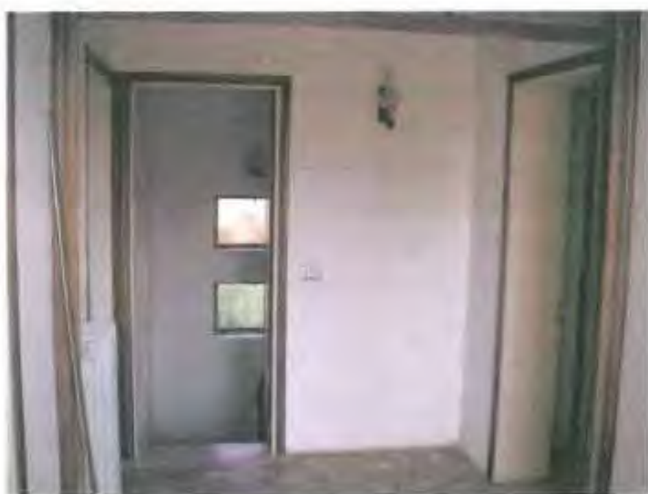
Vano scala al piano primo
