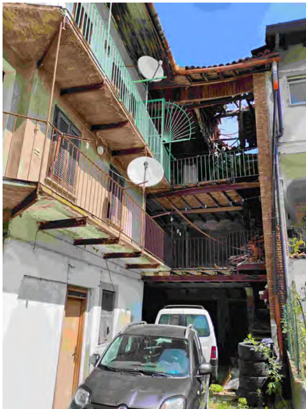
Dettaglio scala esterna
