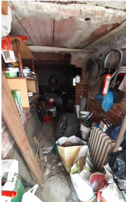
Vista interna - Locale di Sgombero - piano terra
