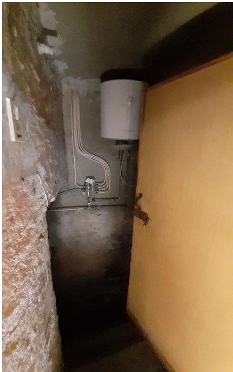
Vano scala di accesso alla cantina
