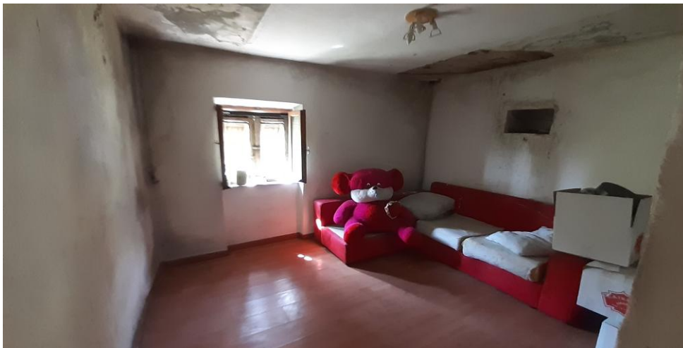
Vista interna - Camera
