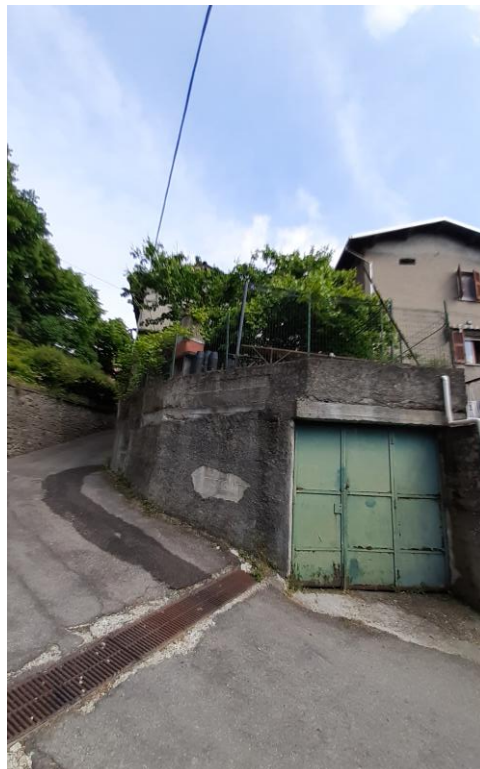
Vista generale dell'autorimessa
