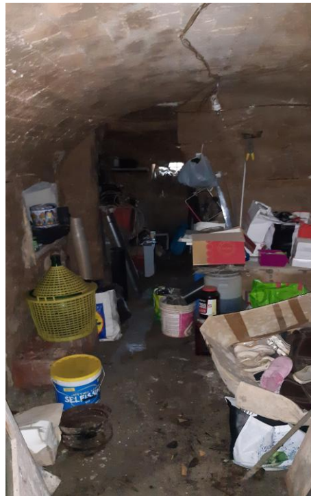
Cantina - piano seminterrato
