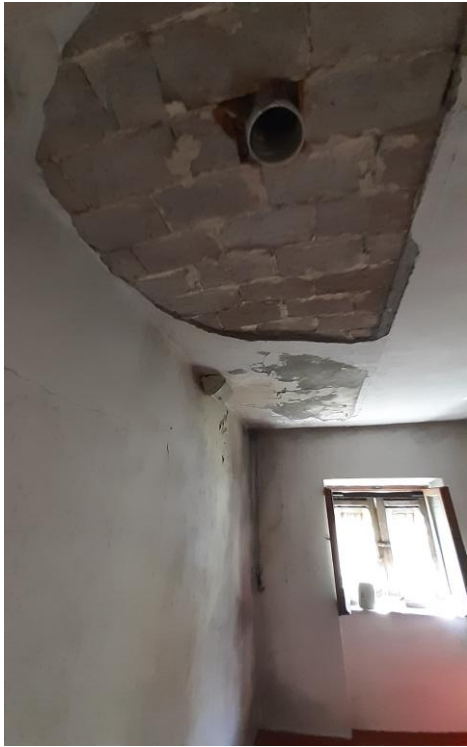
Vista interna - dettaglio soffitto
