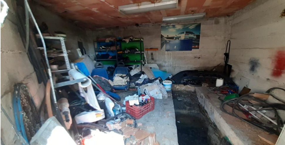
Vista interna - Autorimessa
