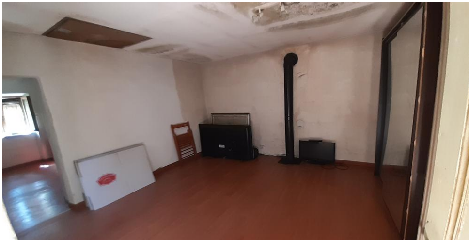
Vista interna - Camera
