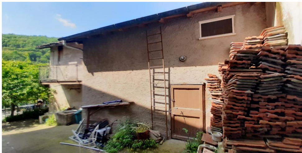
Vista esterna - Lato Corte
