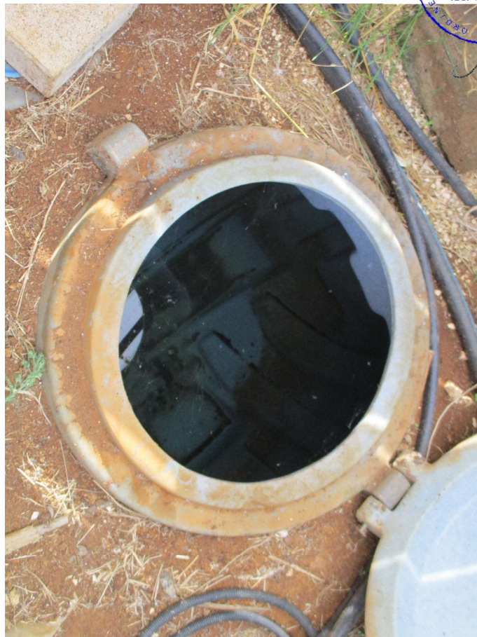
Foto 13 – Il deposito idrico interrato
