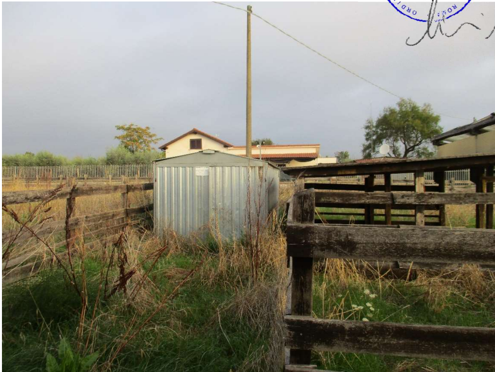
Foto 7 – Container in lamiera prefabbricata ancorato su basamento in cemento
