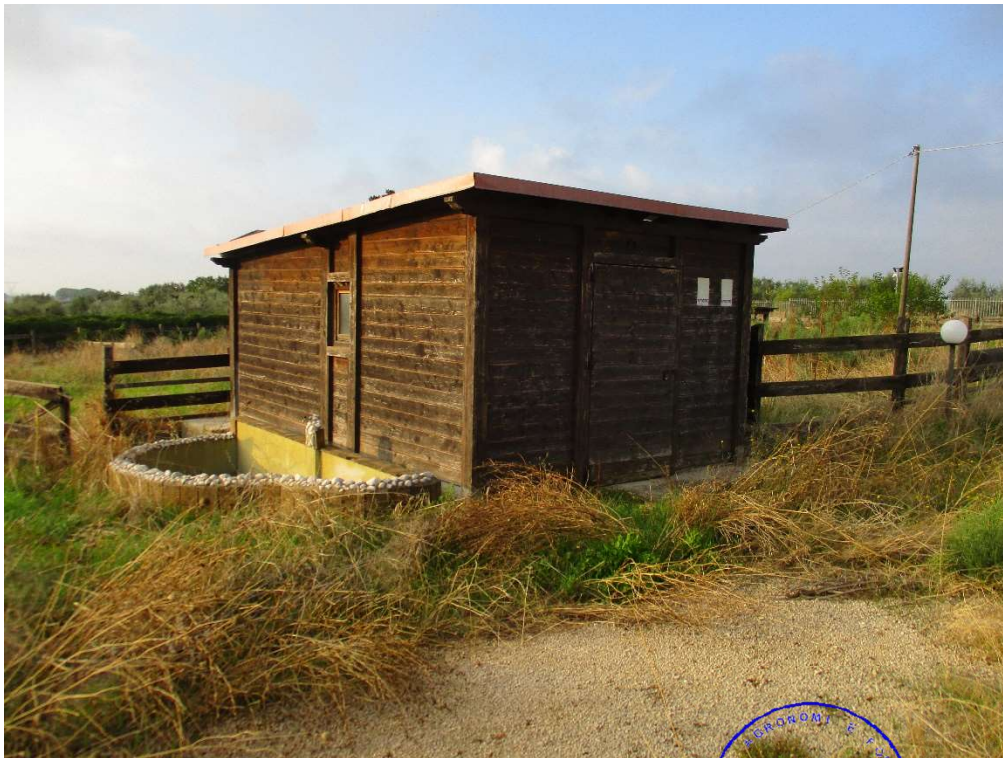
Foto 8 Container in legno ancorato su basamento in cemento
