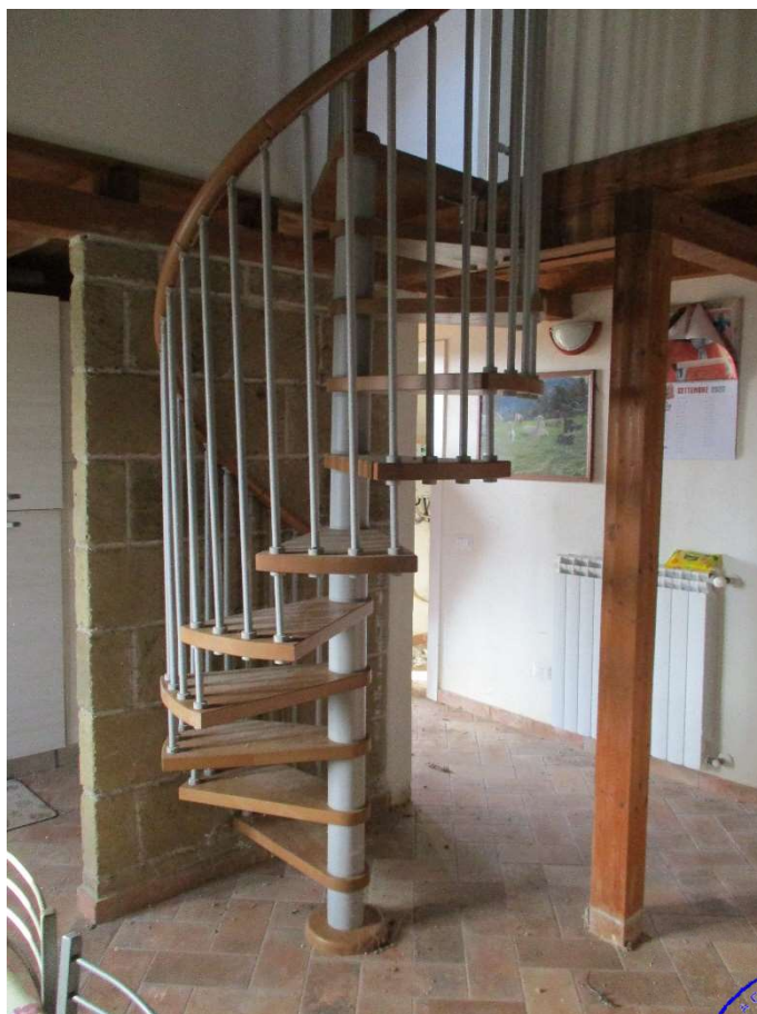
Foto 16 – Magazzino - La scala a chiocciola che conduce al soppalco
