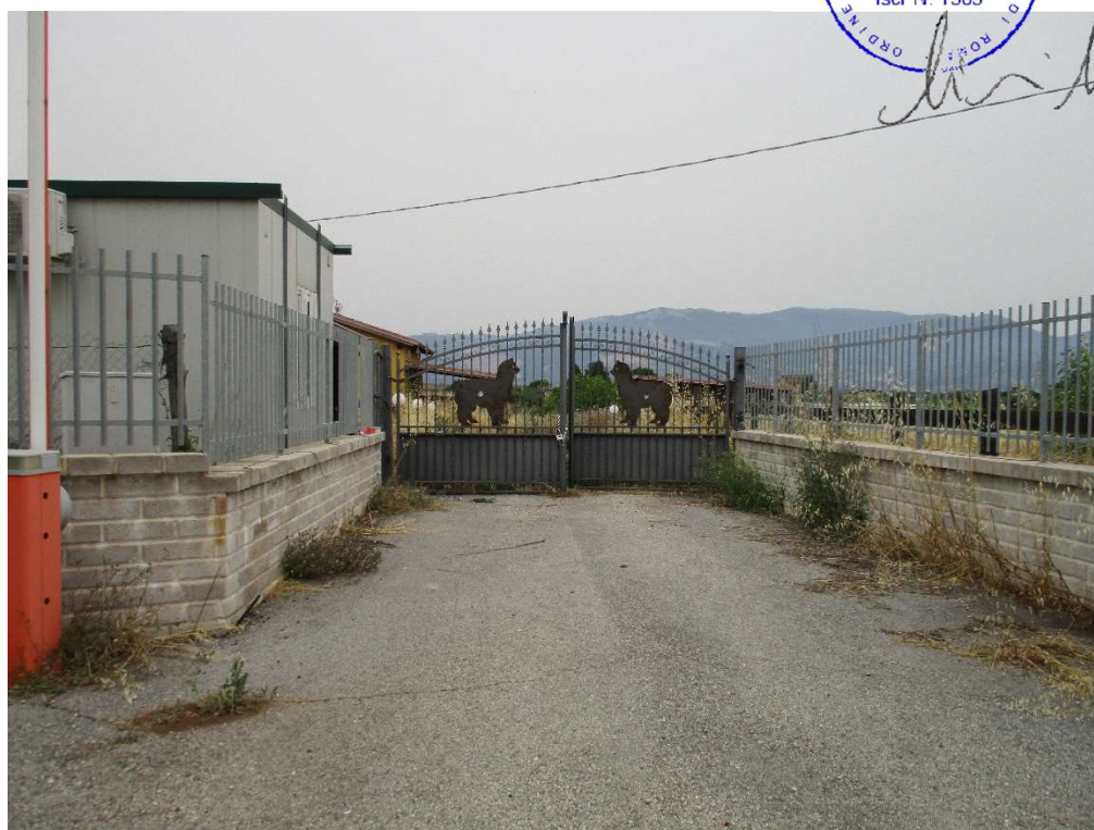
Foto 1 – Vista degli accessi (pedonale e carrabile) da Via dell’Ulivo Ginnetti 8 Velletri
