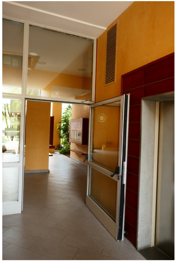
Foto 5 - Vista dell'ingresso dall'interno
