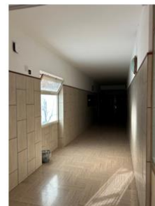
Foto n. 8 - Corridoio d'accesso del fabbricato
