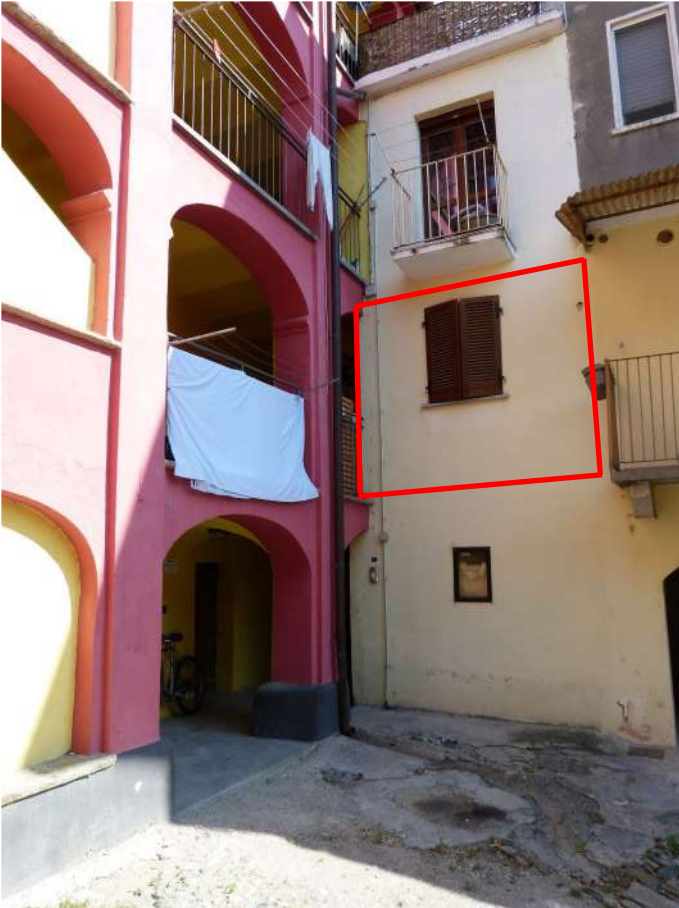
VISTA DA CORTILE INTERNO
