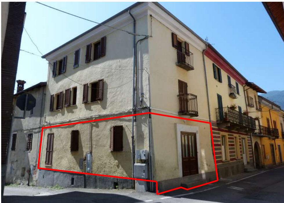
VISTA DA VIA MATTEOTTI
