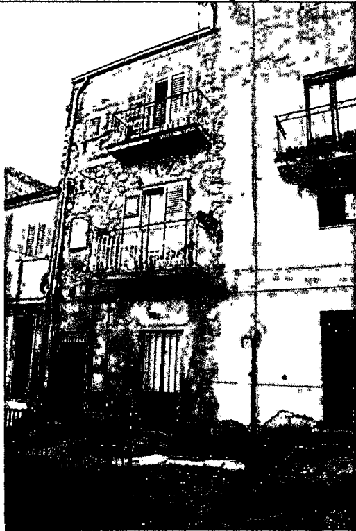
Foto n. 1 - Vista esterna – Via Casale
