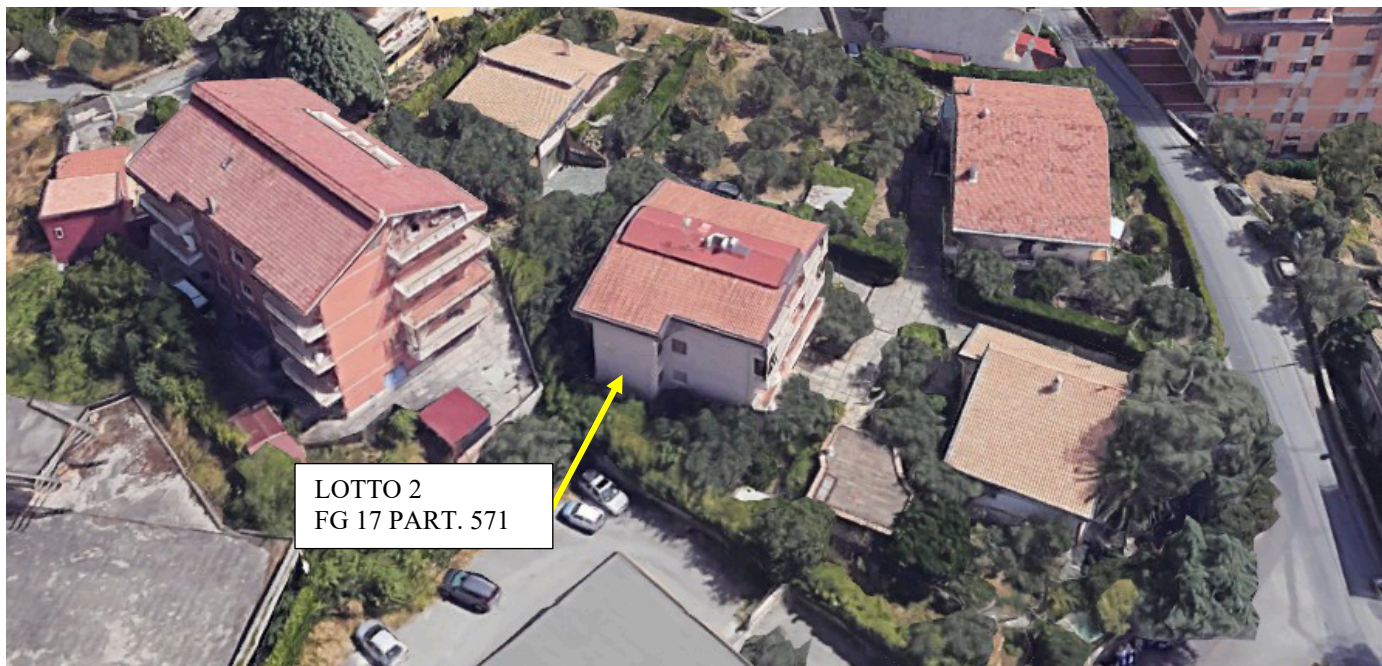
Fig. Foto aeree Fabbricato da Google Earth pro
