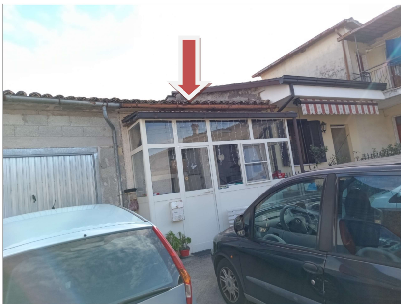
VISTA GENERALE PROSPETTO OVEST (zona ingresso)
