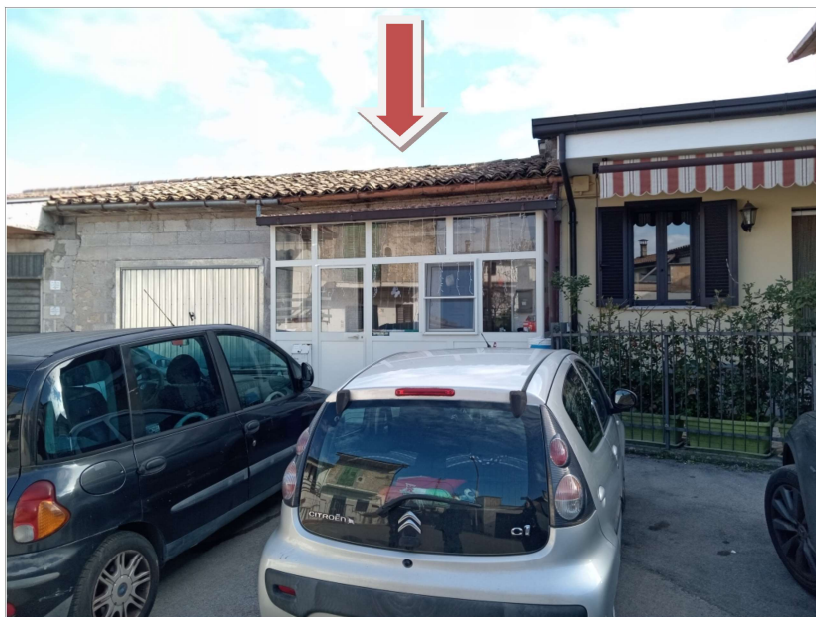
VISTA GENERALE PROSPETTO OVEST (zona ingresso)
