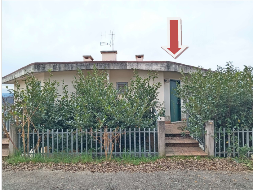
VISTA GENERALE PROSPETTO LATO NORD (zona accesso)
