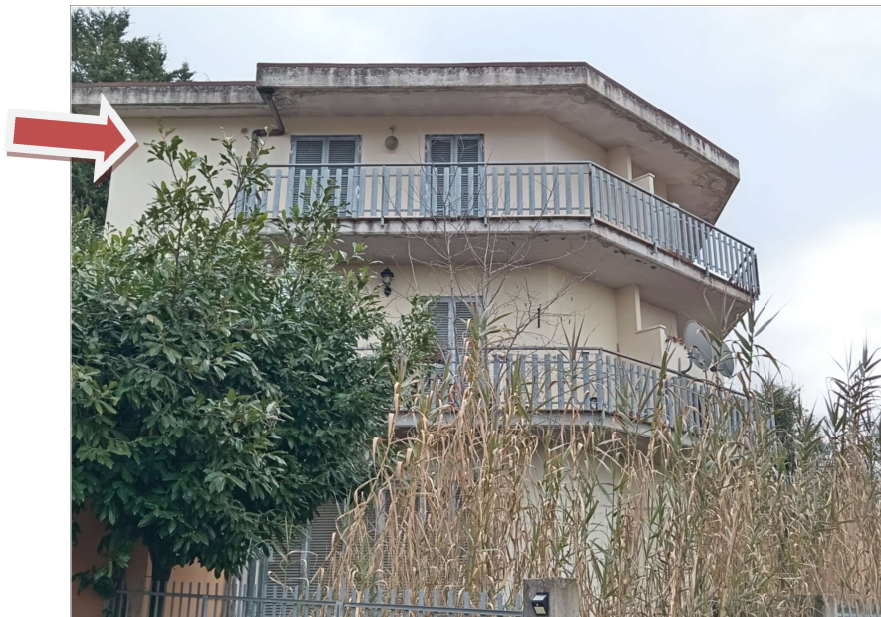
VISTA GENERALE PROSPETTO LATO SUD-OVEST
