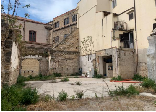
Foto 1 area in oggetto unità part.lla 839
