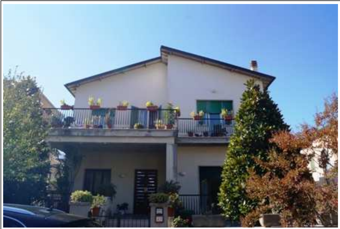
Foto prospetto nord
