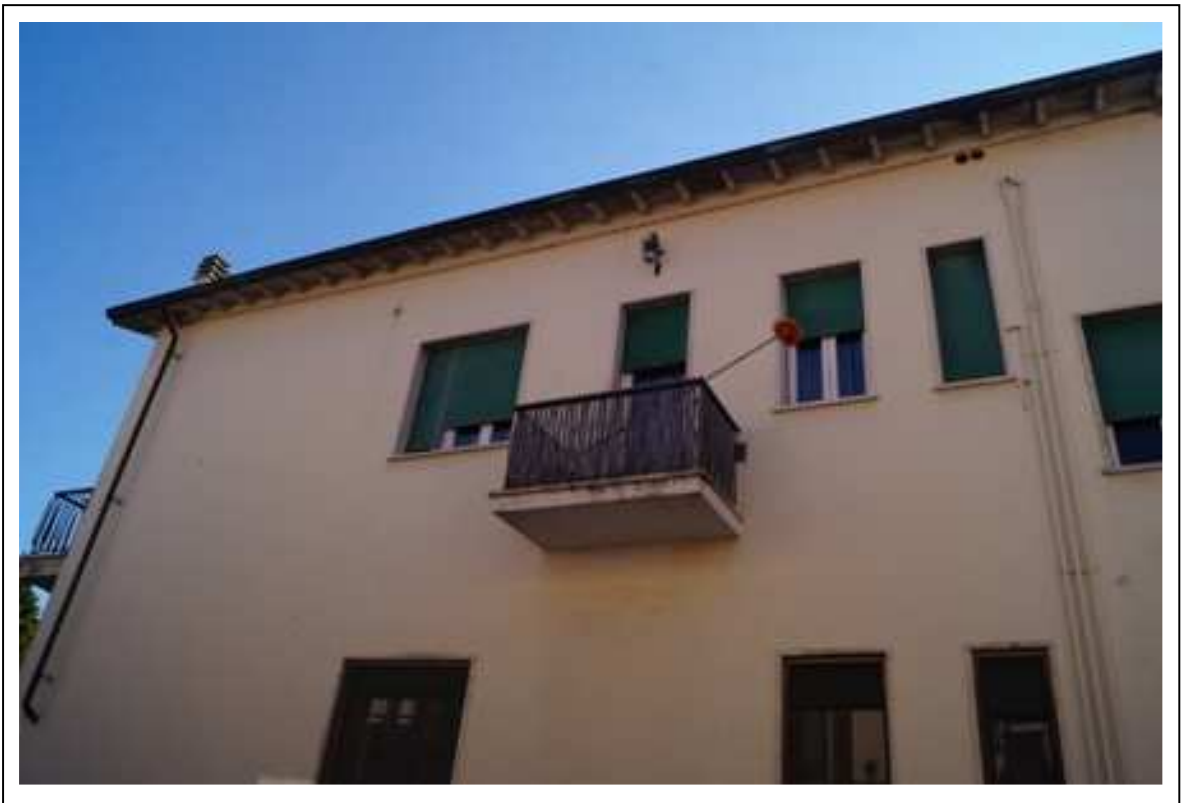
Foto prospetto ovest
