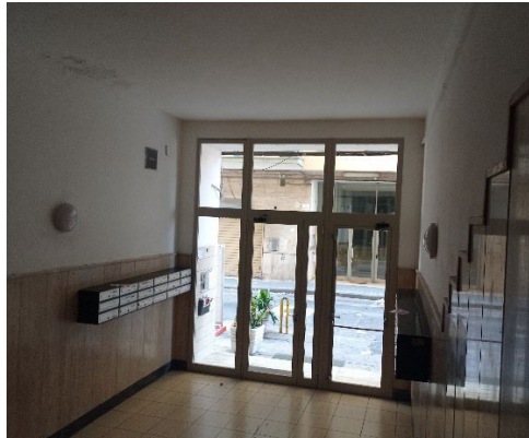
Portone ingresso - vista interna
