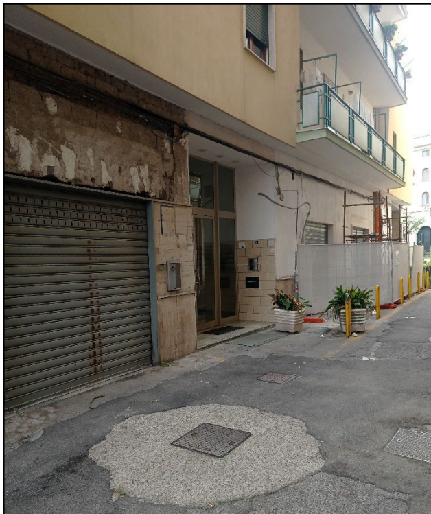
Ingresso dal viale comune
