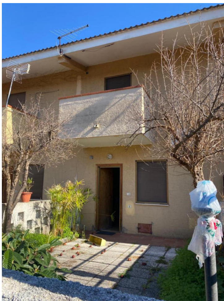
Foto 4: particolare facciata fabbricato – prospetto ovest
