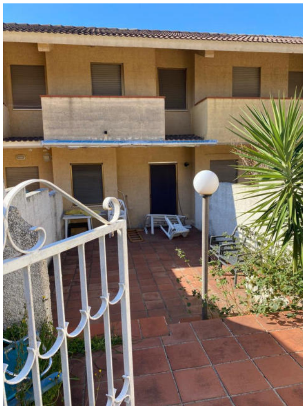
Foto 5: particolare facciata fabbricato – prospetto est
