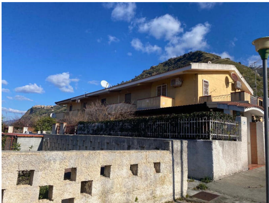
Foto 3: particolare facciata fabbricato – prospetto ovest
