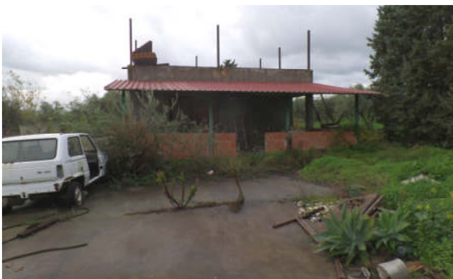
Foto n° 1.2. Villino: Prospetto Est
