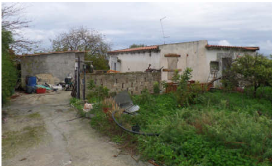
Foto n° 03. Abitazione e deposito: vista Ovest
