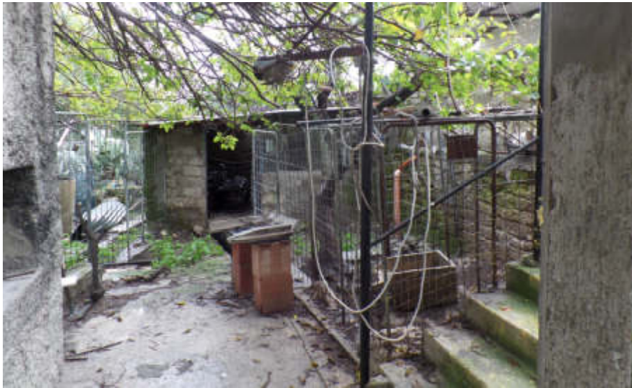
Foto n° 2.13. Piano Seminterrato: vista Nord
