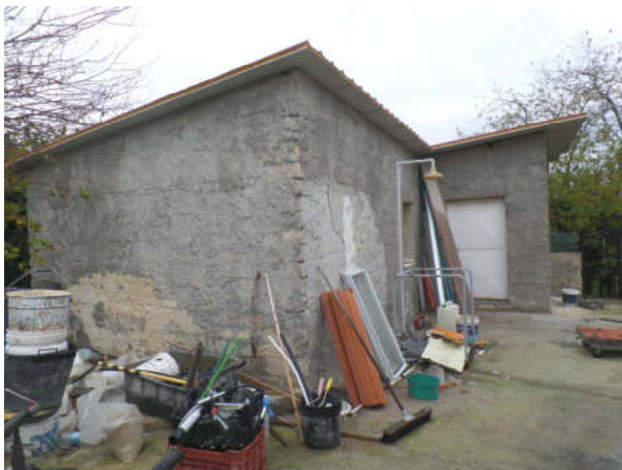
Foto n° 3.1. Locale di deposito: vista Ovest
