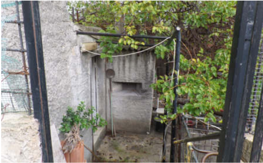
Foto n° 2.12. Piano Seminterrato: vista Ovest
